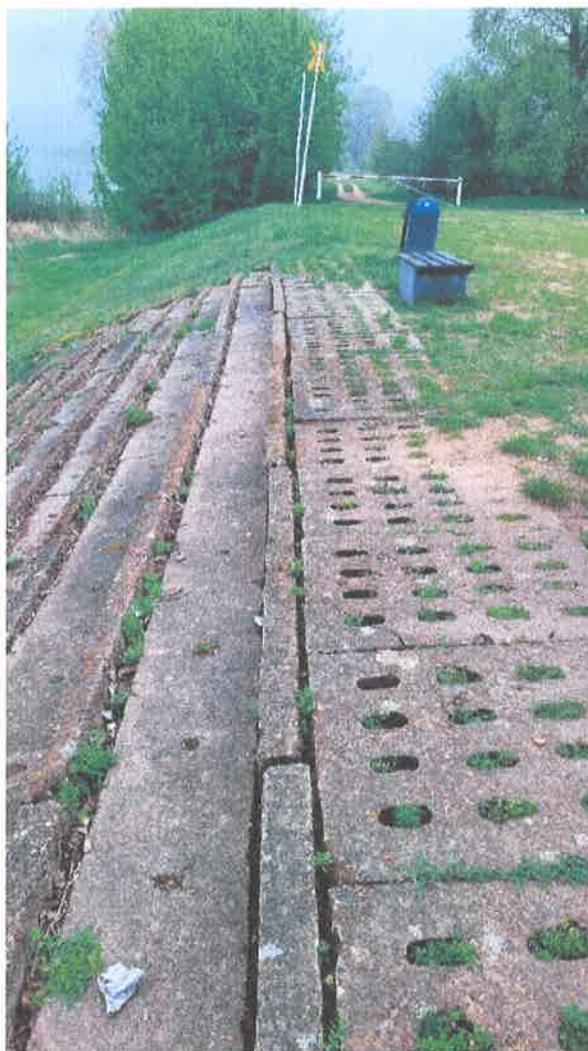
Fot.4 Płyty typu JUMBO na górze schodów
