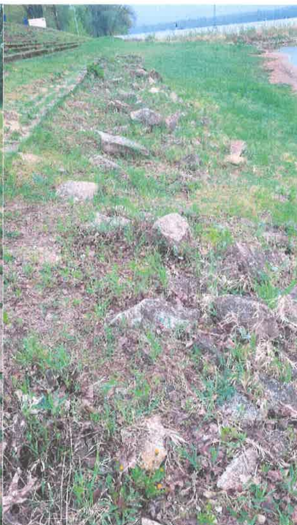
Fot.5 Umocnienie brzegu Wisły u dołu schodów
