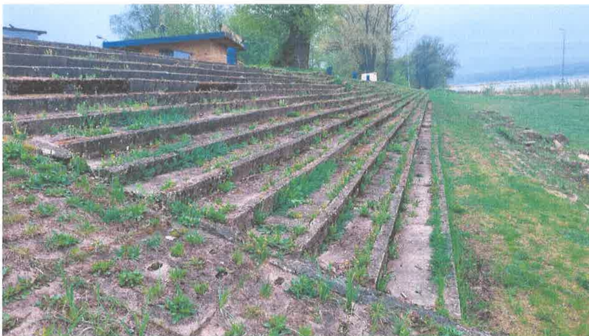
Fot.2 Widok schodów od strony wschodniej
