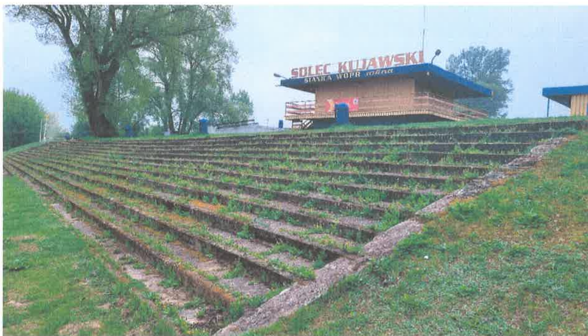
Fot.1 Widok schodów od strony zachodniej
