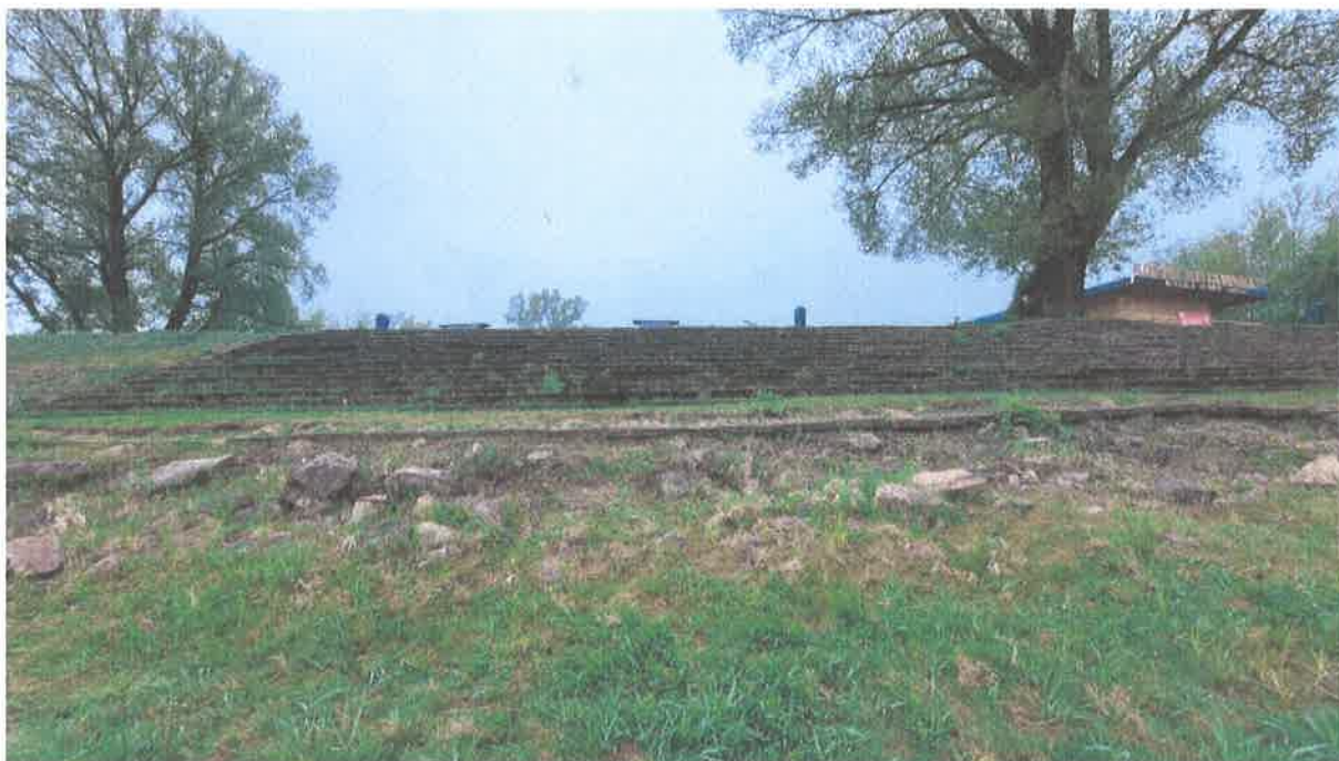
Fot.3 Widok schodów od strony rzeki Wisły
