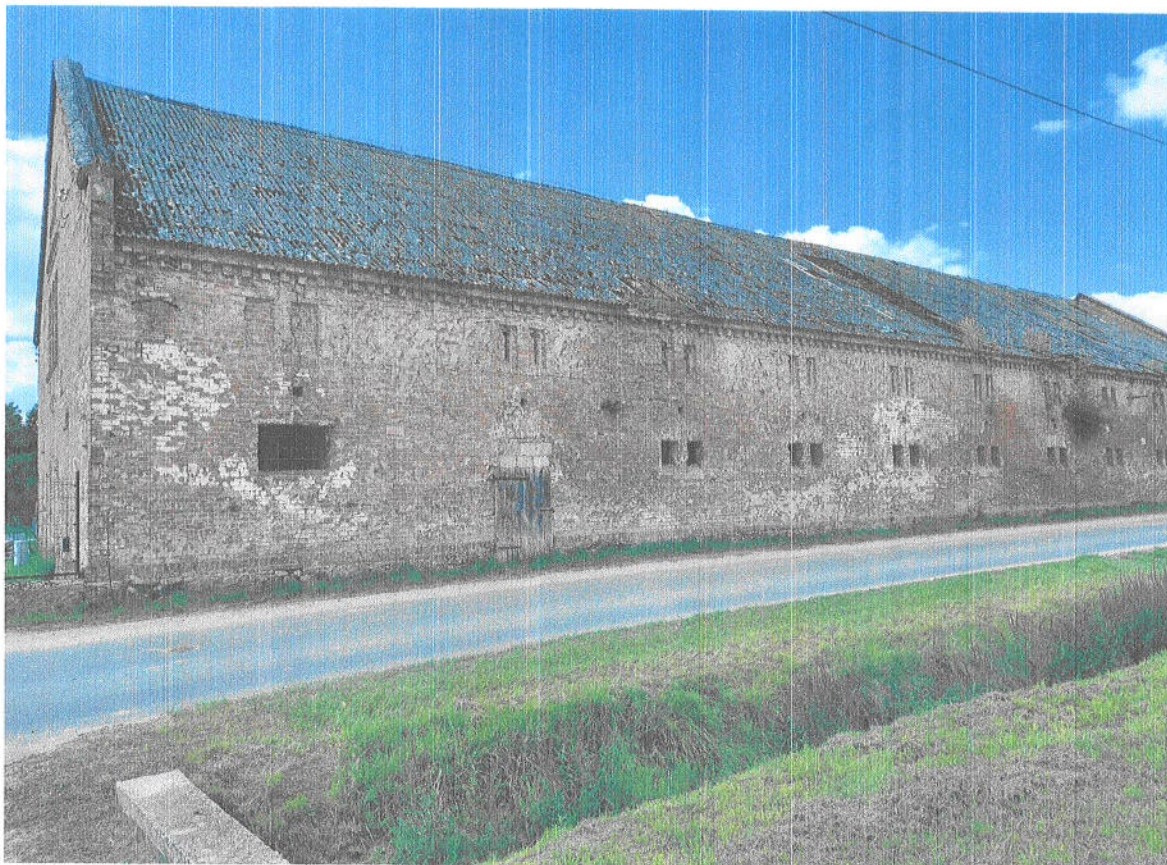
WIDOK ELEWACJI POŁUDNIOWO- WSCHODNIEJ
