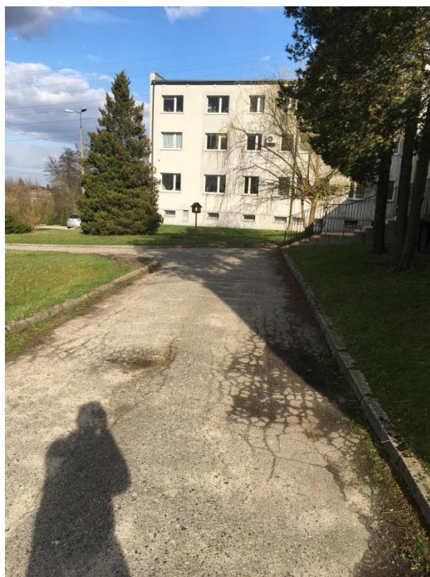
Zdjęcie 2) Zdegradowana nawierzchnia ze spękaniem siatkowym (zmęczeniowym) oraz wybojami i zaniżeniami
