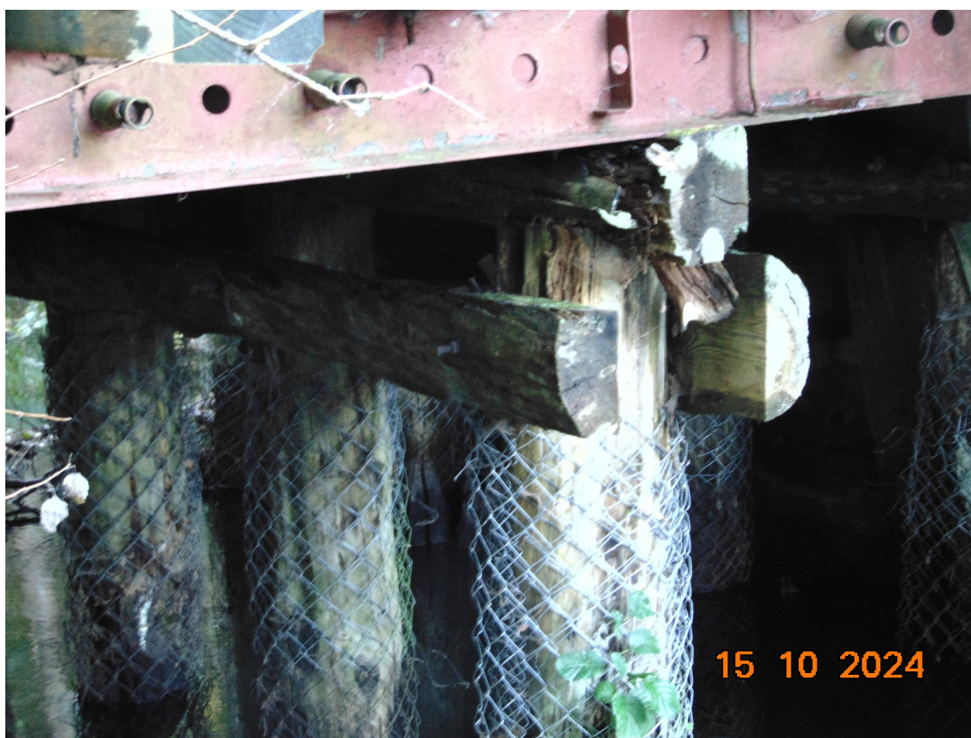
Fot. 12. Widok mostu z boku od strony dolnej wody
