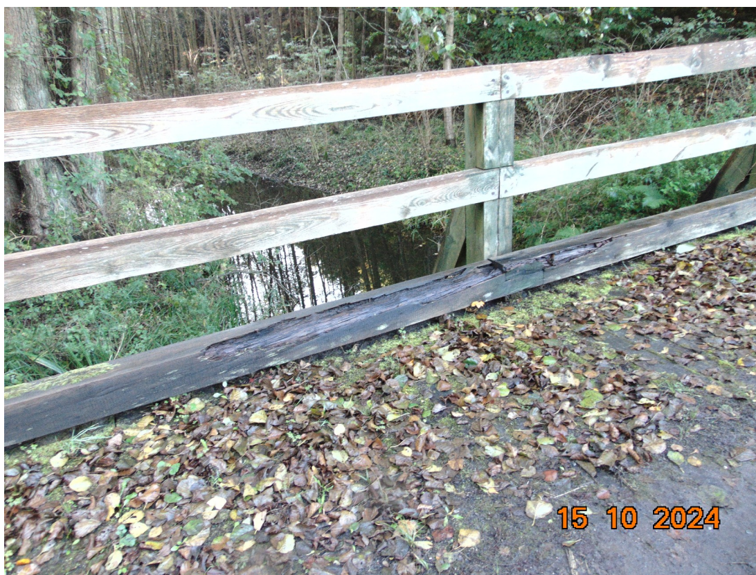
Fot. 7. Widok mostu z boku od strony górnej wody
