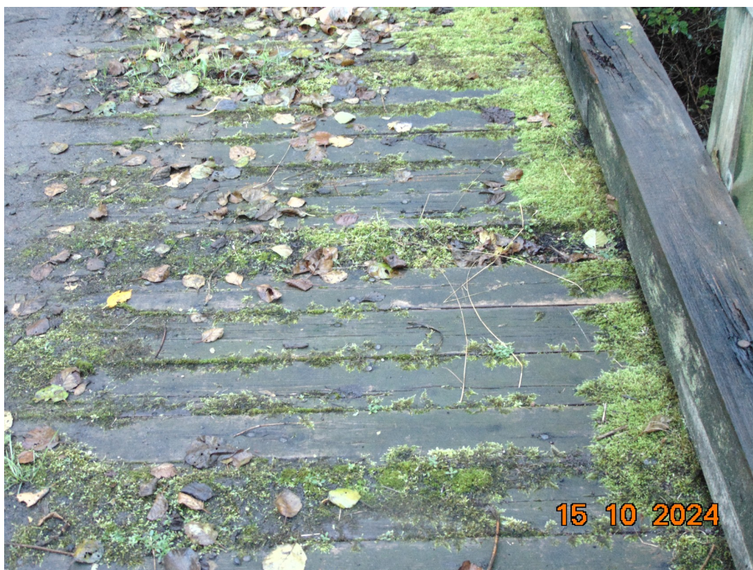
Fot. 4. Widok mostu z boku od strony dolnej wody
