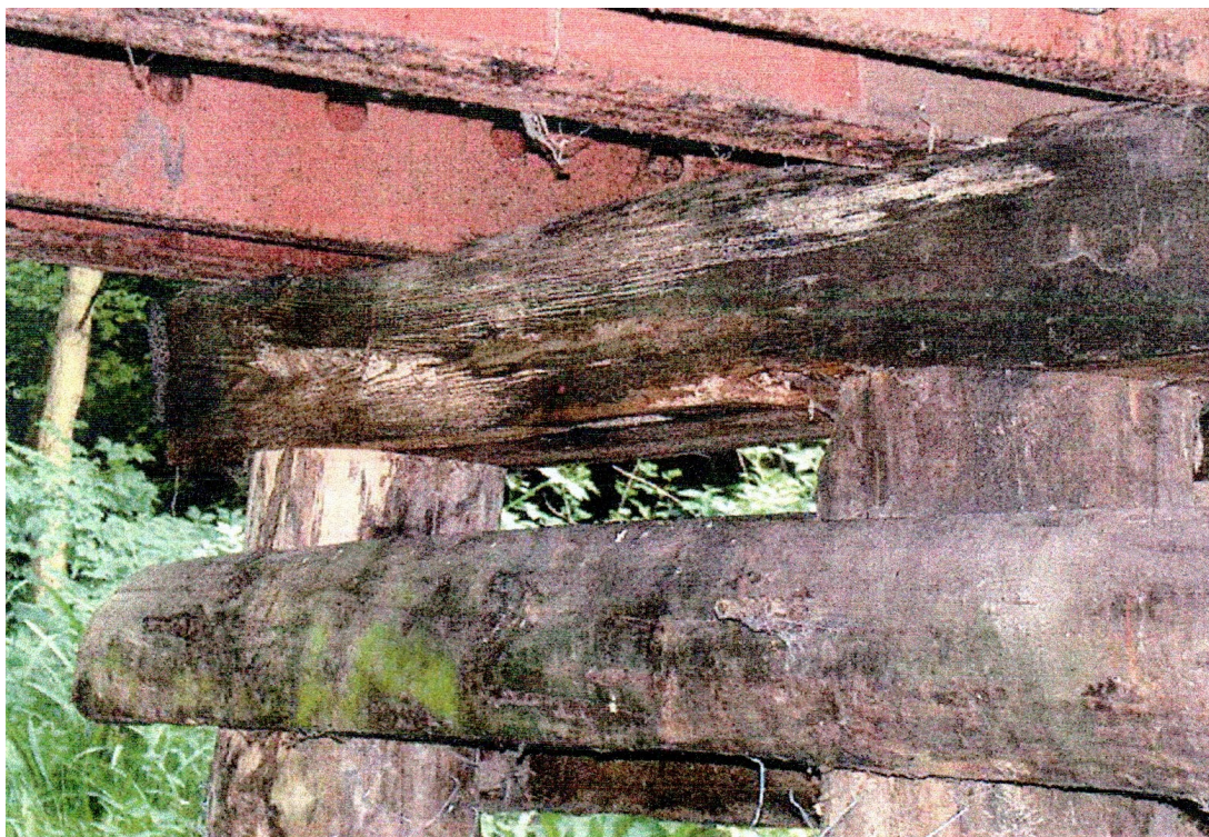
Fot. 27. Widok mostu z boku od strony górnej wody
