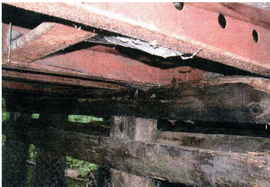
Fot. 26. Widok mostu z boku od strony dolnej wody
