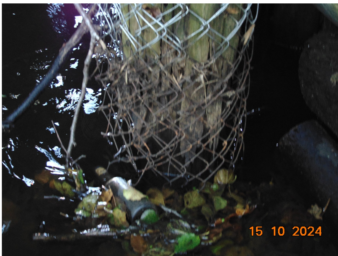
Fot. 10. Widok mostu z boku od strony dolnej wody
