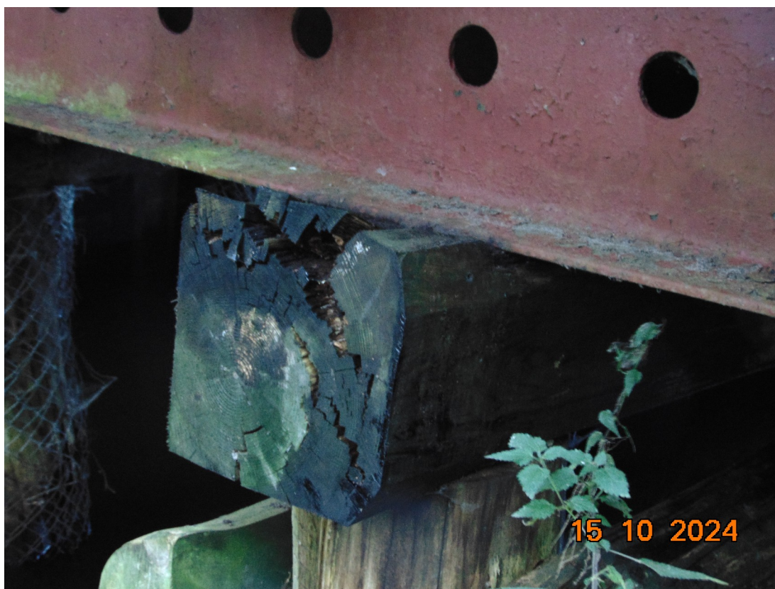
Fot. 9. Widok mostu z boku od strony górnej wody
