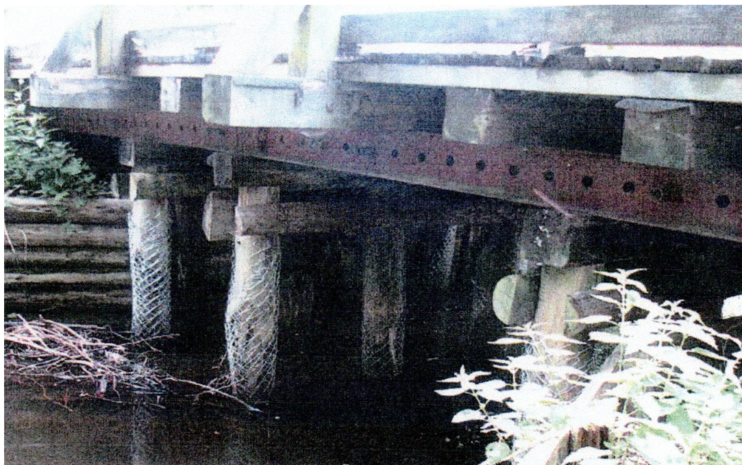
Fot. 1. Widok mostu z boku od strony górnej wody
