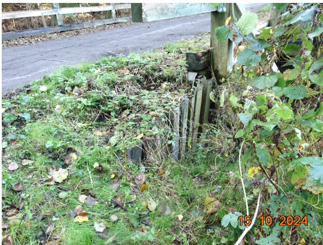
Fot. 23. Widok mostu z boku od strony górnej wody
