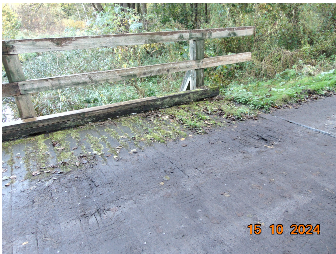
Fot. 5. Widok mostu z boku od strony górnej wody
