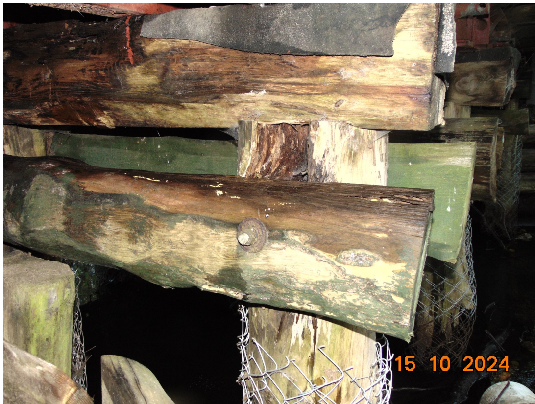
Fot. 17. Widok mostu z boku od strony górnej wody
