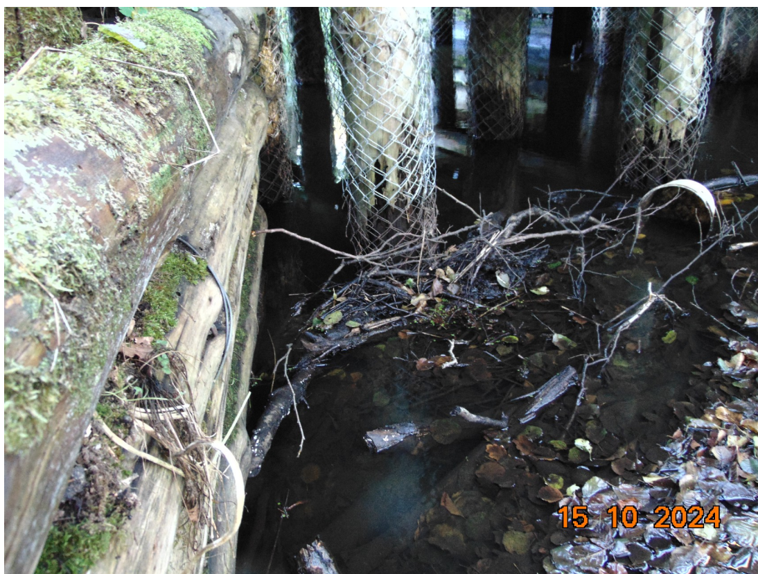
Fot. 15. Widok mostu z boku od strony górnej wody
