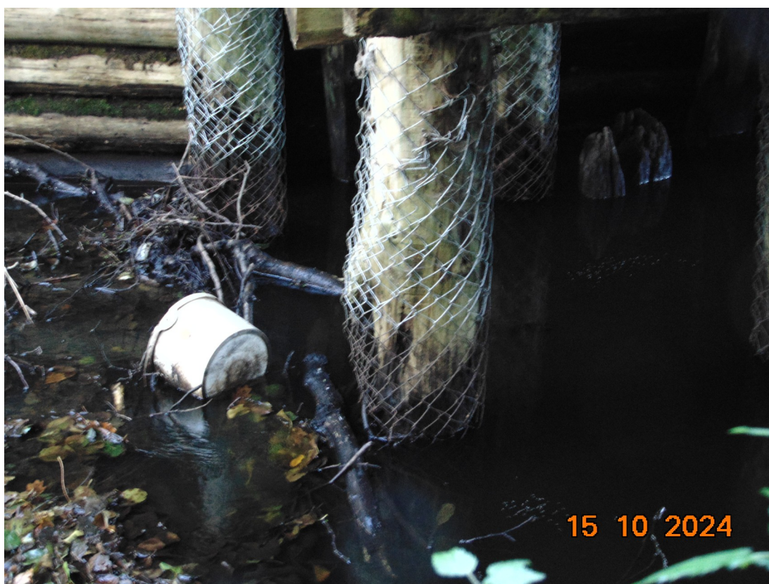
Fot. 8. Widok mostu z boku od strony dolnej wody
