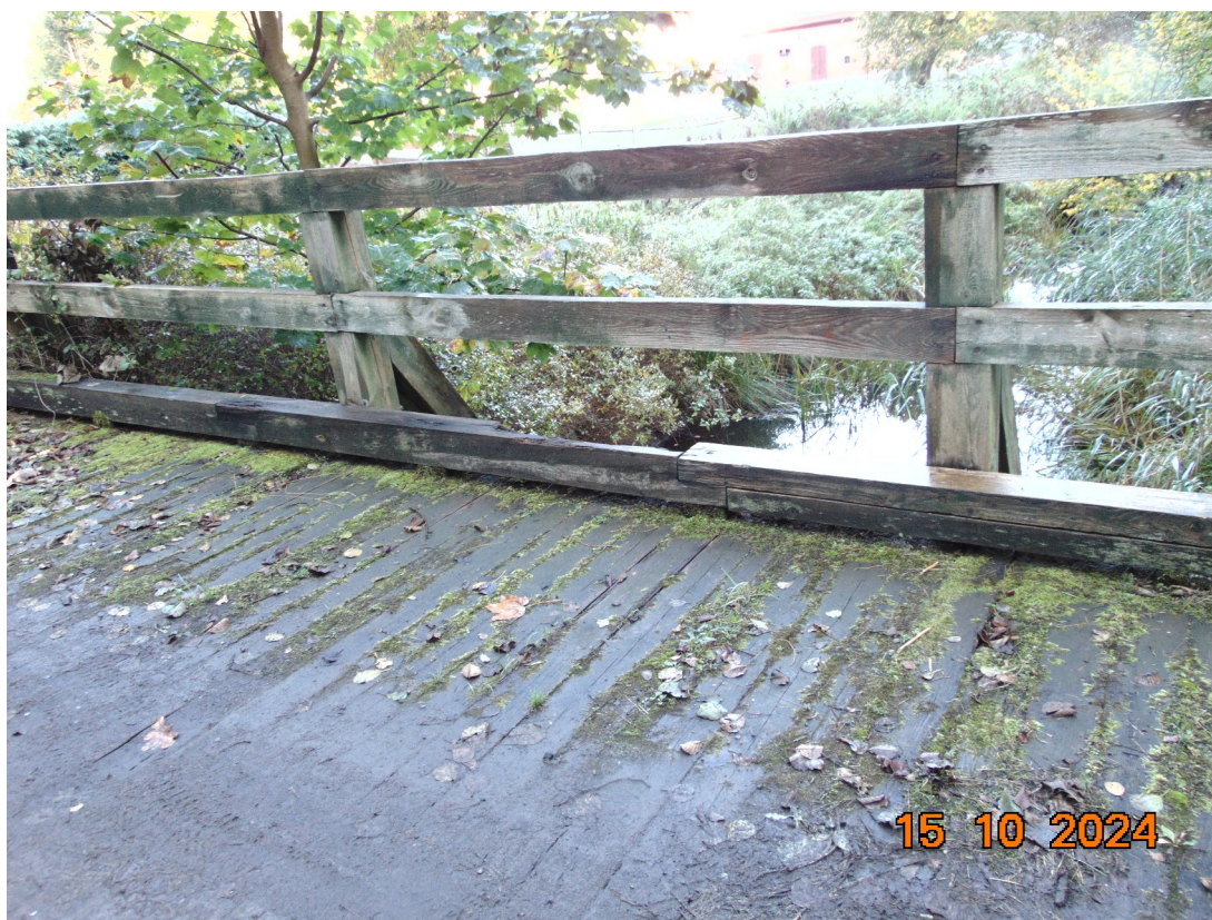
Fot. 6. Widok mostu z boku od strony dolnej wody
