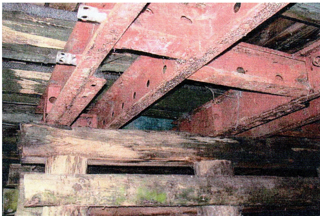
Fot. 30. Widok mostu z boku od strony dolnej wody
