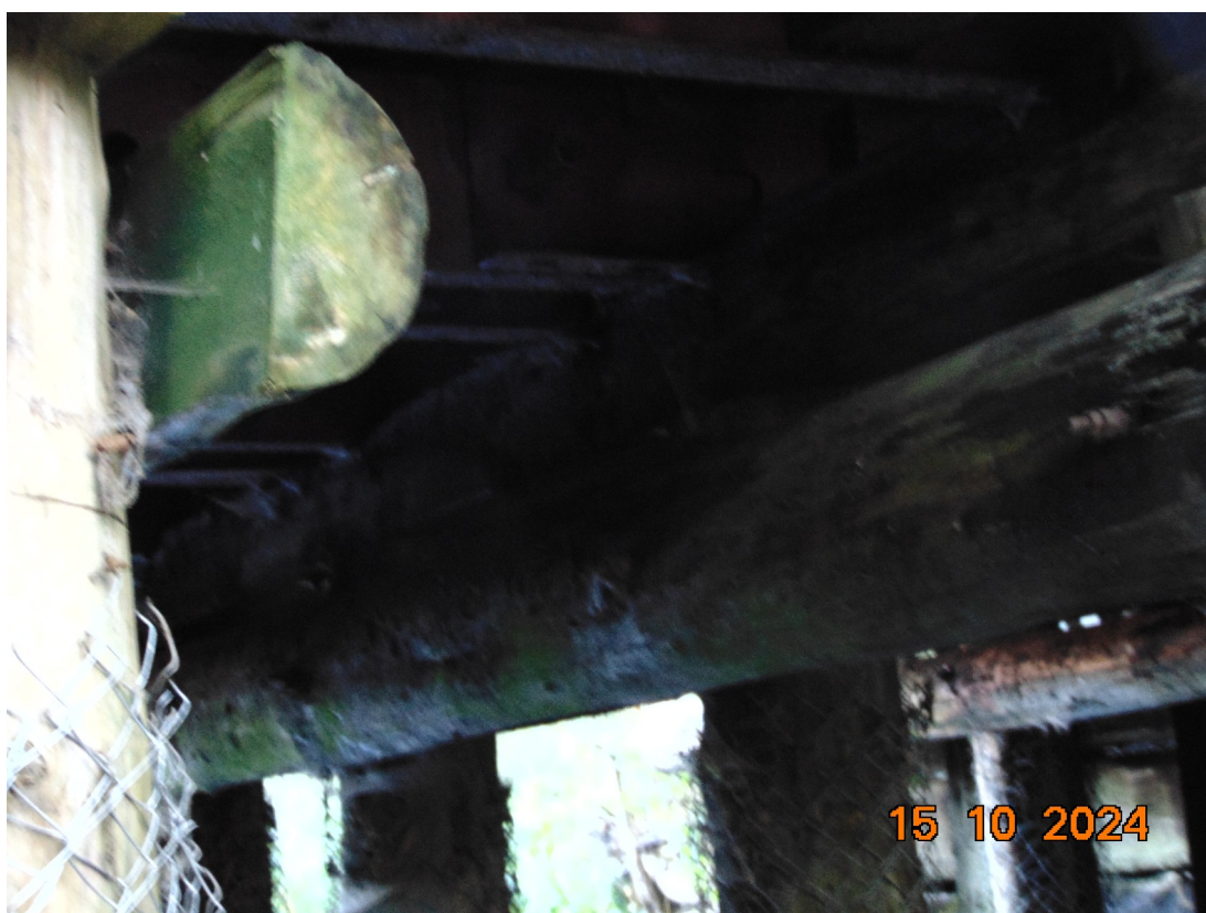
Fot. 22. Widok mostu z boku od strony dolnej wody
