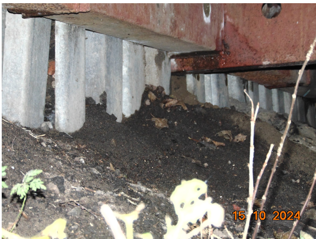
Fot. 16. Widok mostu z boku od strony dolnej wody
