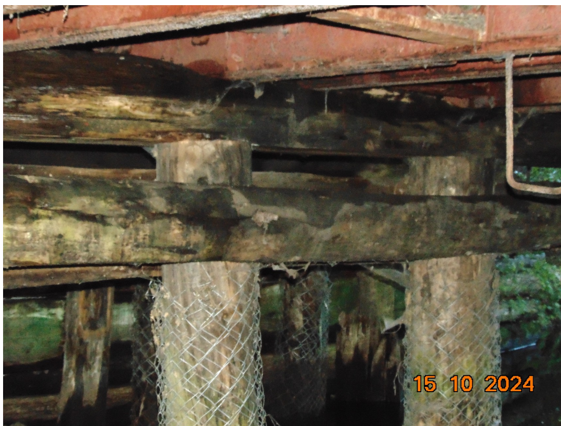
Fot. 11. Widok mostu z boku od strony górnej wody
