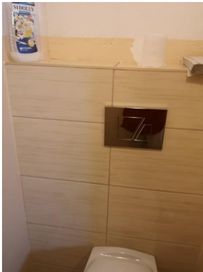
Pomieszczenie WC nr 12.
