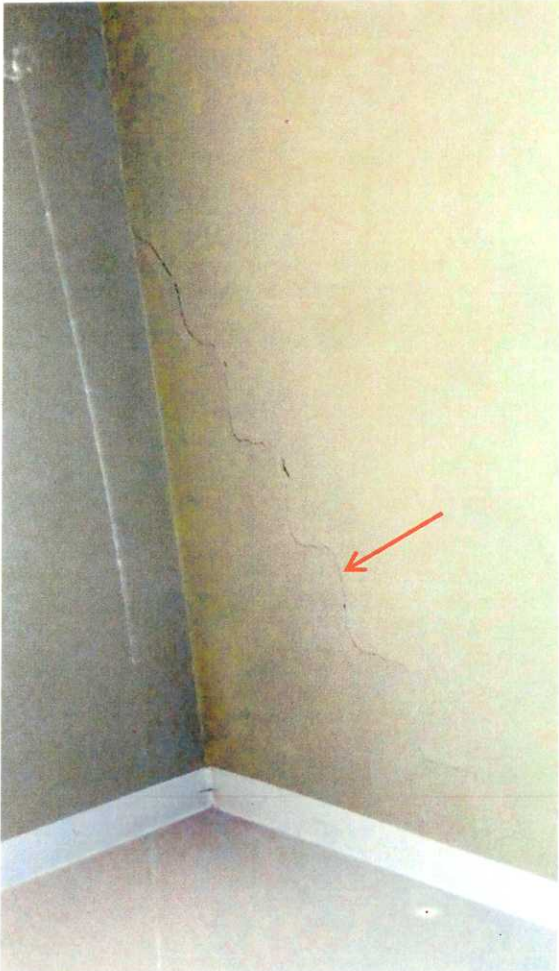
Fot. 5. Pęknięcie na styku filara prawego i ściany oraz krawędzi nadproża na 2 piętrze budynku
