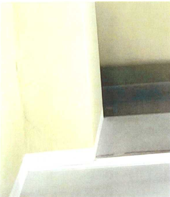
Fot. 5. Pęknięcie na styku filara prawego i ściany oraz krawędzi nadproża na 2 piętrze budynku
