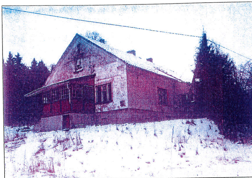
Widok elewacji budynku od strony północnej
