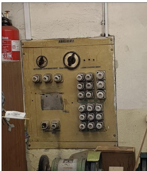
widok elewacji ist. Tablicy 1
