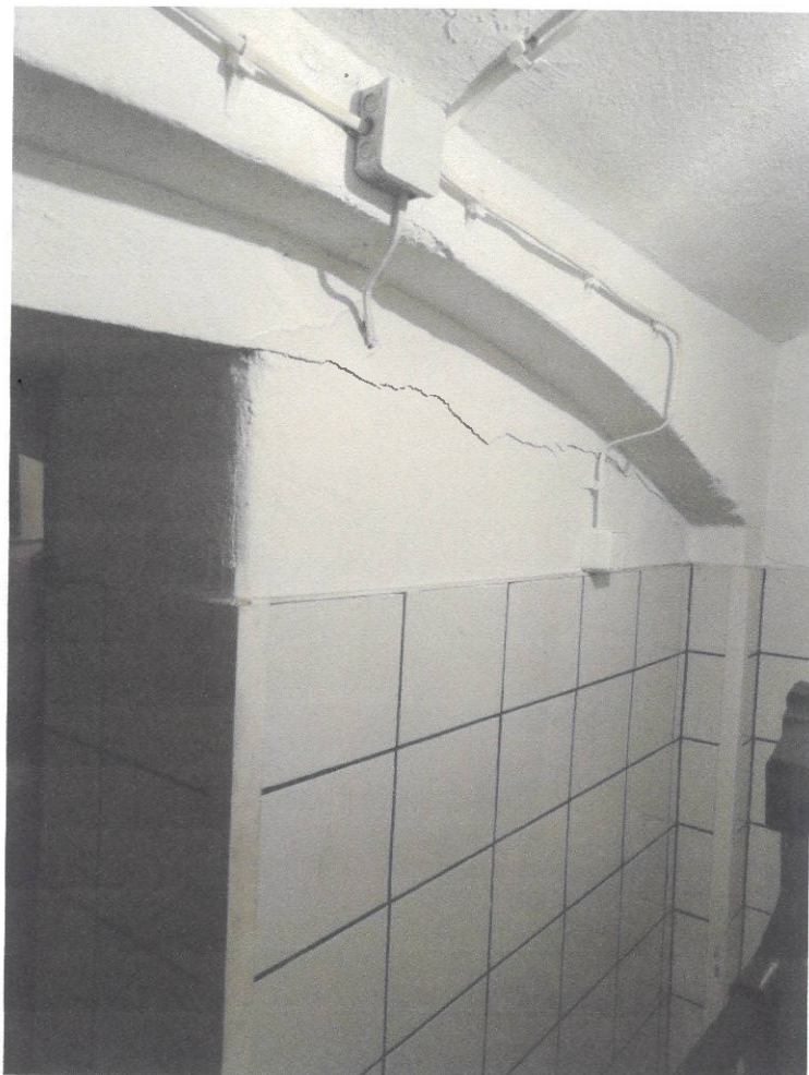
7. Przedśionek przed siłownią (widok w kierunku północno – zachodnim)
