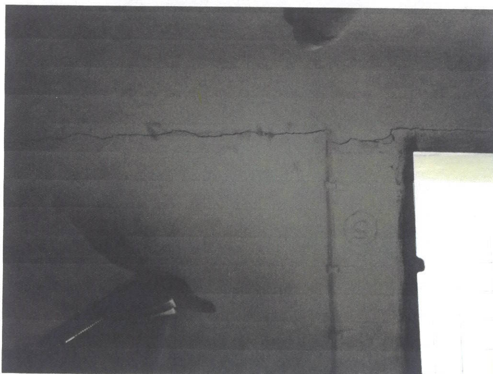
8. Drzwi w przejściu po przedśionka przed siłownią (widok w kierunku wschodnim)
