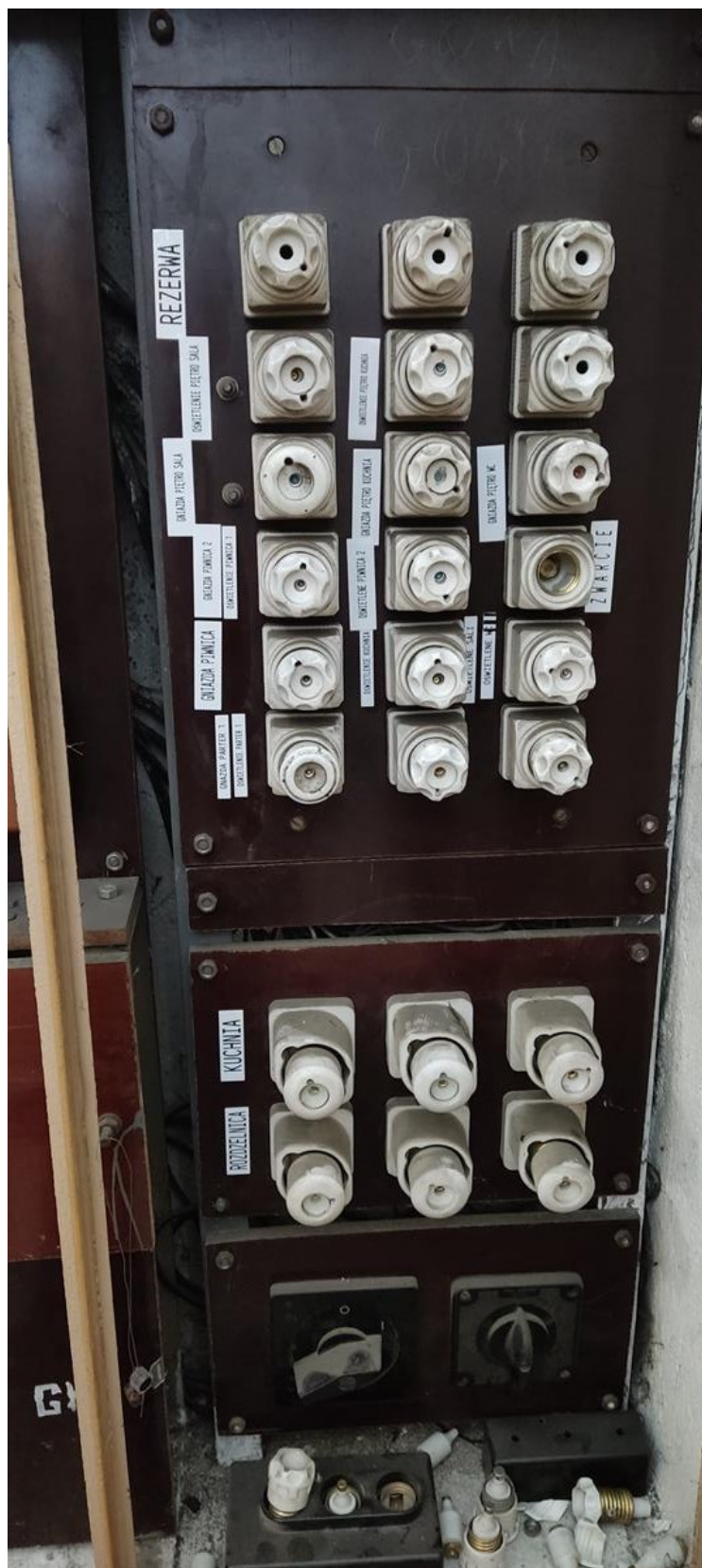
Rozdzielnica główna
