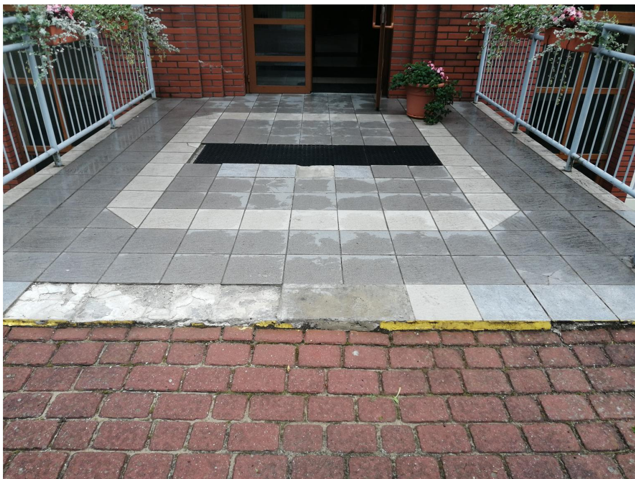
Fot. 1 Widok na płytki na podście
