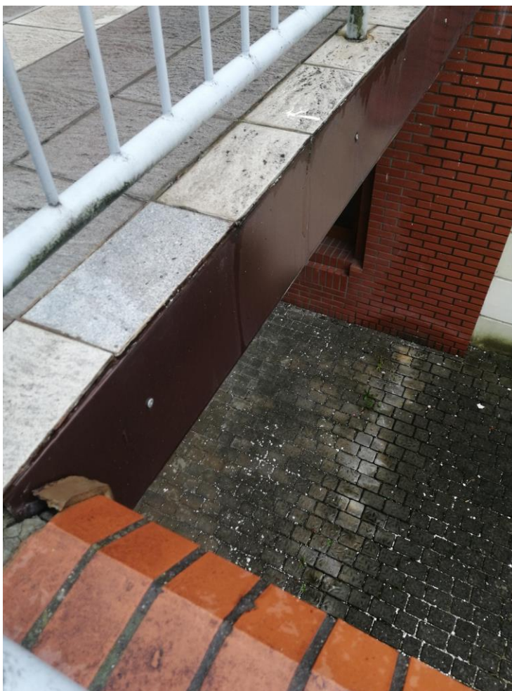
Fot. 2 Widok na obróbkę blacharską
