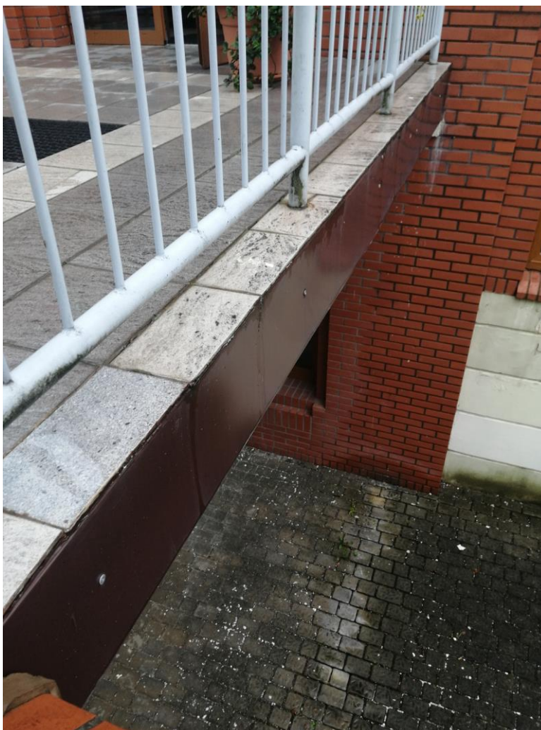
Fot. 4 Łącznik – widok na obróbkę blacharską i balustrady
