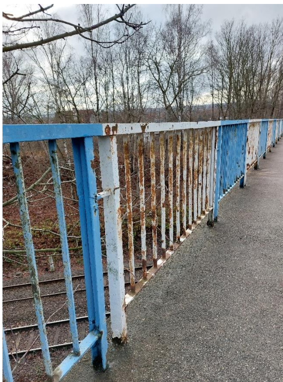
Fot. 9. Korozja balustrad. Uszkodzenie powłoki antykorozyjnej
