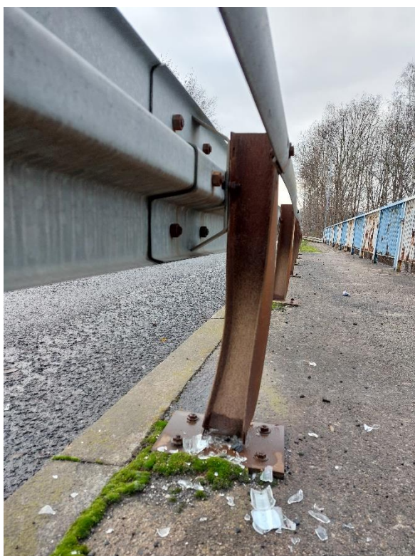
Fot. 10a 10b. Uszkodzenie mocowania i deformacja słupków balustrad.
