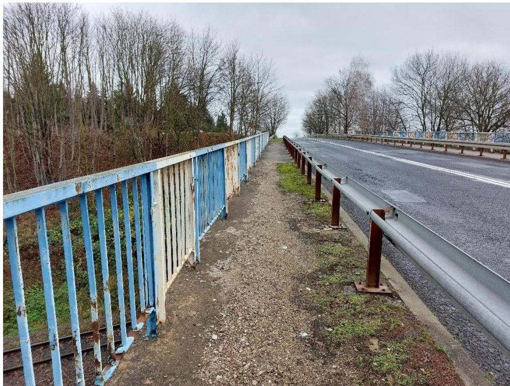
Fot. 13. Korozja nawierzchni chodnika. Wegetacja roślin. Skorodowane balustrady i słupki barier energochłonnych.
