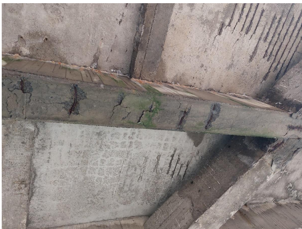
Fot. 2. Zawilgocenia dźwigarów i poprzecznic. Ubytki betonu otuliny, odspajająca się otulina betonu. Skorodowane pręty zbrojeniowe.
