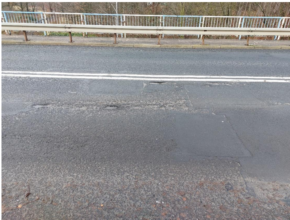
Fot. 11. Uszkodzenia nawierzchni jezdni (spękania, ubytki, korozja)
