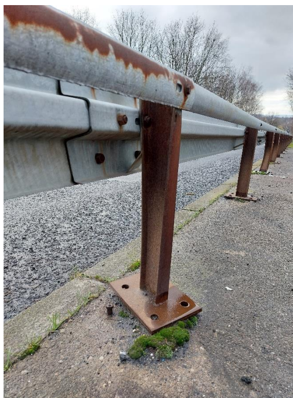
Fot. 10a 10b. Uszkodzenie mocowania i deformacja słupków balustrad.
