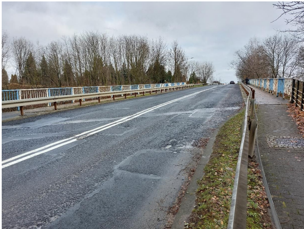
Fot. 14. Odształcenia taśmy barier energochłonnych.
