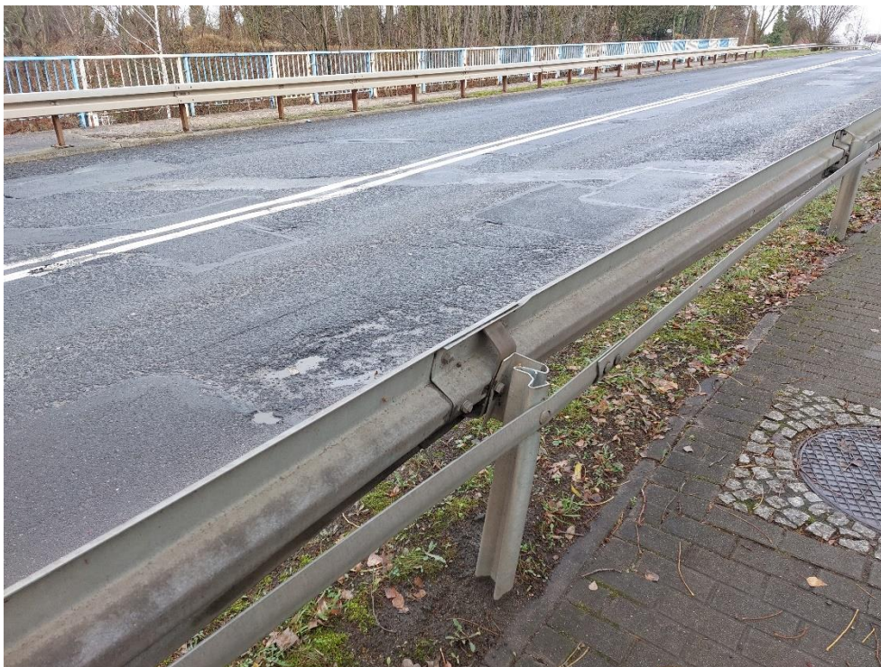
Fot. 12. Uszkodzenia nawierzchni jezdni (spękania, ubytki, korozja). Uszkodzony słupek bariery energochłonnej.
