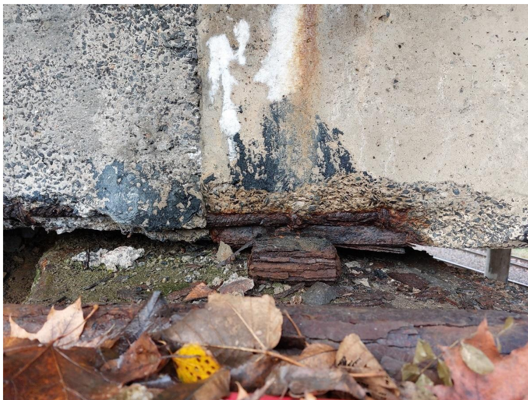
Fot. 4. Skorodowane łożyska. Zanieczyszczenia ław podłożyskowych. Ubytki betonu i wykwyty na dźwigarach.
