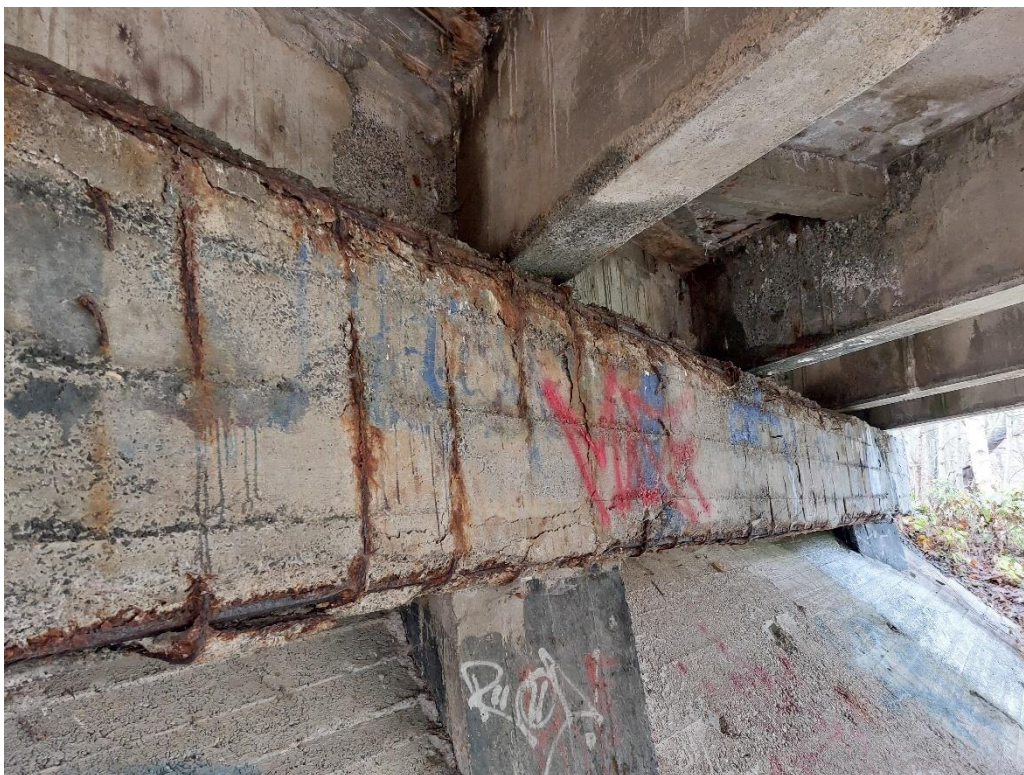
Fot. 3. Ubytki otuliny, korozja betonu i stali poprzecznic podporowych.
