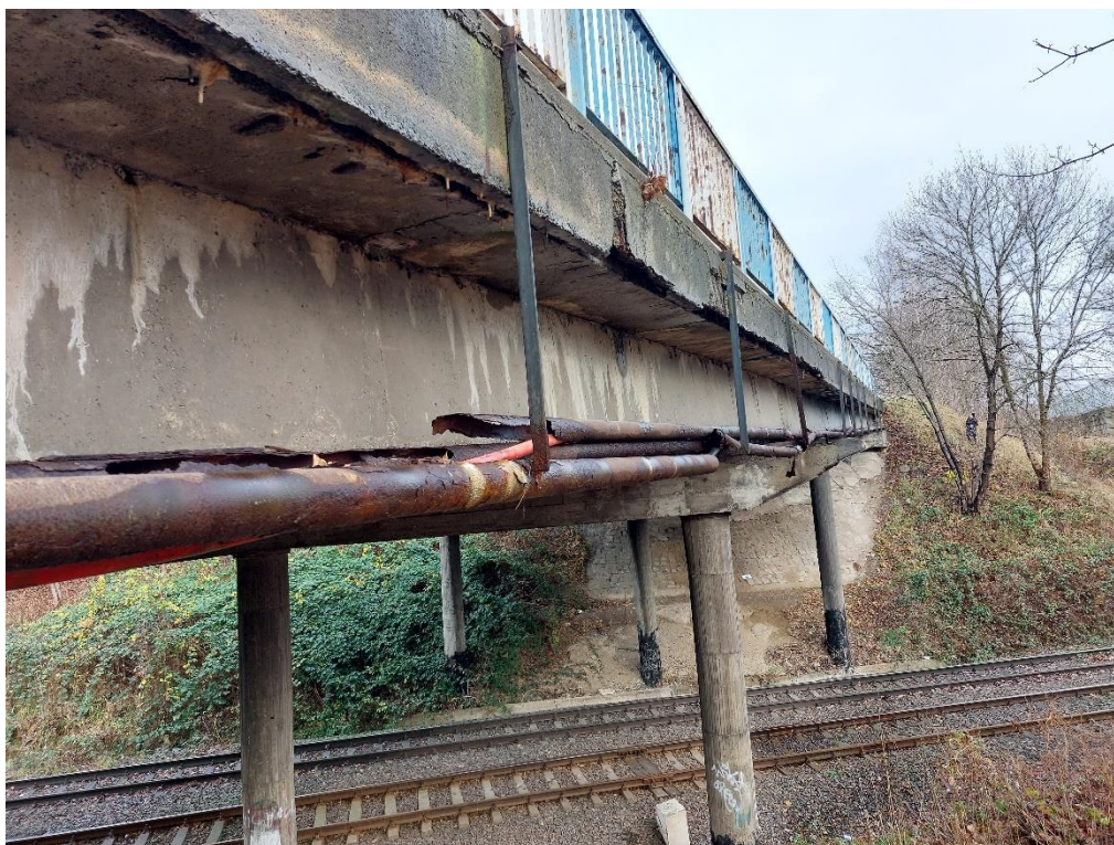
Fot. 5. Zacieki, zawilgocenia, wykwity na dźwigarach, wspornikach i gzymsach. Ubytki betonu na gzymsach. Uszkodzone i skorodowane rury osłonowe gestorów sieci.
