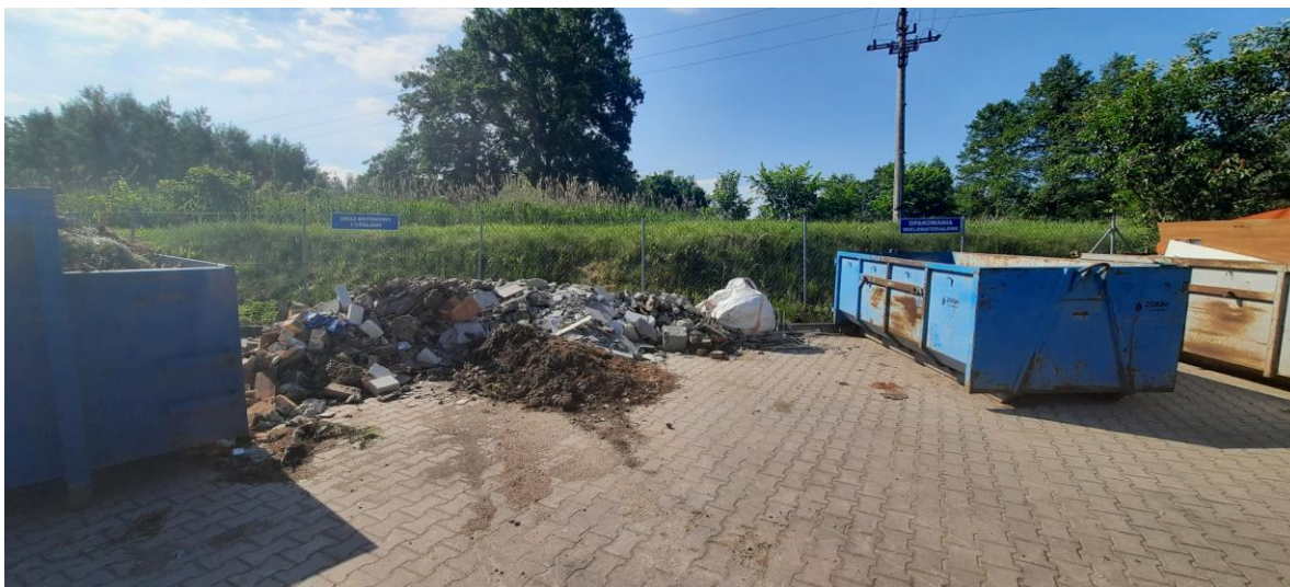
rys. 3. Sposób zbierania i magazynowania odpadów budowlano-rozbiórkowych oraz stan kontenerów.
