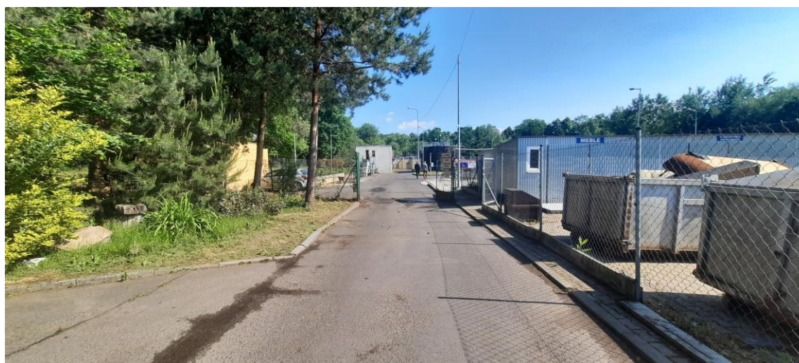
rys. 6. Widok ogólny na wjazd do oczyszczalni ścieków (teren ważenia pojazdów).
