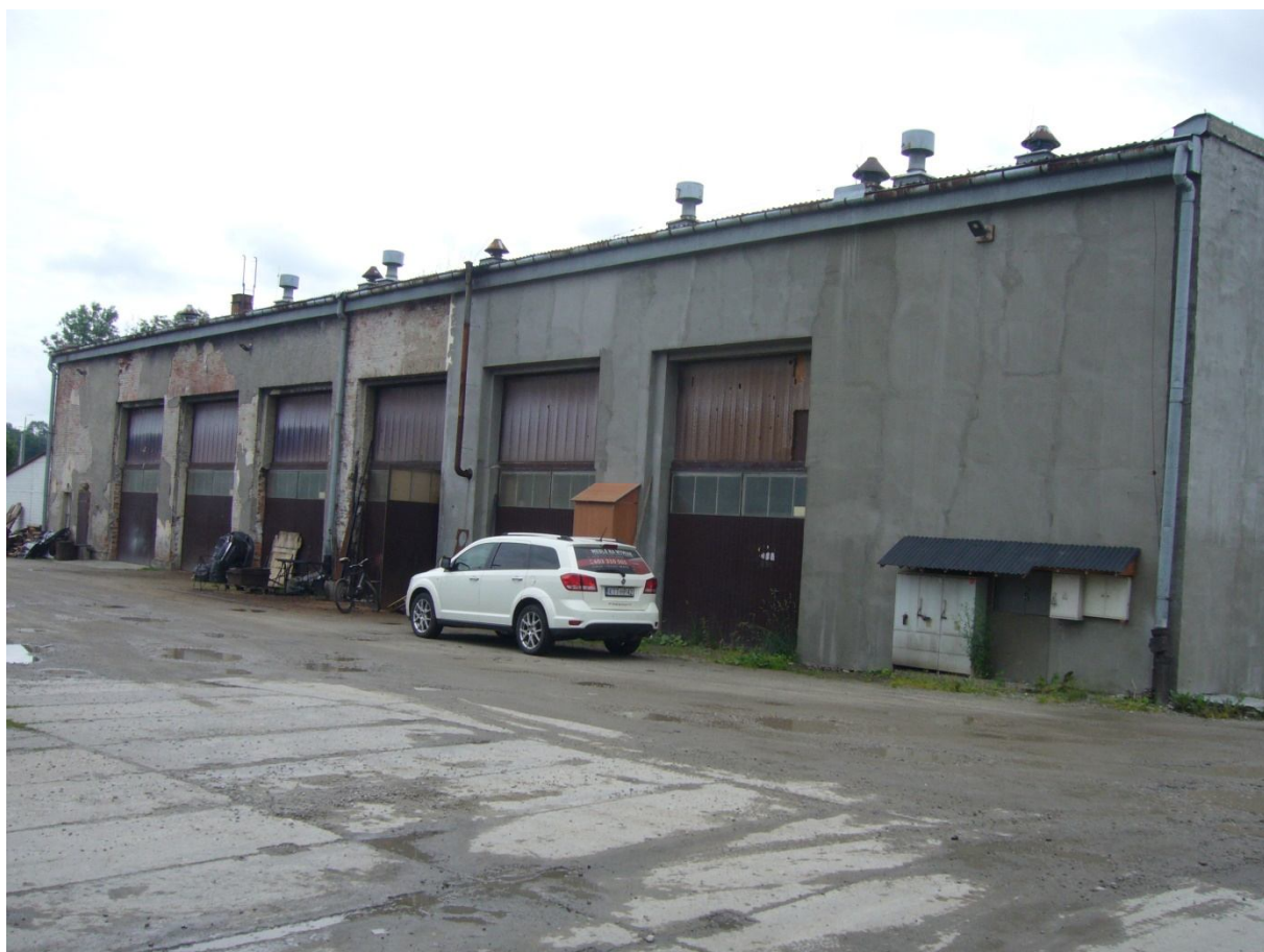
Zdjęcie nr 5: Elewacja północna
