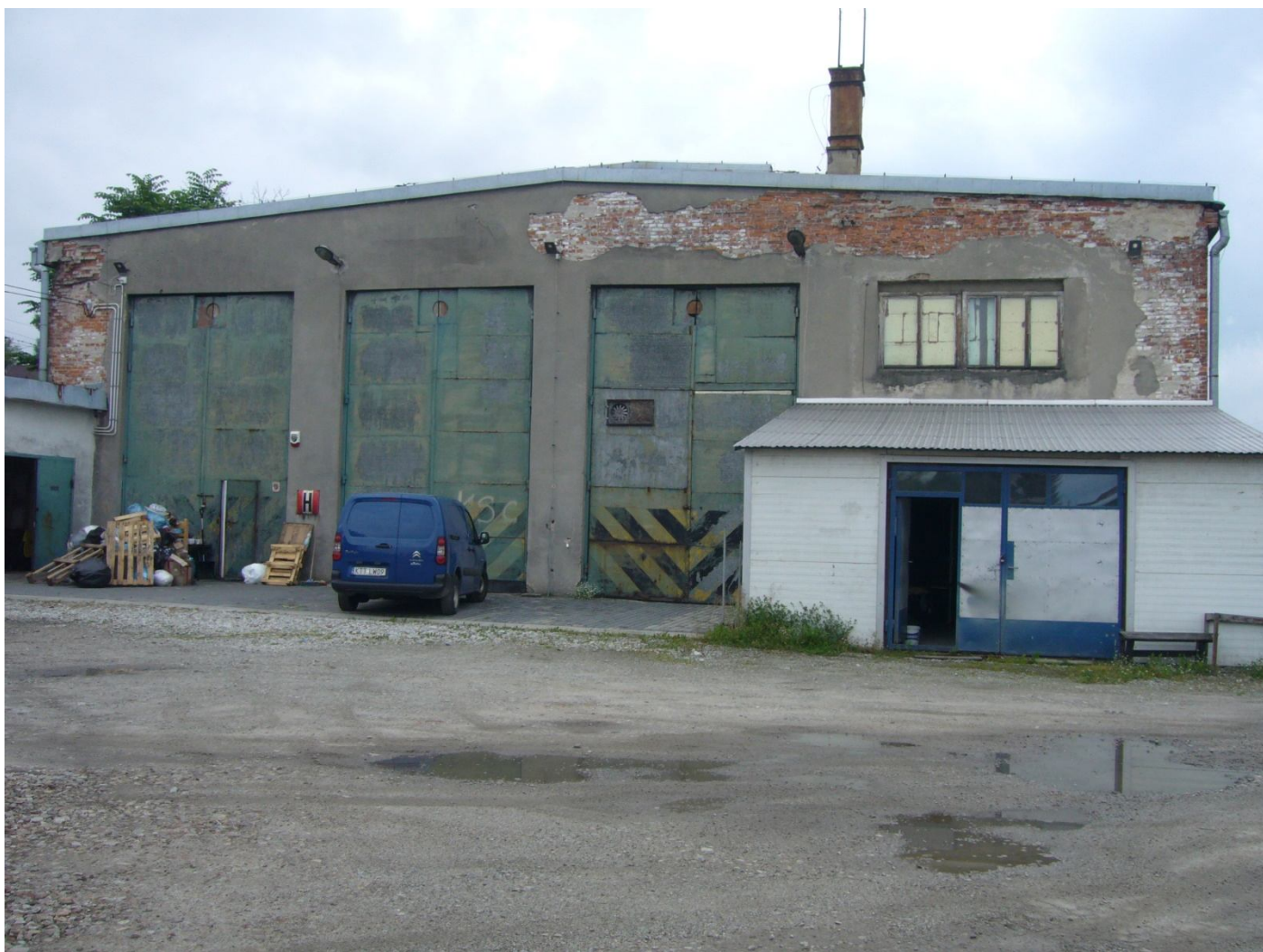
Zdjęcie nr 8: Elewacja wschodnia
