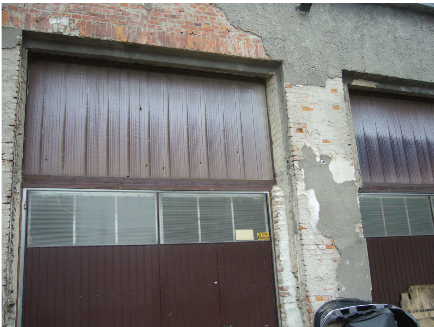
Zdjęcie nr7: Elewacja północna
