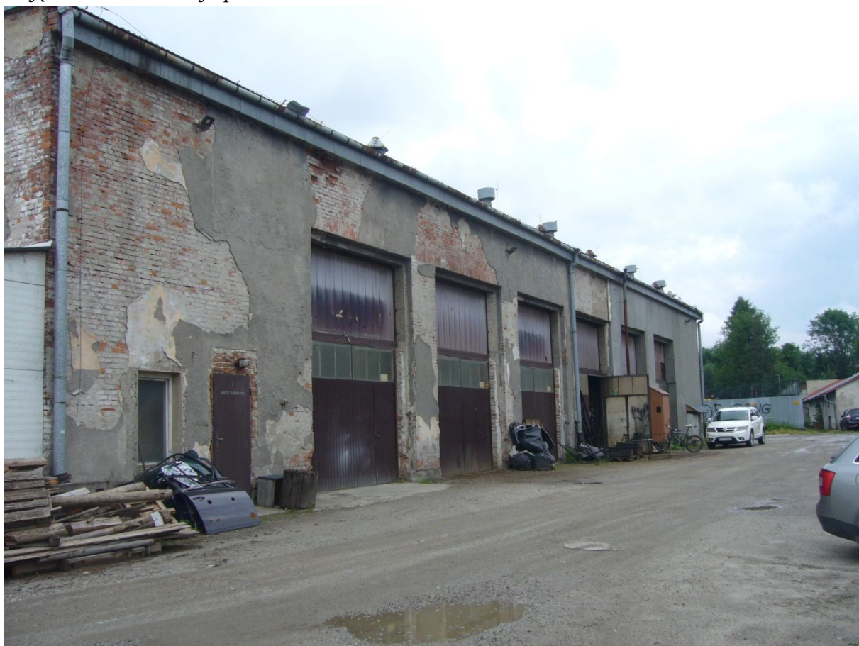
Zdjęcie nr 6: Elewacja północna
