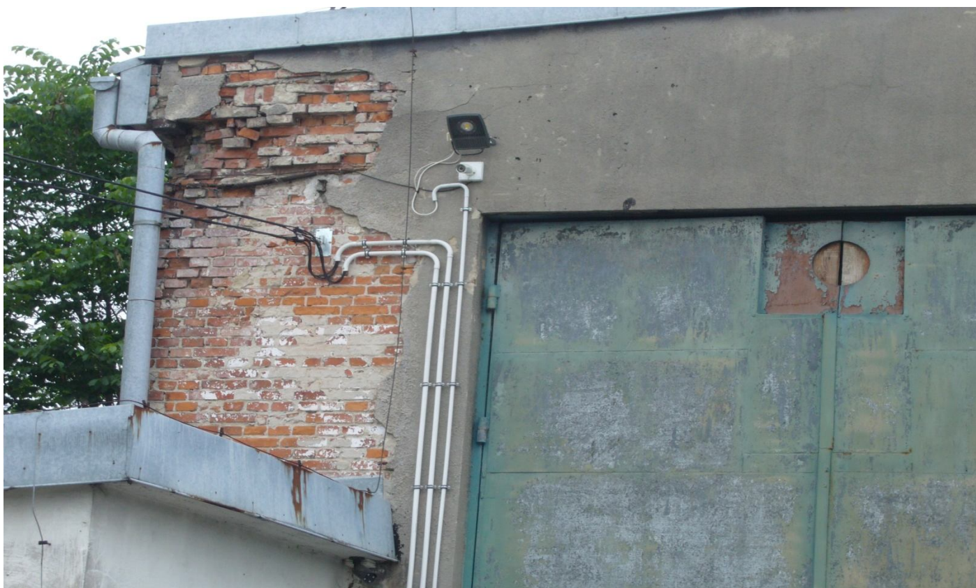
Zdjęcie nr 9: Elewacja wschodnia
