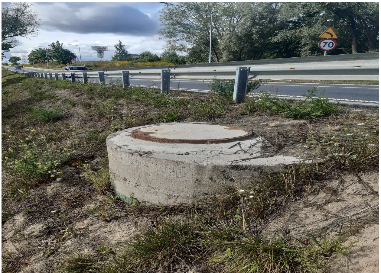
Studnia osadnikowa bez osadnika KPED 01.14
