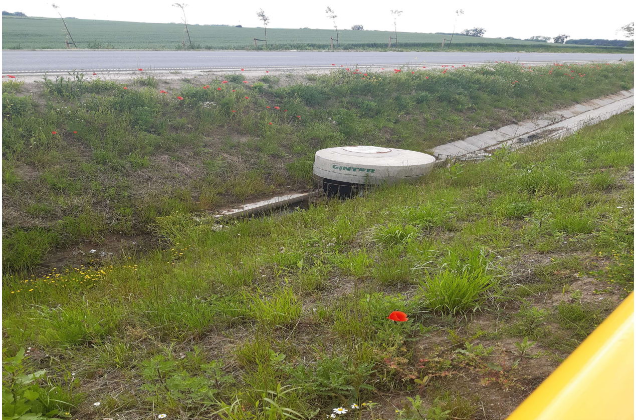
Studnia osadnikowa z podwójnym osadnikiem KPED 01.14
