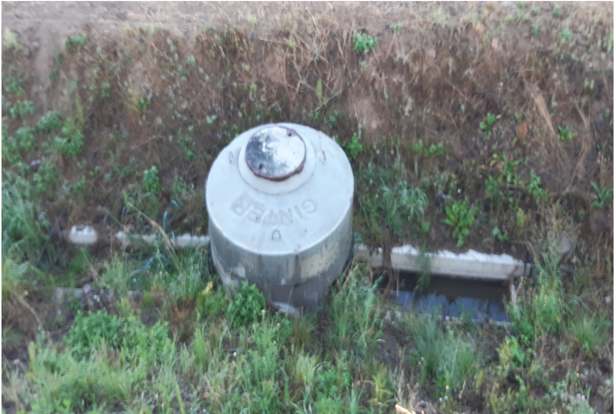
Studnia osadnikowa z pojedynczym osadnikiem KPED 01.14
