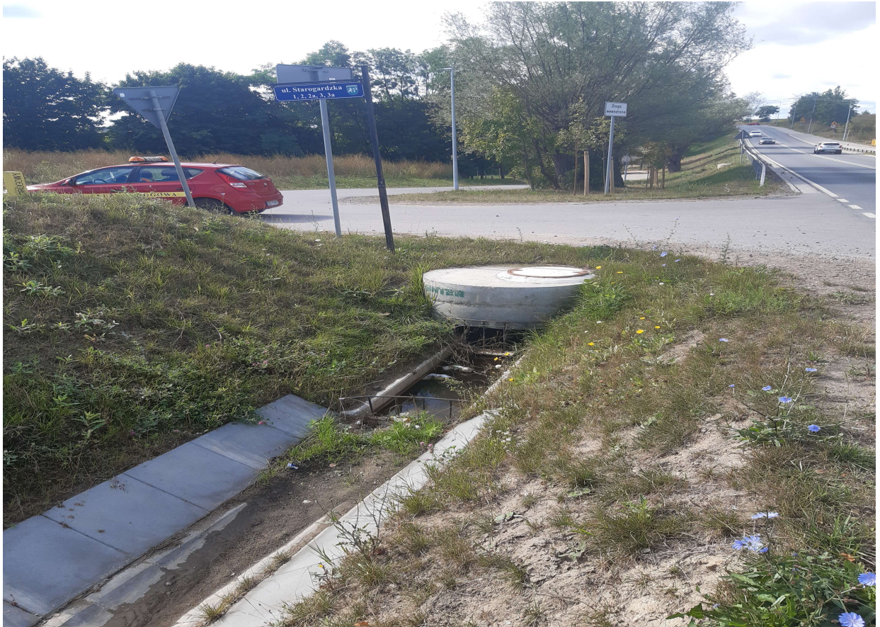
Studnia osadnikowa z pojedynczym osadnikiem KPED 01.14
