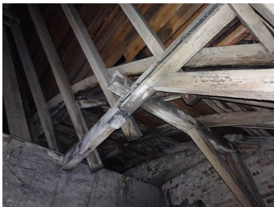
Rys. 13. Widok łukowej części wyższej więźby od ul. Kilińskiego
