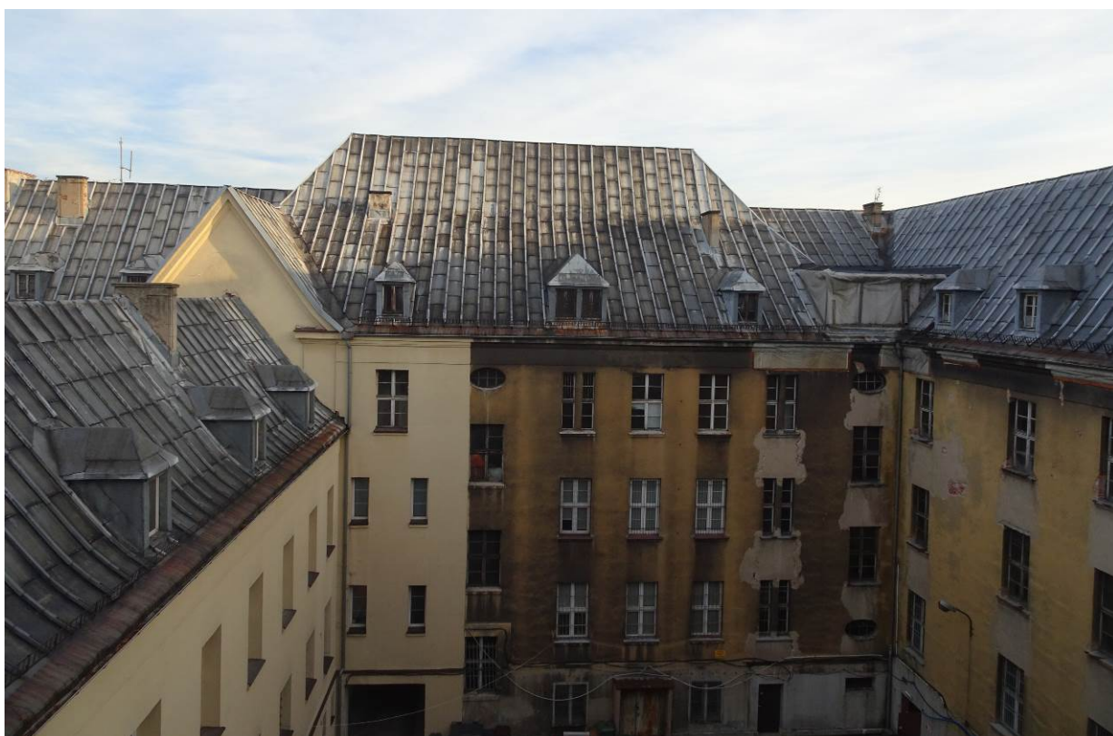
Rys. 18. Widok połączenia części wyższej (ul. Żwirki i Wigury) i niższej dachu
