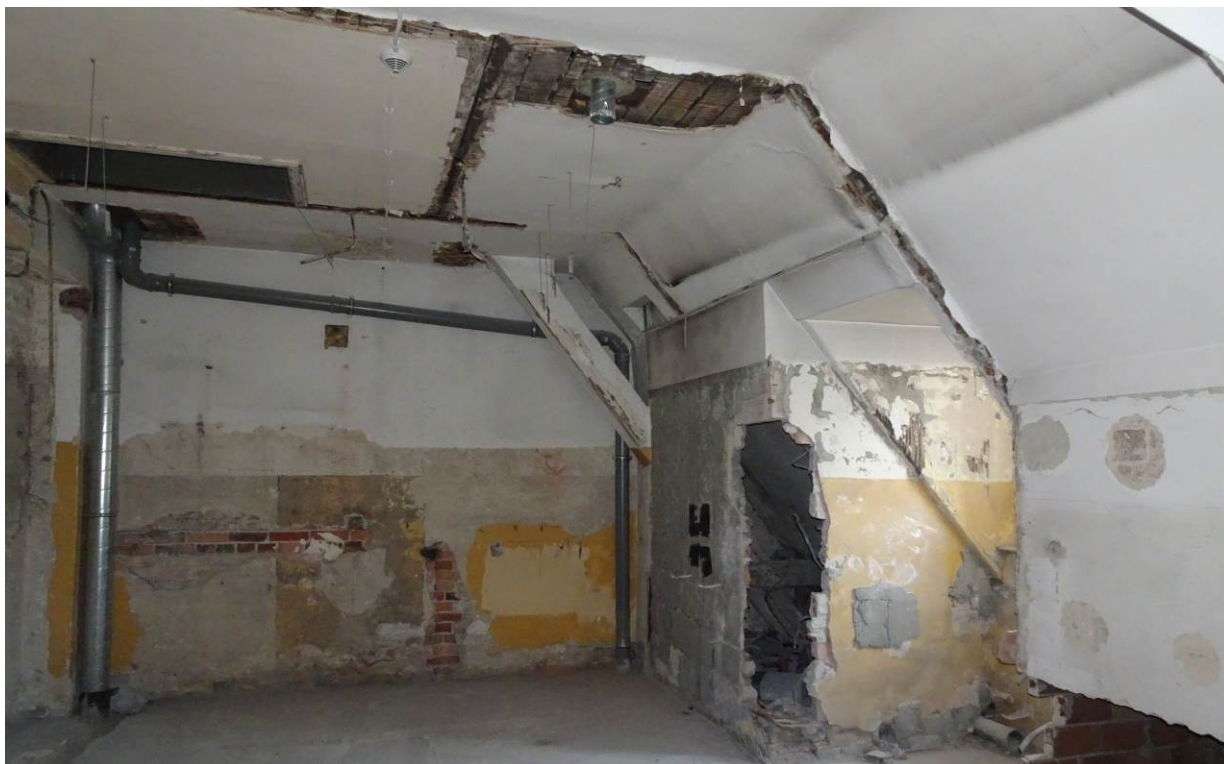
Rys. 30. Ślady zawilgoceń
