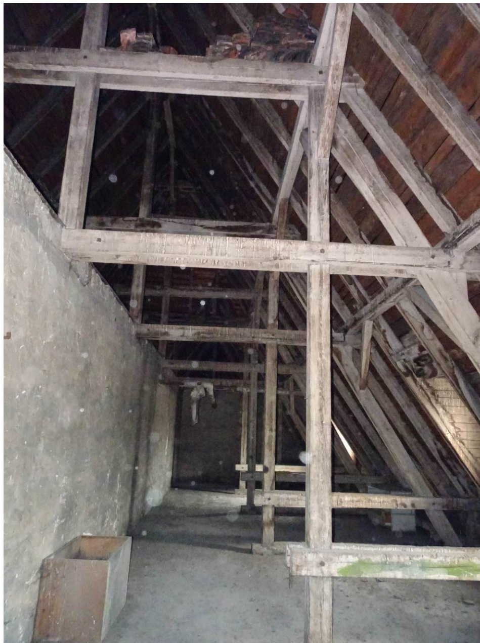
Rys. 8. Widok więźby od ul. Żwirki i Wigury
