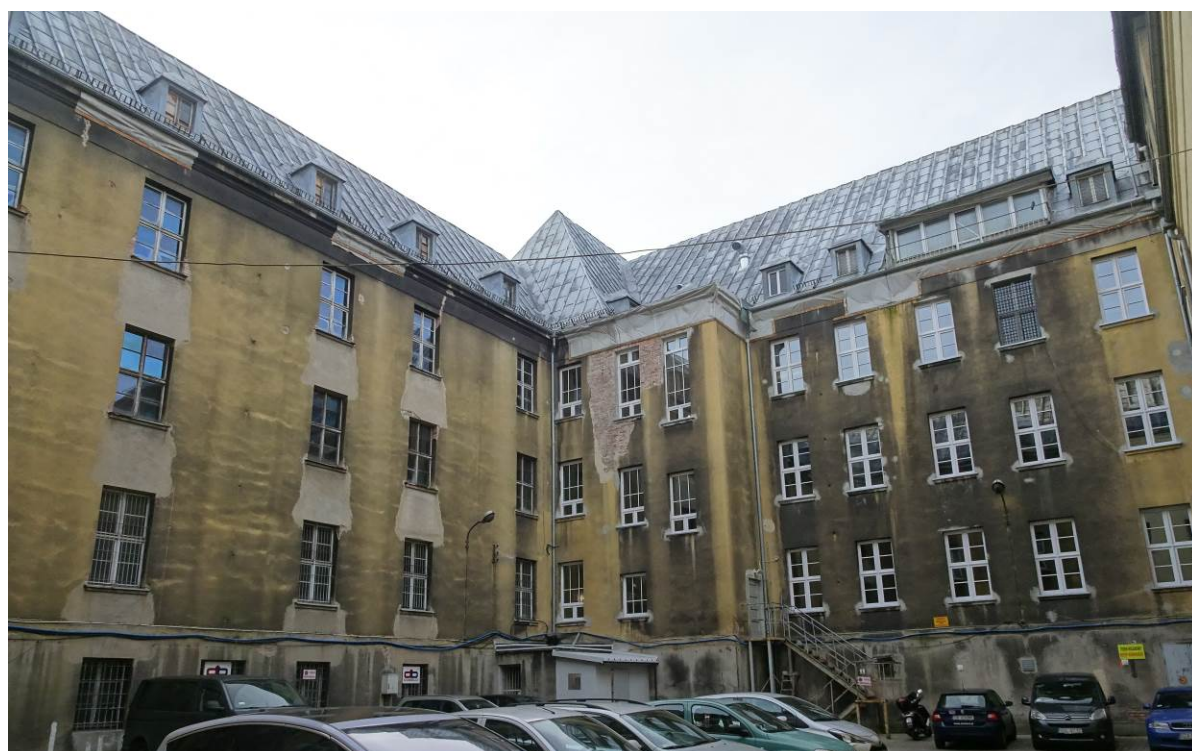
Rys. 4. Widok budynku od podwórza
