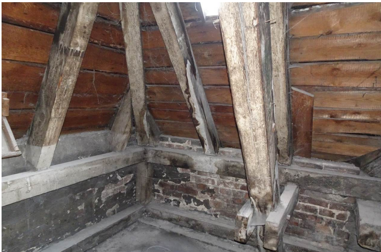
Rys. 24. Ślady zawilgoceń
