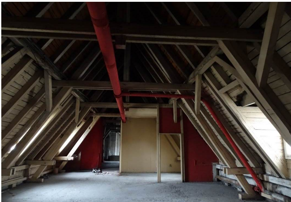
Rys. 10. Widok niższej części więźby od ul. Kilińskiego
