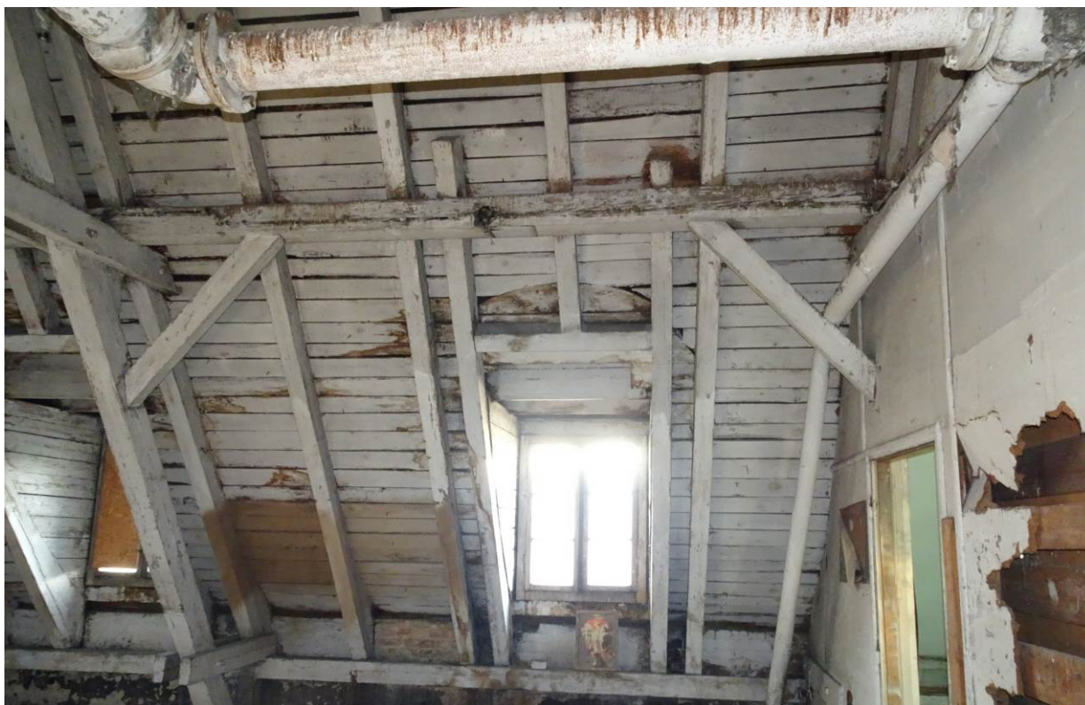
Rys. 25. Ślady zawilgoceń
