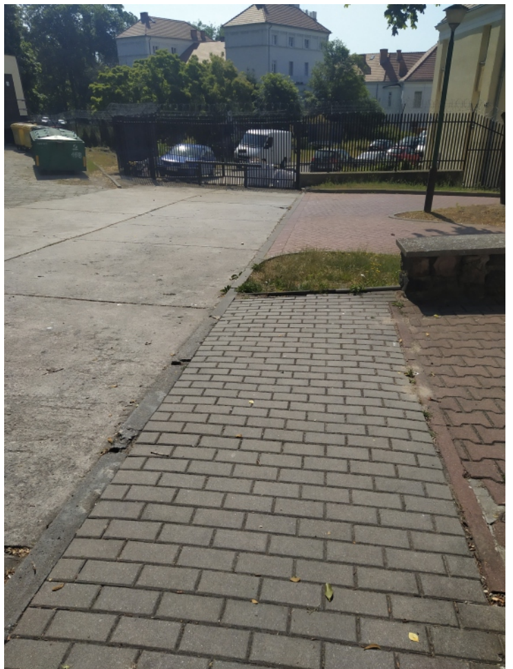
16.Nawierzchnia ist. z kostki na styku z początkiem drogi do remontu
