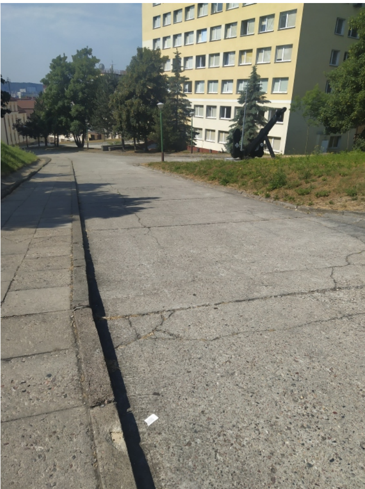
15..Nawierzchnia ist.betonowa drogi do remontu i chodnika z płyt betonowych
