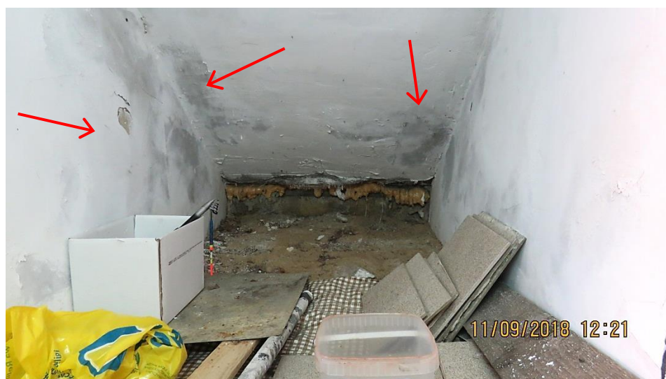
Zacieki ścian i stropu (spód schodów zewnętrznych) nad zejściem zewnętrznym do kotłowni.
