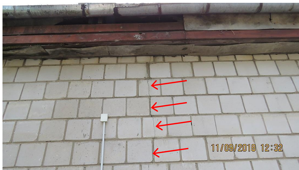
Zacieki ścian i stropu (spód schodów zewnętrznych) nad zejściem zewnętrznym do kotłowni.
