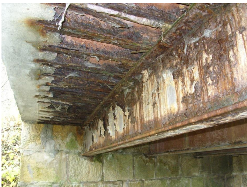
Fot. 3. Widok przęsła mostu od spodu.
