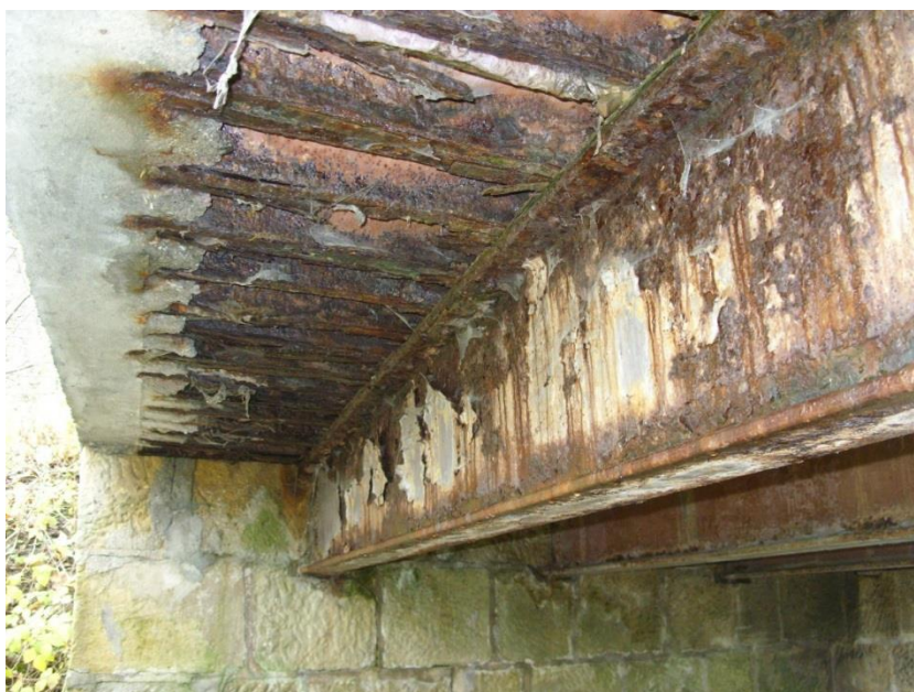
Fot. 3. Widok przęsła mostu od spodu.
