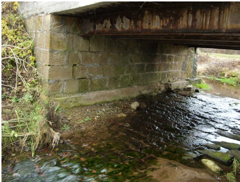
Fot. 4. Widok na podporę nr 2.
