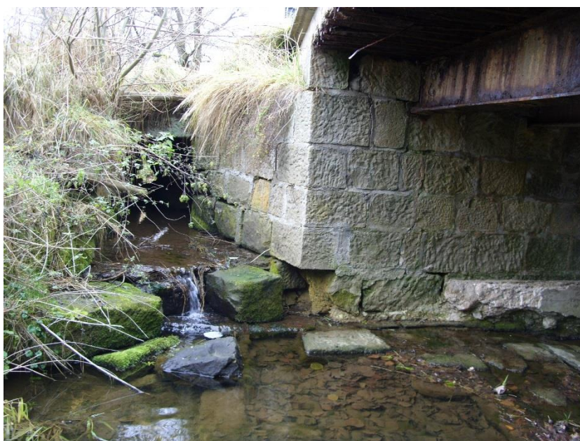
Fot. 5. Widok na podporę nr 1 oraz na przepust płytowy przy skrzydle podpory.
