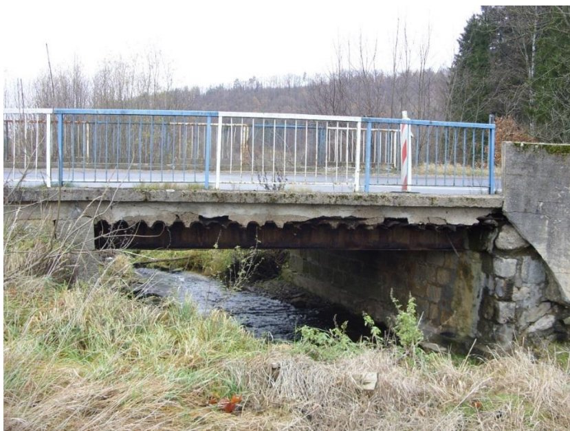
Fot. 2. Widok obiektu mostowego od strony górnej wody.
