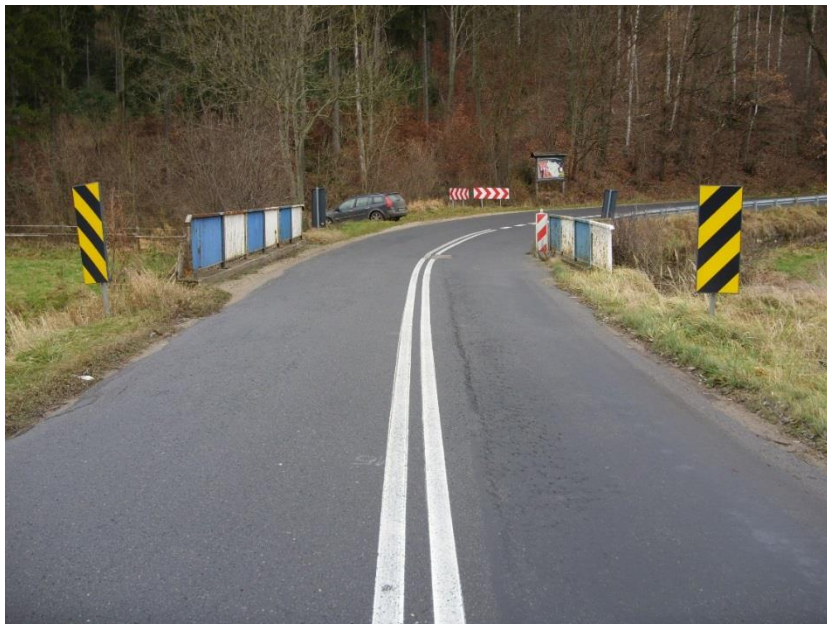
Fot. 1. Widok obiektu mostowego od strony m. Pławna.
