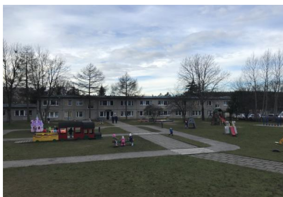
Widok części południowej - elewacji wschodniej
