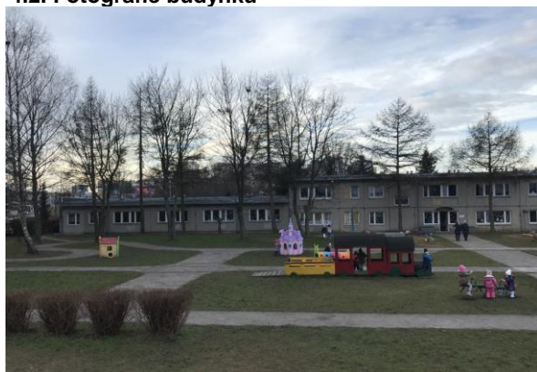
Widok części północnej - elewacji wschodniej
