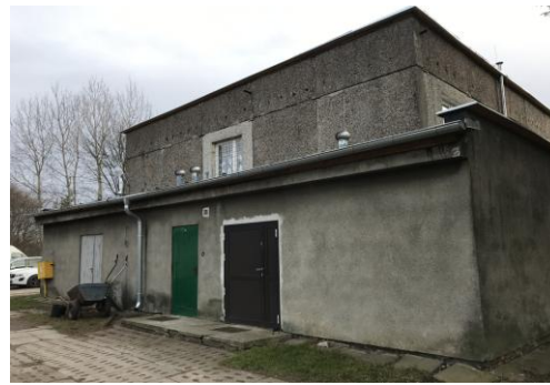
Widok elewacji północnej wraz z dobudówką
