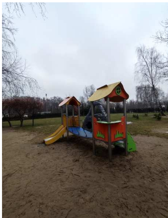
Na zdjęciach widoczne istniejące urządzenia zabawowe (R.2, ozn. 7, 8) wymagające budowy nowej nawierzchni bezpiecznej poliuretanowej pod urządzeniami.
