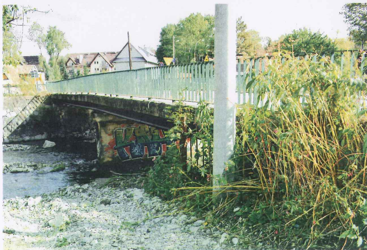
Fot. 16. Widok obiektu od dolnej wody
