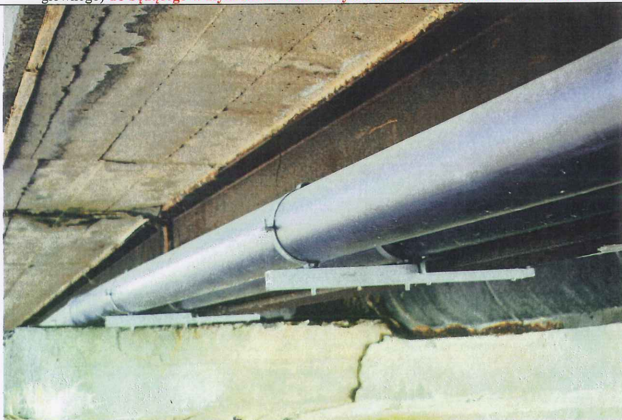
Fot. 8. Widok podwieszenia nowych kabli
