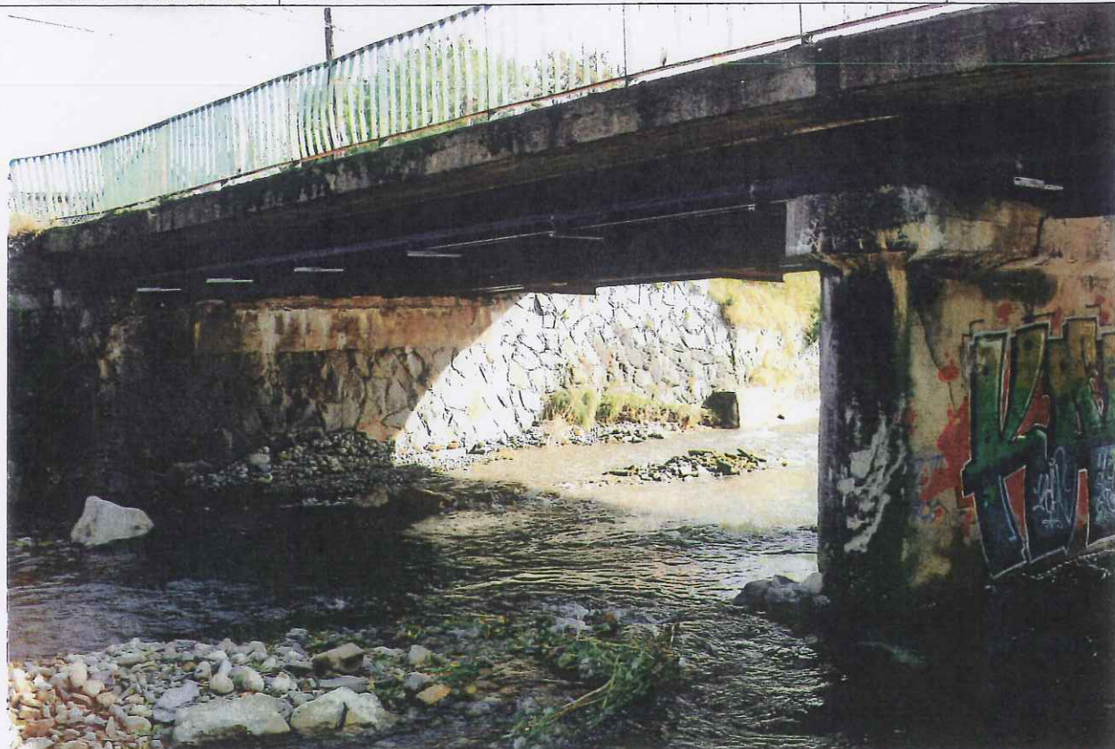
Fot. 5. Widok stanu obiektu od dolnej wody – podwieszane nowe rury technologiczne z kabami ! .
