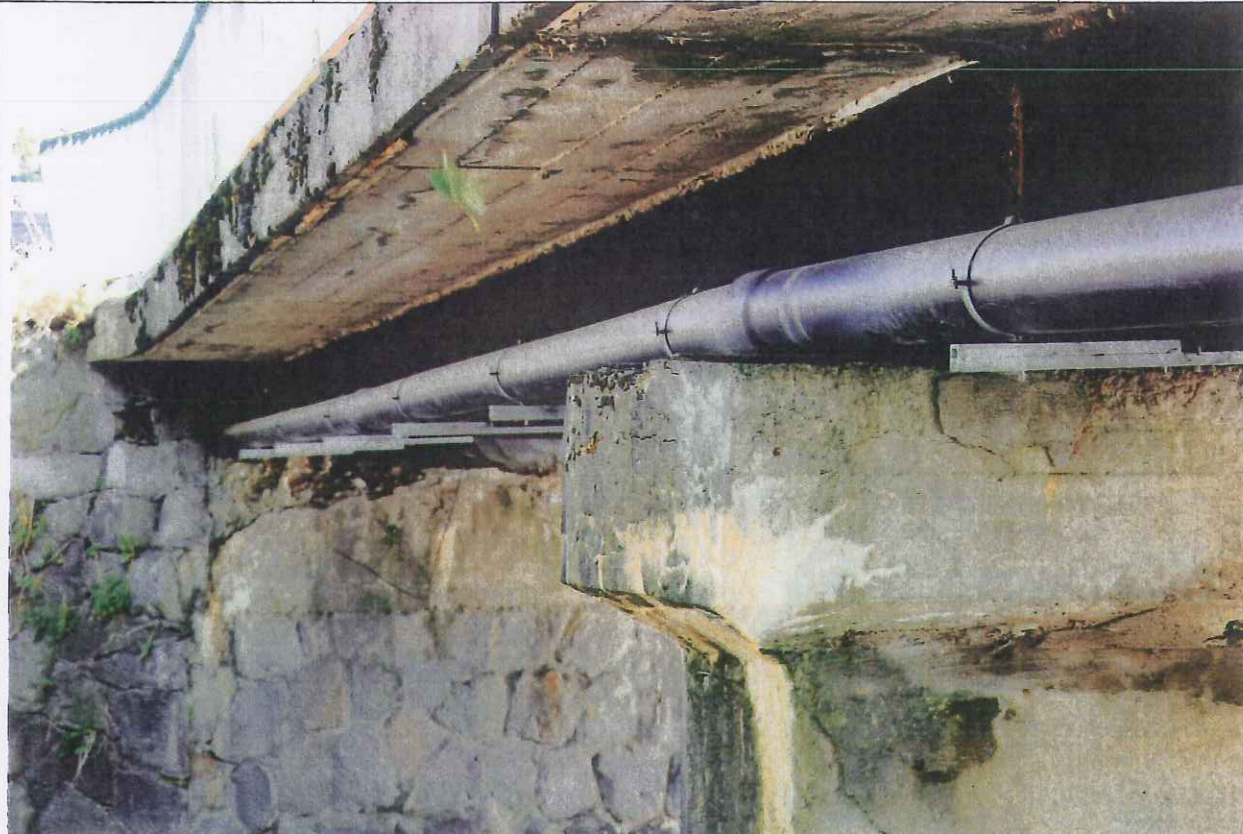
Fot. 9. Widok nowych podwiesz
