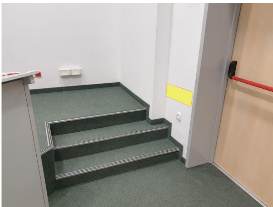
zdjęcie 3. planowana lokalizacja opraw – zejście z podestu
