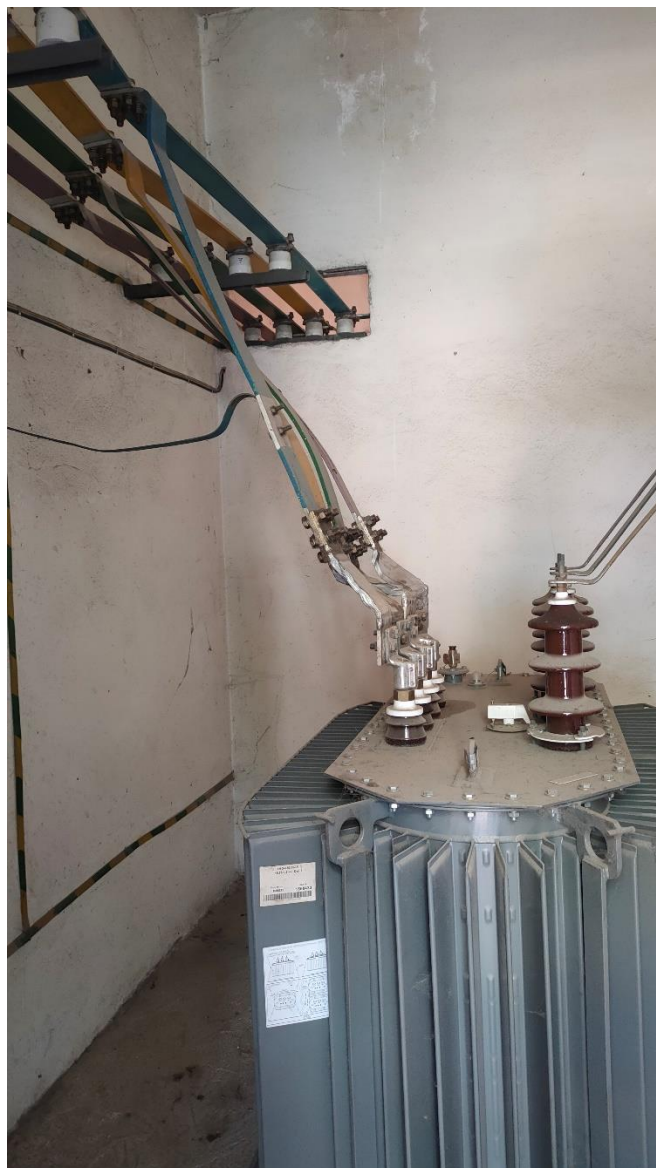
Fot. 1 Komora transformatorowa z transformatorem 630 kVA
