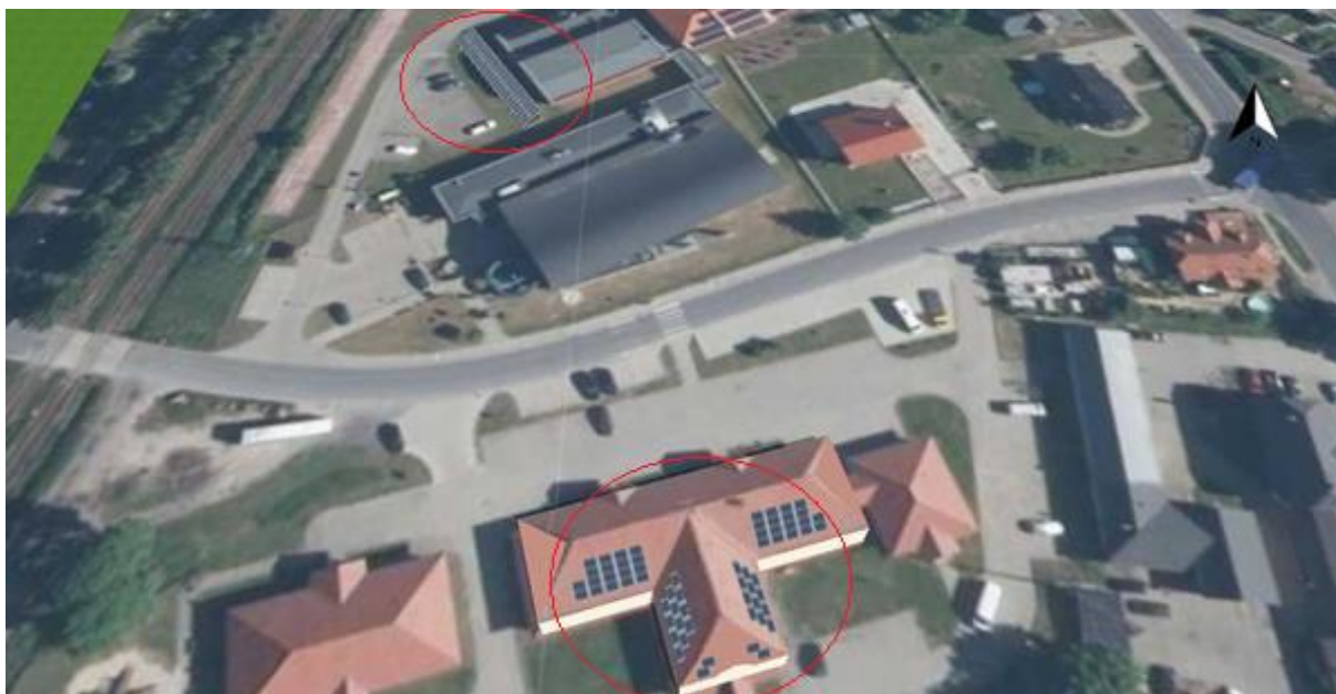
14. Budynek krytej pływalni ul. Piaskowa 4, 59-724 Osiecznica, nr działki 18/6, 840
