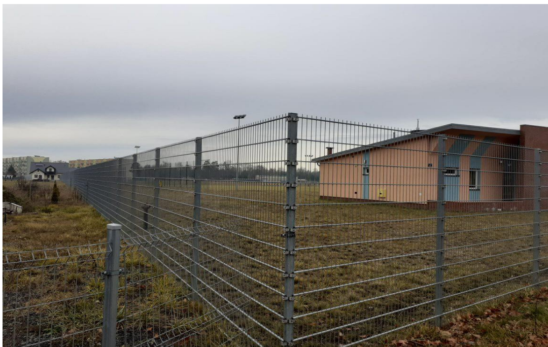
Zdj. 21 Zdjęcie obiektu.
