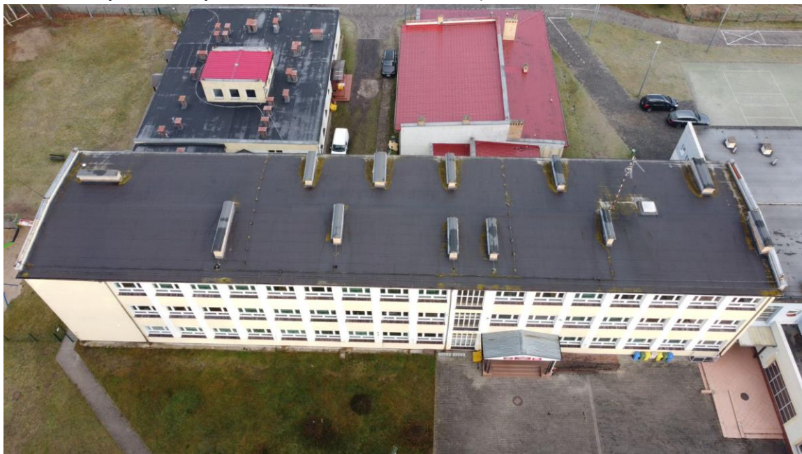
Zdj. 4. Zdjęcie obiektu.
