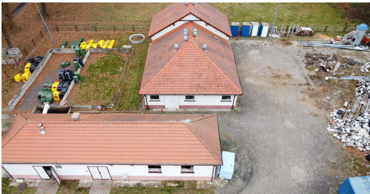
Zdj. 18. Zdjęcie obiektu.
