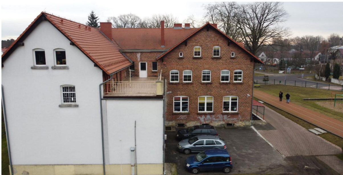
Zdj. 8. Zdjęcie obiektu.
