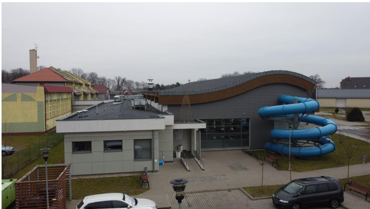
Zdj. 14. Zdjęcie obiektu.
