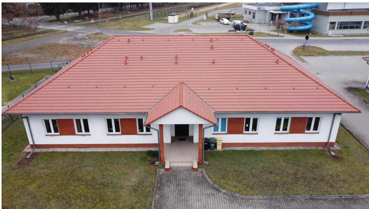
Zdj. 10. Zdjęcie obiektu.
