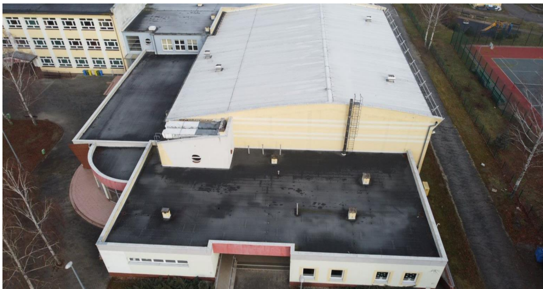
Zdj. 5. Zdjęcie obiektu.
