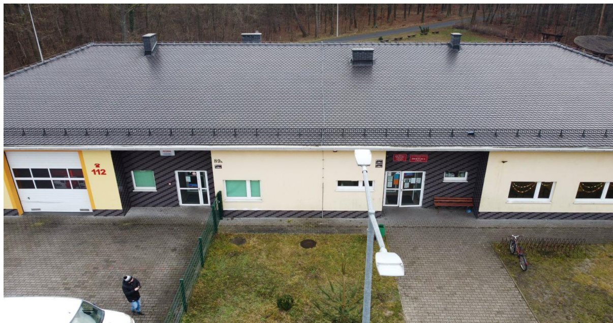
Zdj. 12. Zdjęcie obiektu.
