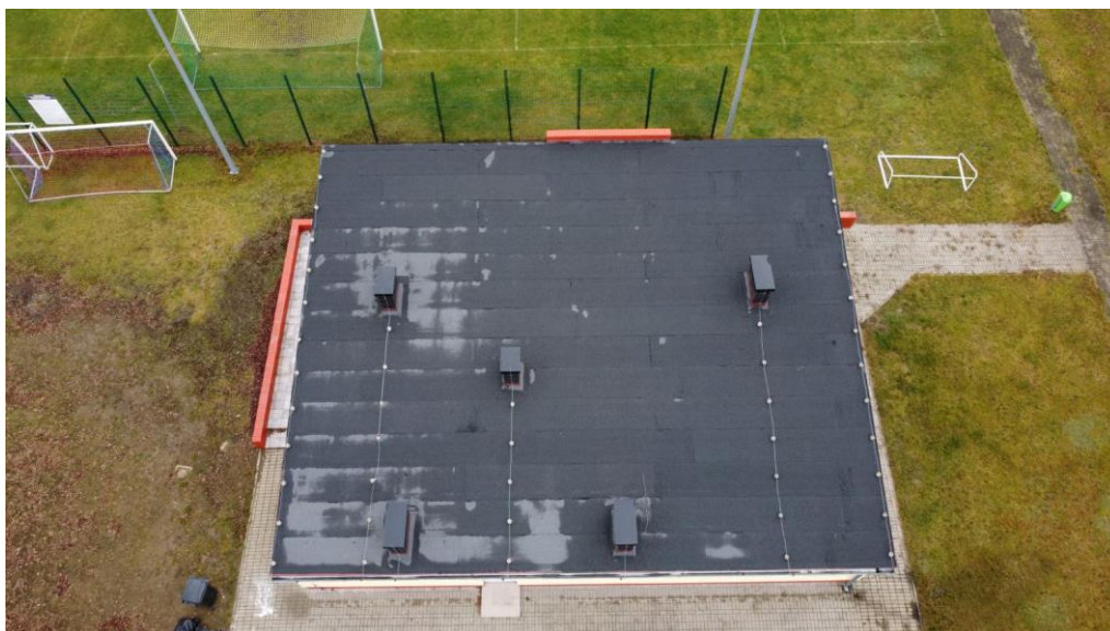
Zdj. 13. Zdjęcie obiektu.
