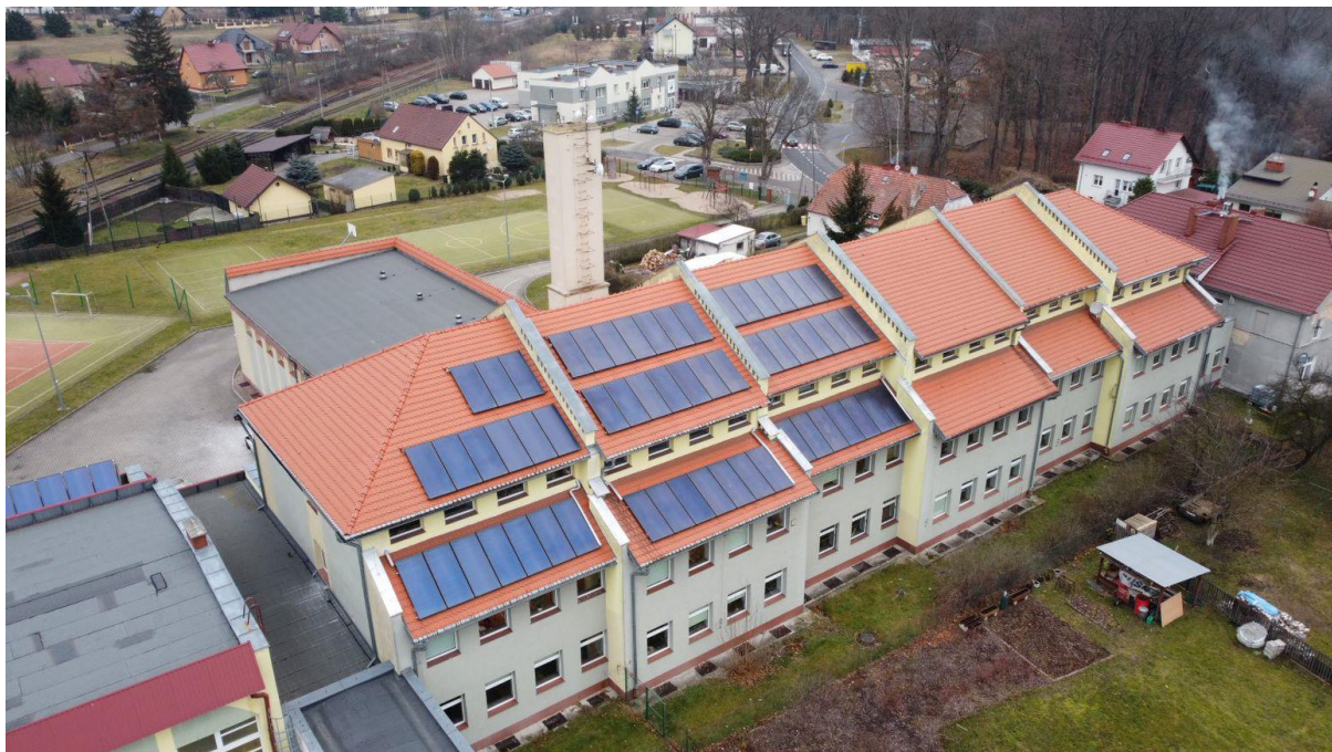
Zdj. 7. Zdjęcie obiektu.
