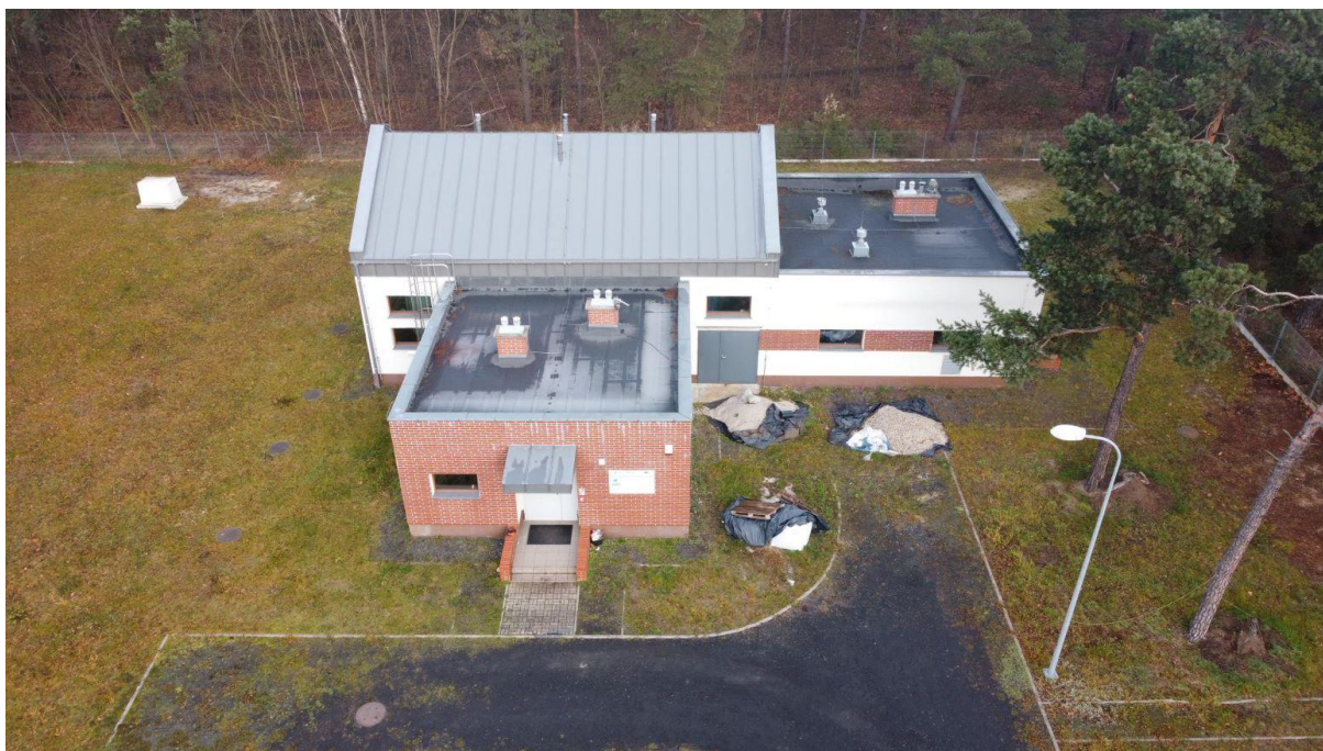
Zdj. 19. Zdjęcie obiektu.
