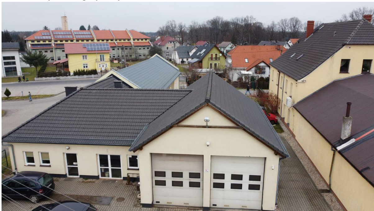
Zdj. 17. Zdjęcie obiektu.
