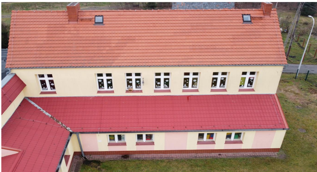
Zdj. 9. Zdjęcie obiektu.
