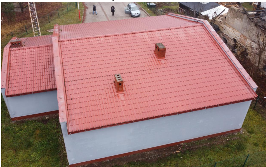
Zdj. 2. Zdjęcie obiektu.
