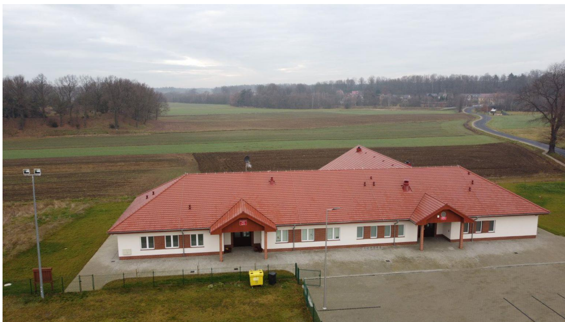
Zdj. 16. Zdjęcie obiektu.
