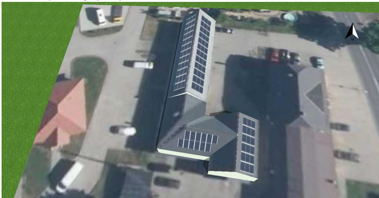
17. Budynek magazynowy, ul. Lubańska 29B, 59-724 Osiecznica, nr działki 841
