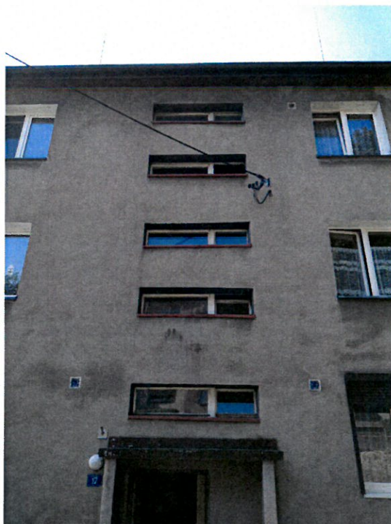
Widok stolarki okiennej klatek schodowych (5szt. Okien)
