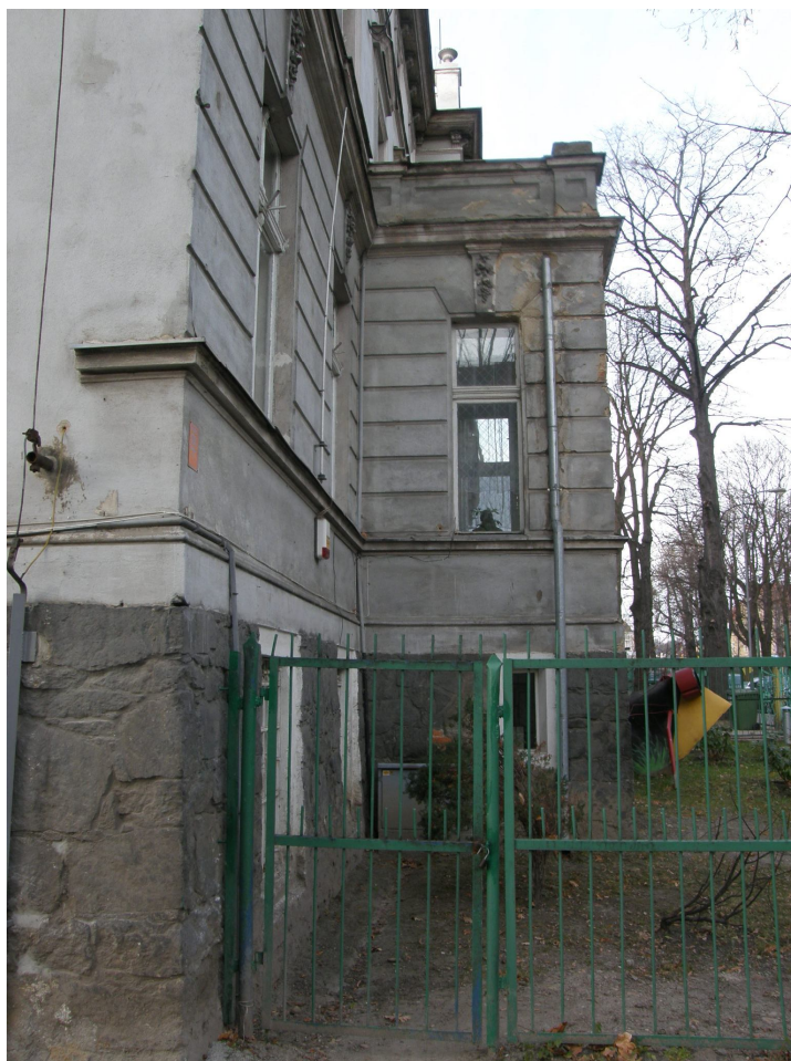
fragment elewacji frontowej
