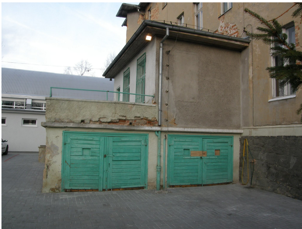
elewacja tylna -widok na budynek dobudowany
