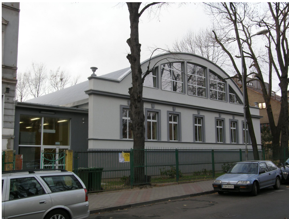
elewacja nowo wybudowanej sali gimnastycznej od strony ulicy Pionierów
