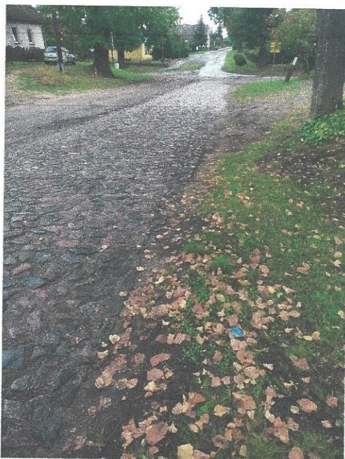
Fotografia nr 1 Kłosów - istniejąca nawierzchnia
