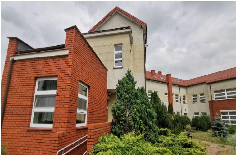
Widok okien od południowej strony budynku
