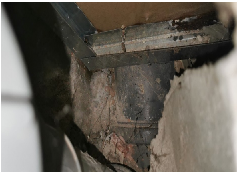
Widok wewnątrz rewizji pomiędzy korytarzem a sanitariatami Źródło: materiały własne
