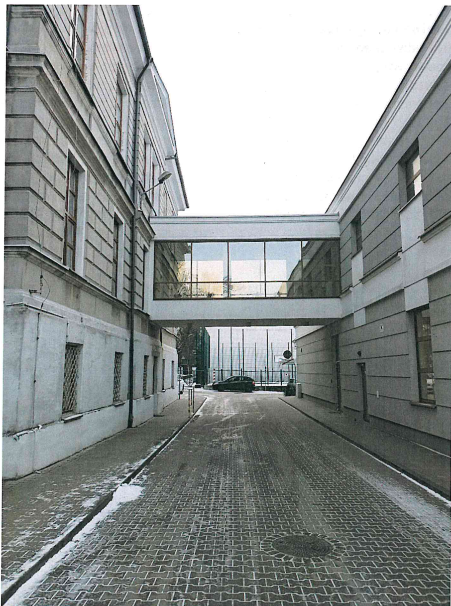
Wysokość przejazdu – ok. 3,7 m, szerokość jezdni 5 m, chodniki po ok. 1,4 m.
