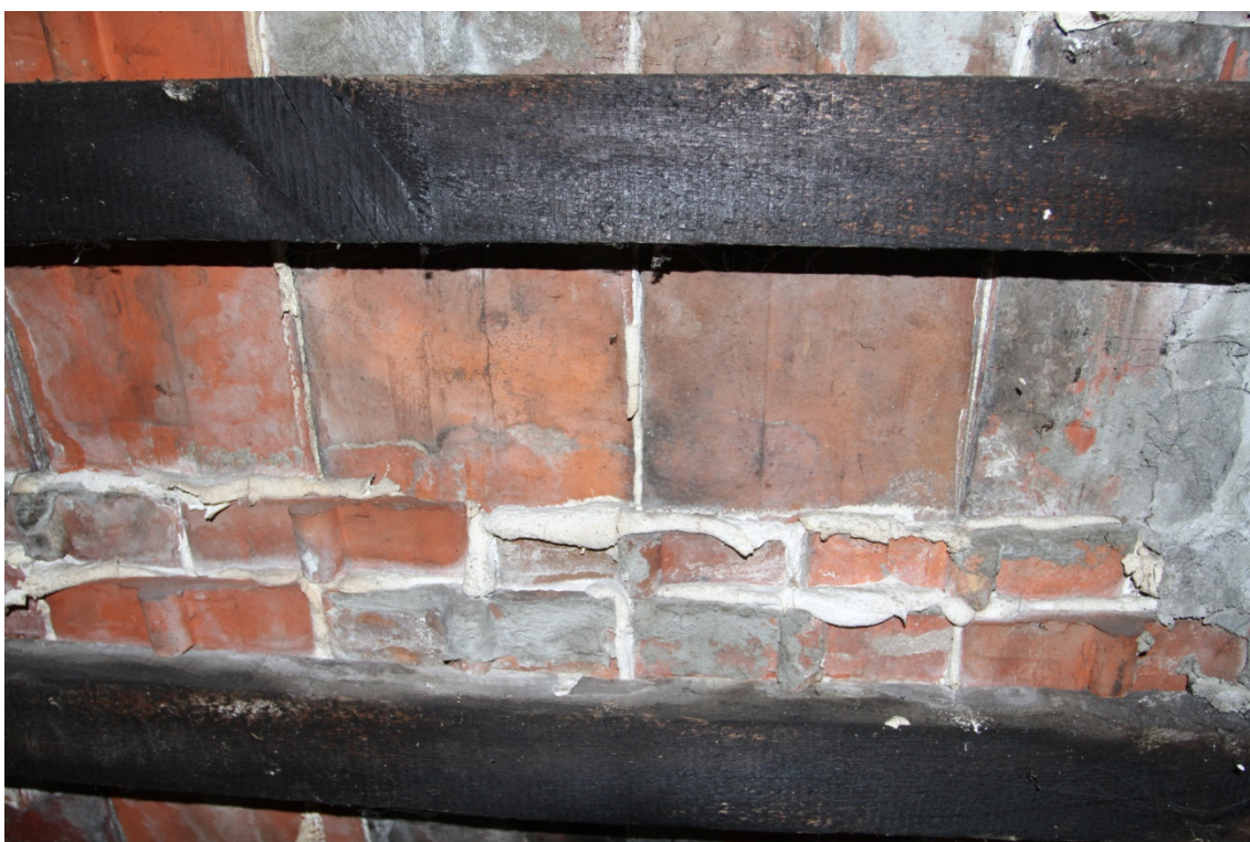
Fot. 17. Pokrycie dachu z dachówki karpiówki w koronkę (fot. Karolina Witkowska).
