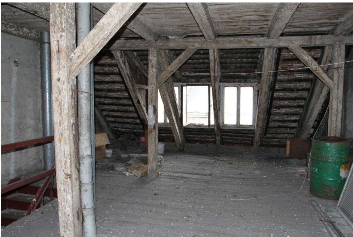
Fot. 18. Strych w kamienicy przy ul. Spichrzowej 34 w Grudziądzu (fot. Karolina Witkowska).
