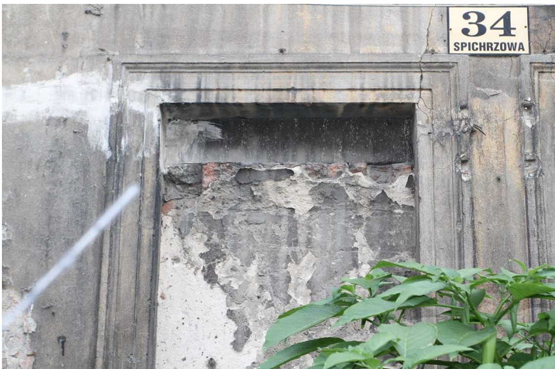
Fot. 7. Ślepa blenda z zamurowanym nadświetlem (fot. Karolina Witkowska).
