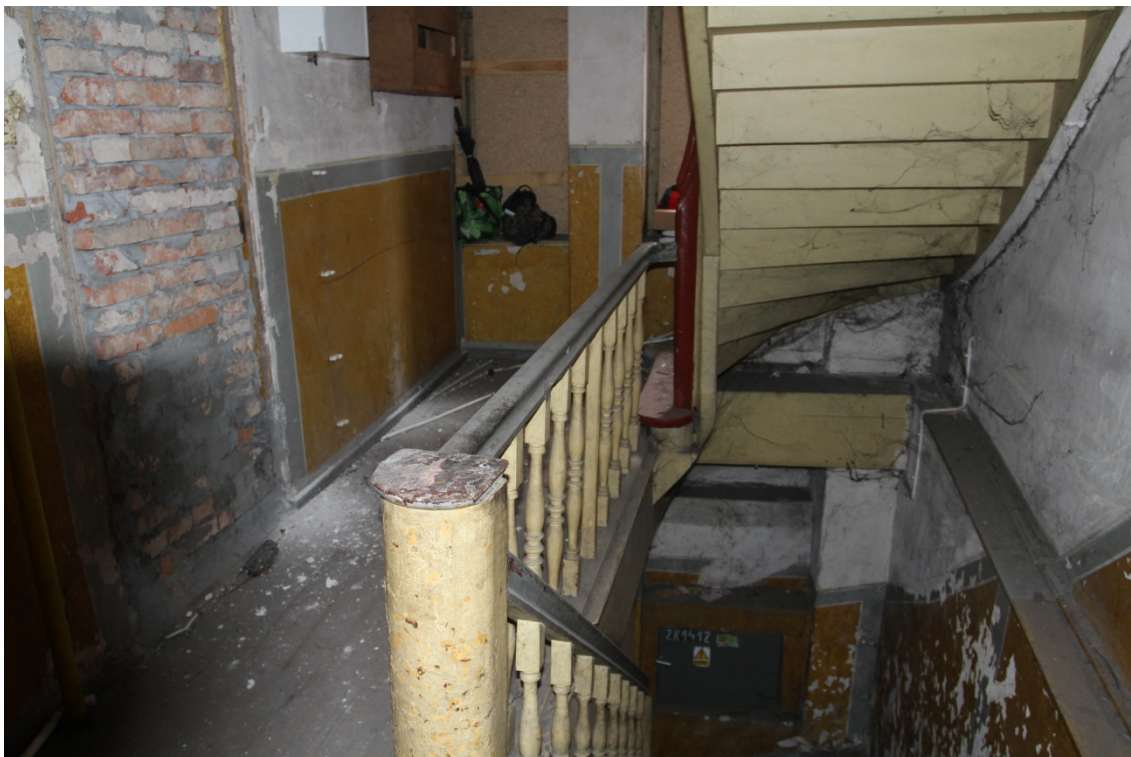
Fot. 21. Klatka schodowa, II kondygnacja (fot. Karolina Witkowska).
