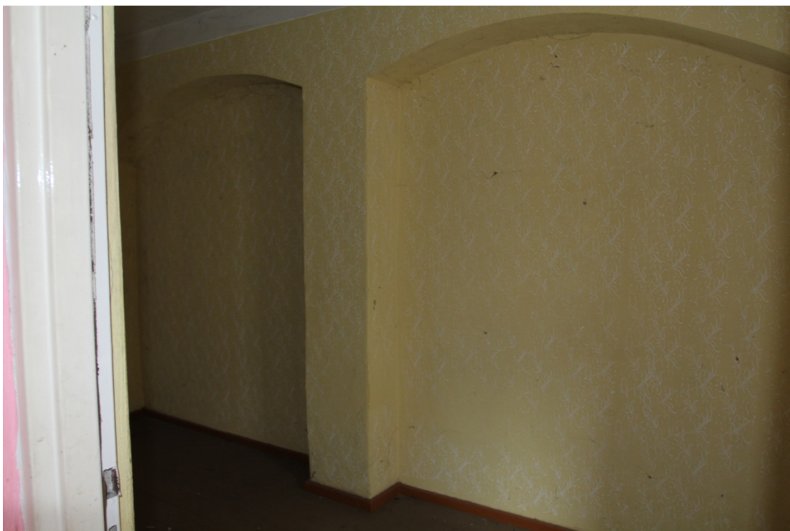
Fot. 27. Strych w kamienicy przy ul. Spichrzowej 34 w Grudziądzu, III kondygnacja (fot. Karolina Witkowska).
