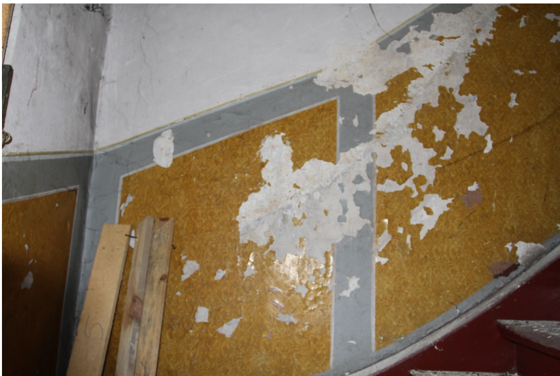
Fot. 22. Klatka schodowa, II kondygnacja (fot. Karolina Witkowska).
