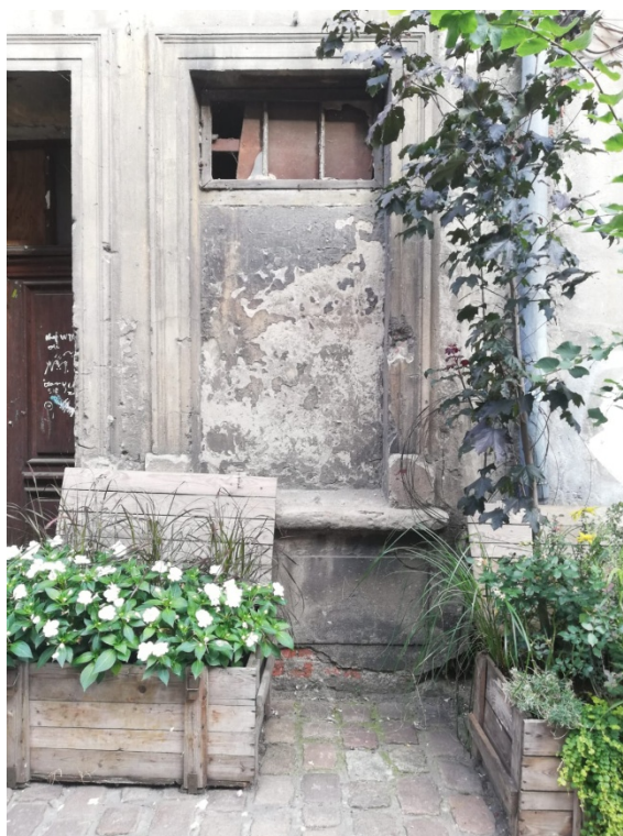
Fot. 4. Ślepa blenda z nadświetłem na lewo od drzwi wejściowych (fot. Karolina Witkowska).
