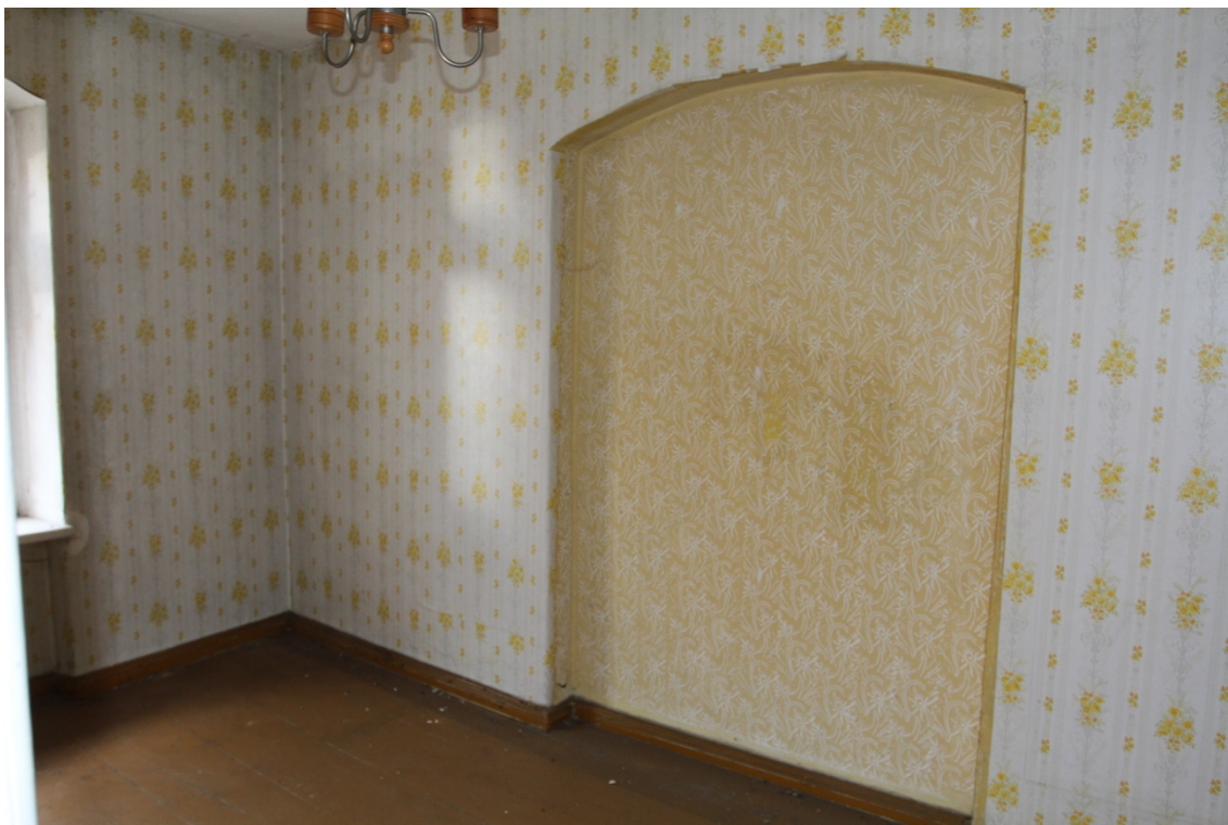
Fot. 26. Wnętrze kamienicy przy ul. Spichrzowej 34 w Grudziądzu, III kondygnacja (fot. Karolina Witkowska).
