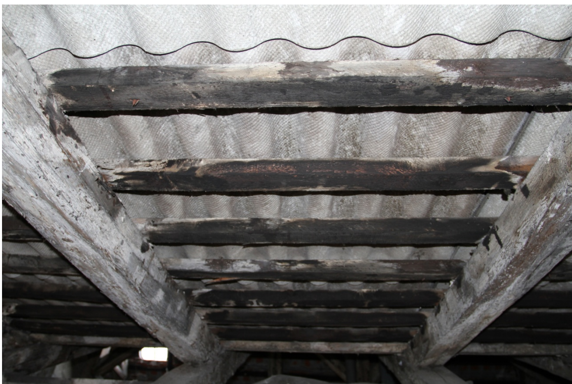
Fot. 16. Wtórne pokrycie dachu z eternitu (fot. Karolina Witkowska).
