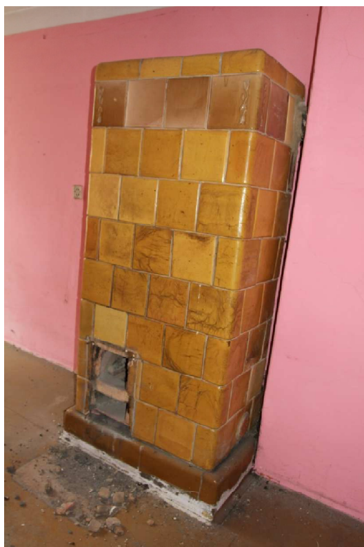
Fot. 32. Piec w kamienicy przy ul. Spichrzowej 34 w Grudziądzu, II kondygnacja (fot. Karolina Witkowska).
