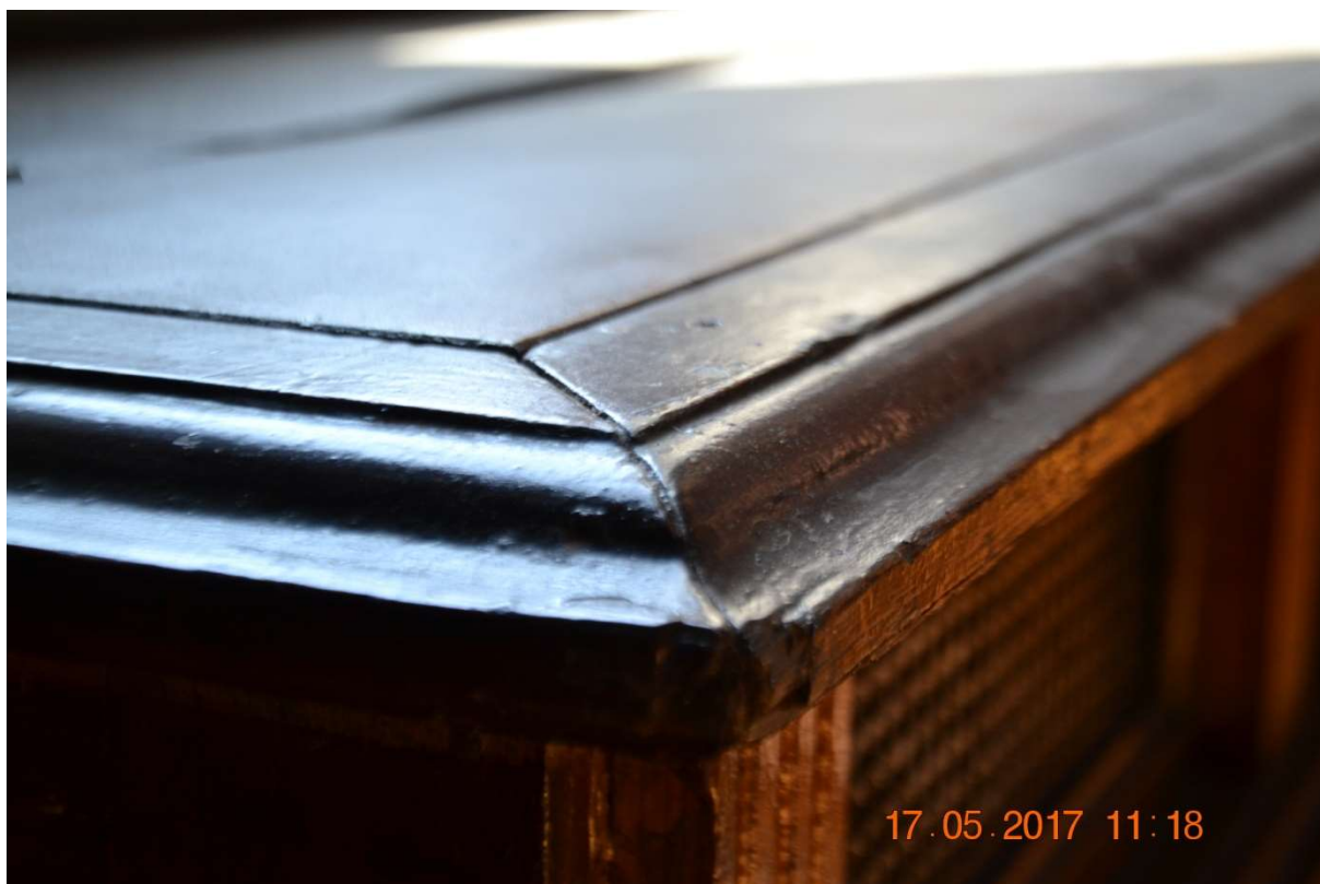
Fot.10 Narożnik drewnianej skrzynki, strona południowa.
