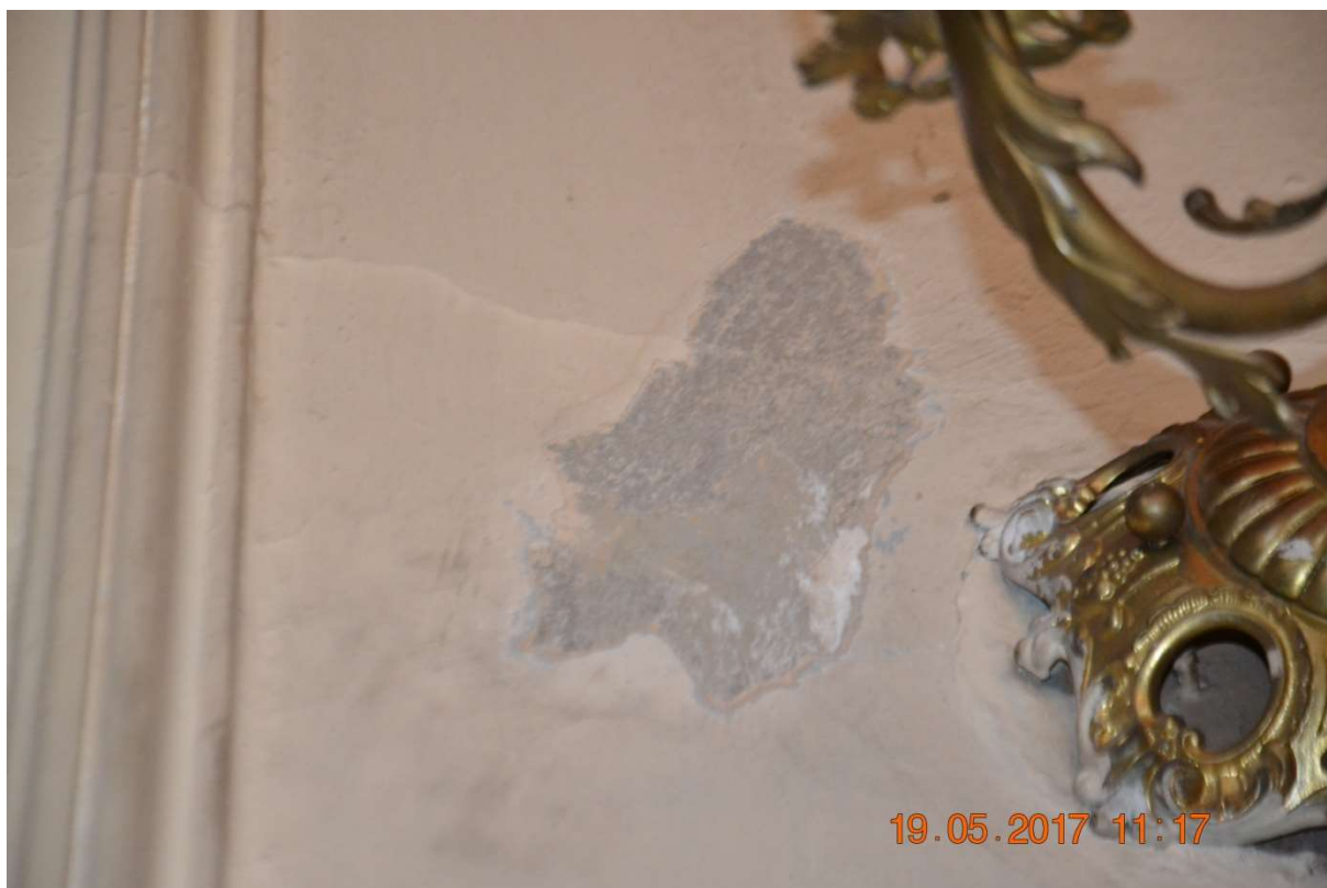
Fot.22 Wewnętrzna płaszczyzna płytki przy kinkiecie, ściana północna.
