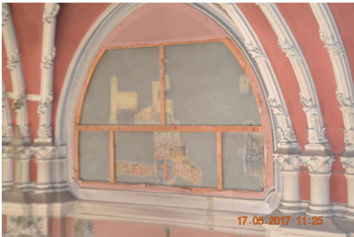
Fot.14 Odkrywka na ścianie północnej.
