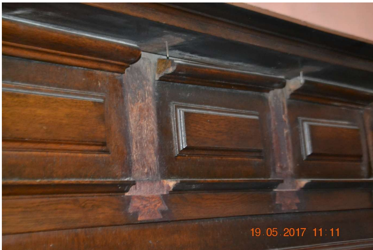
Fot.19 Brak drewnianych ślimacznikowych konsol dekoracyjnych. Przedsiónek sali.
