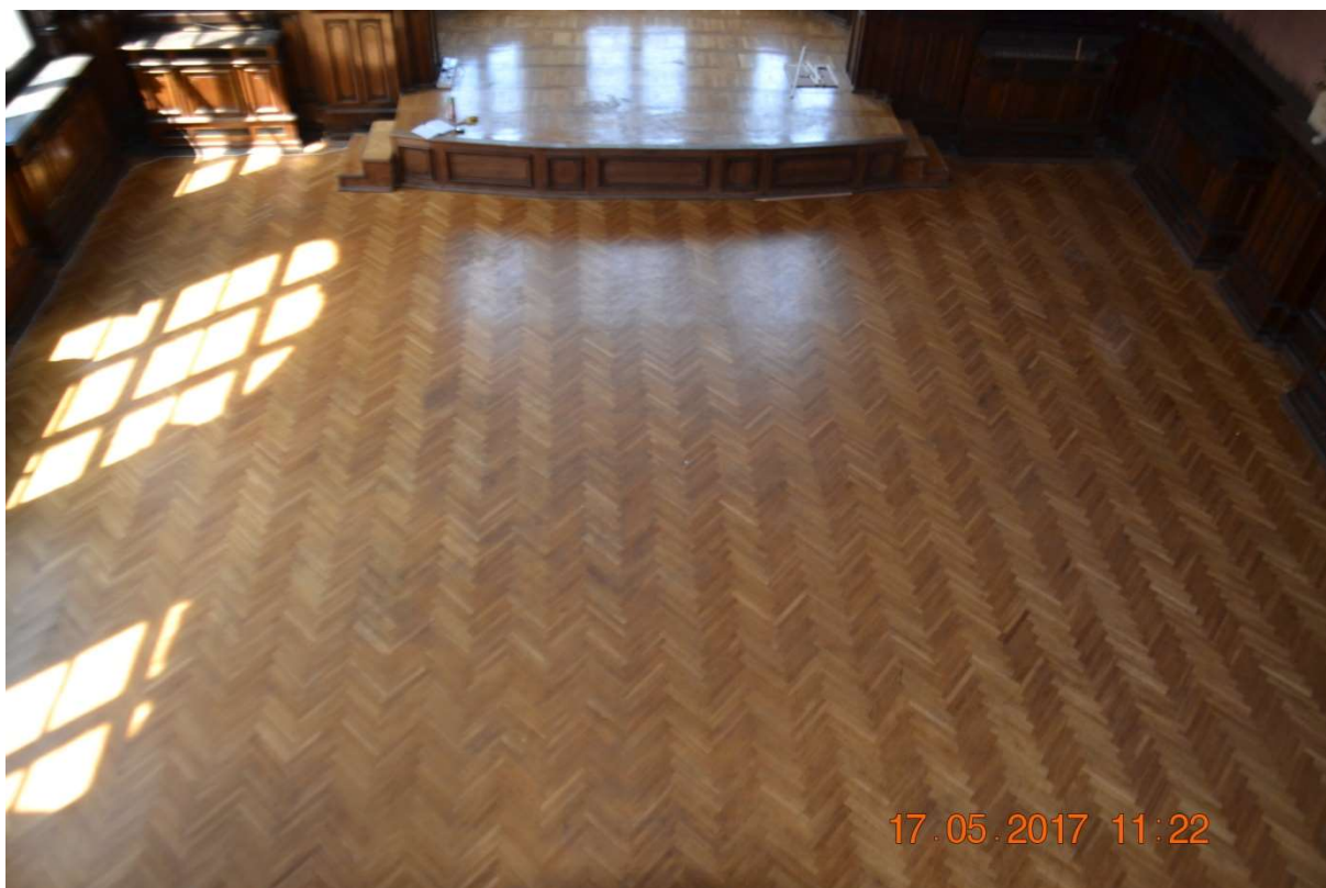
Fot.12 Widok posadzki drewnianej.
