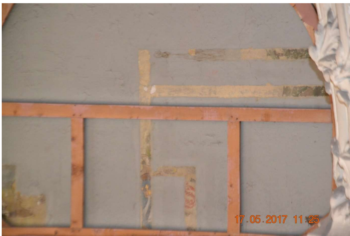
Fot.15 Odkrywka na ścianie północnej.
