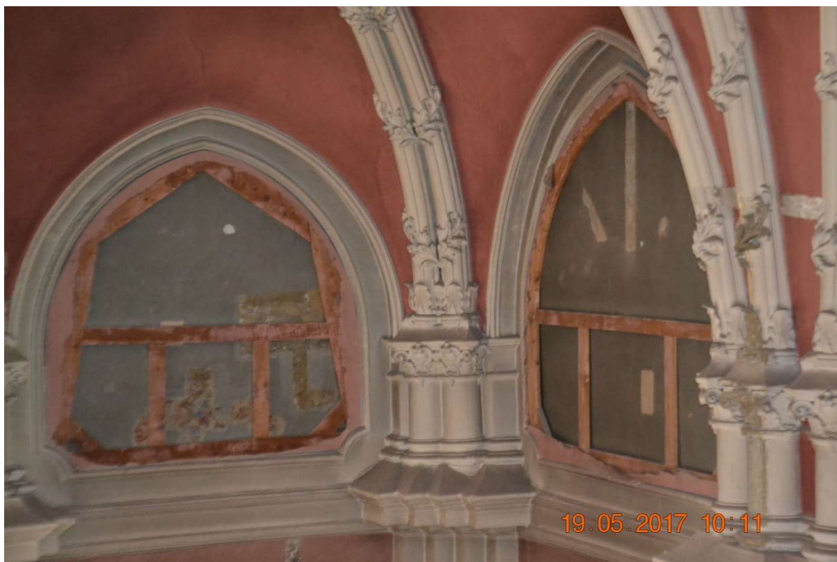
Fot.18 Narożnik północno-zachodni, po prawej stronie odkrywki pasowe, nie odsłoniły polichromii? Być może warstwa została zmyta ? brak śladów malatur.
