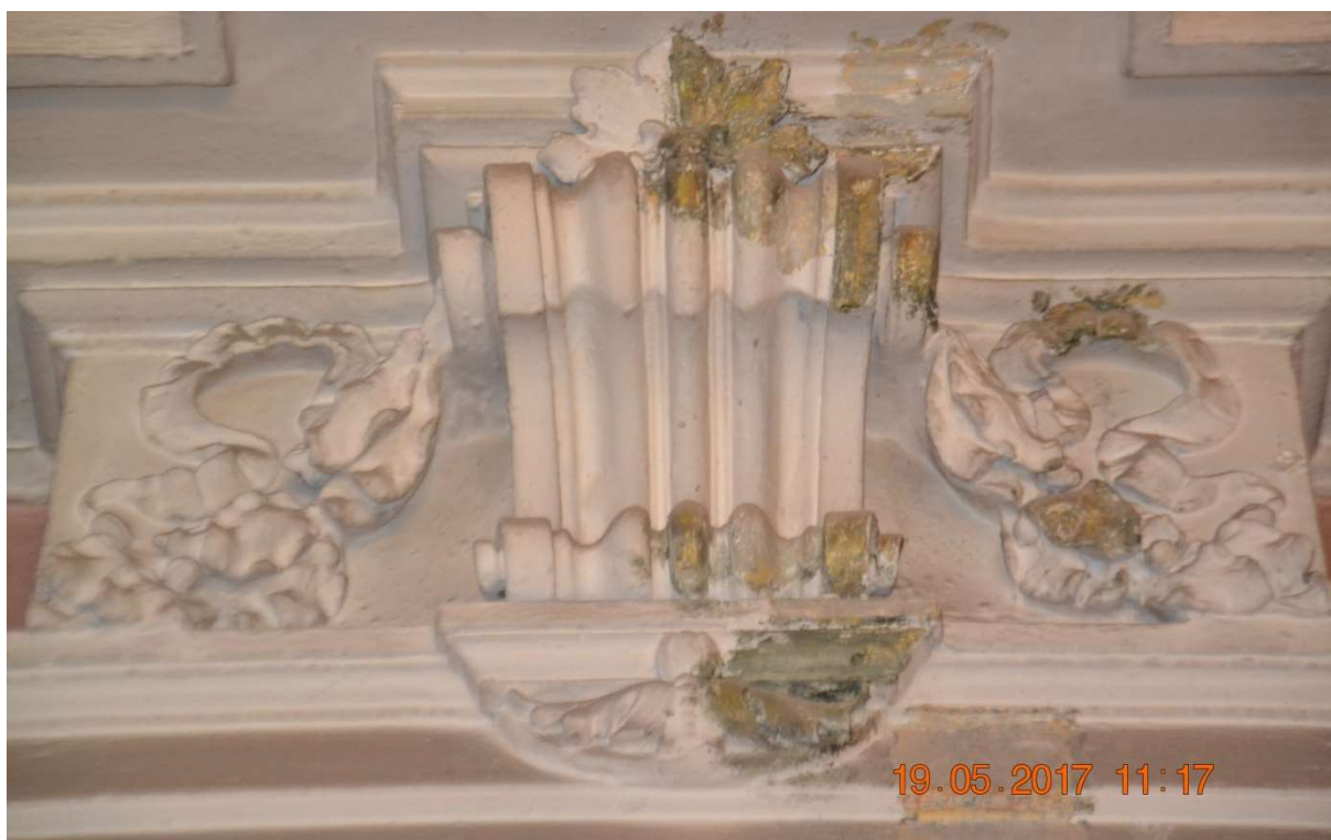
Fot.21 Odkrywki sondażowe na zworniku gzymsu kierowanego, ściana północna. Element polichromowany i w dużej części złocony, na krawędziach, w partii kwiatonów i wstęg.
