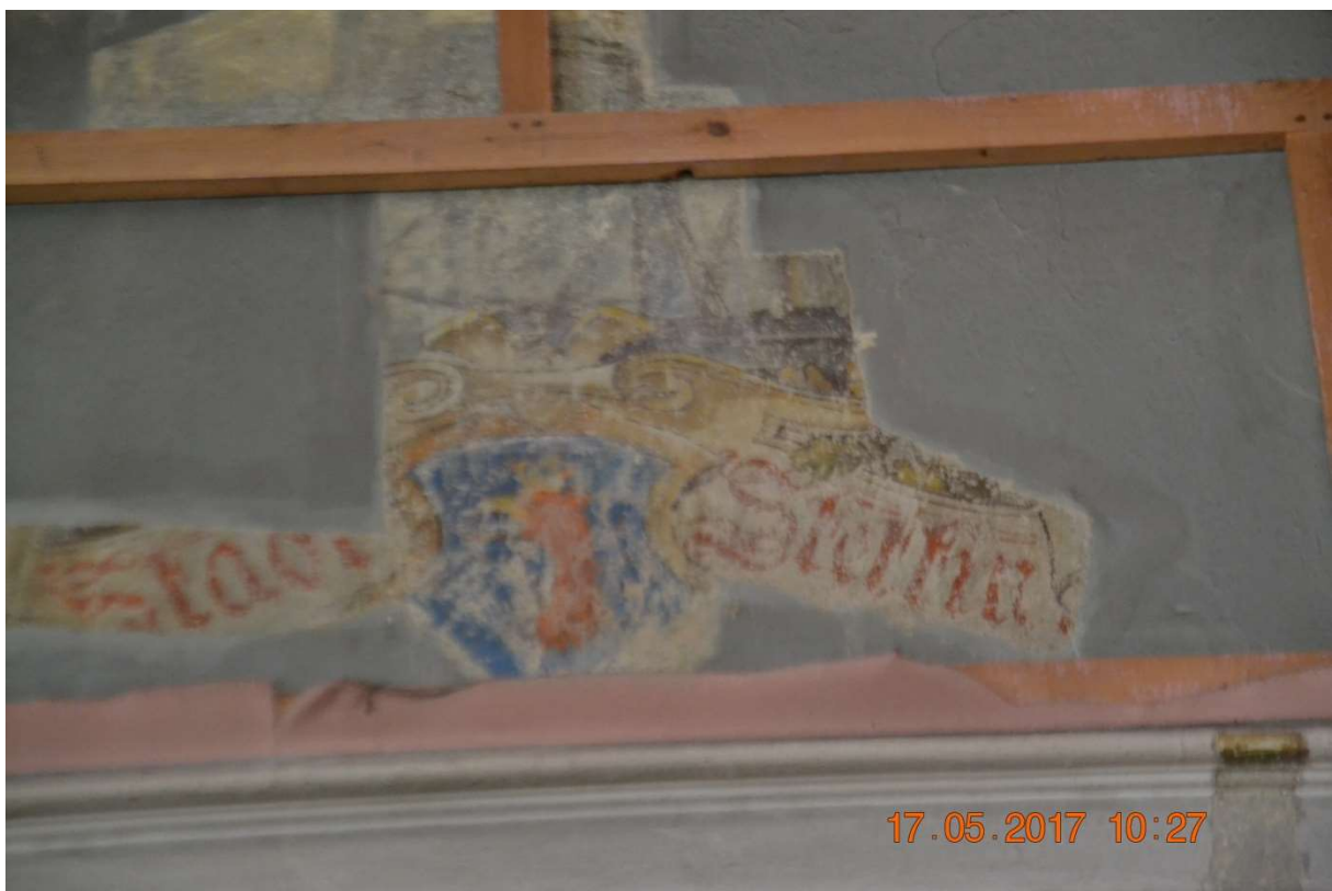
Fot.17 Odkrywki pasowe w ścianie zachodniej, odstawiają herb Szczecina.
