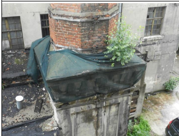
Fot.09. Zabezpieczenie podstawy komina za pomocą siatkowania, widoczne samosiejki.
