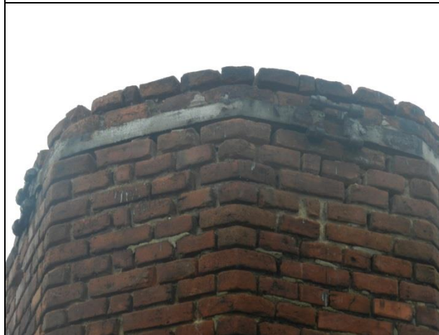
Fot.10. Brak zabezpieczenia głowicy komina przed oddziaływaniem warunków atmosferycznych.
