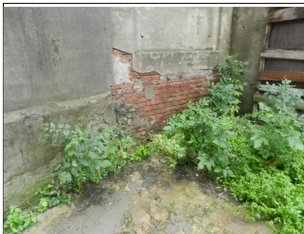
Fot. 06. Uszkodzenie wyprawy tynkarskiej na podstawie komina
