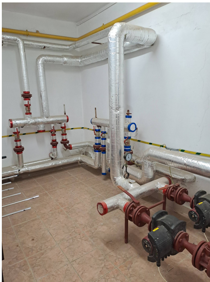
Zdj. nr 5 Istniejące rozdzielacze c.o.
