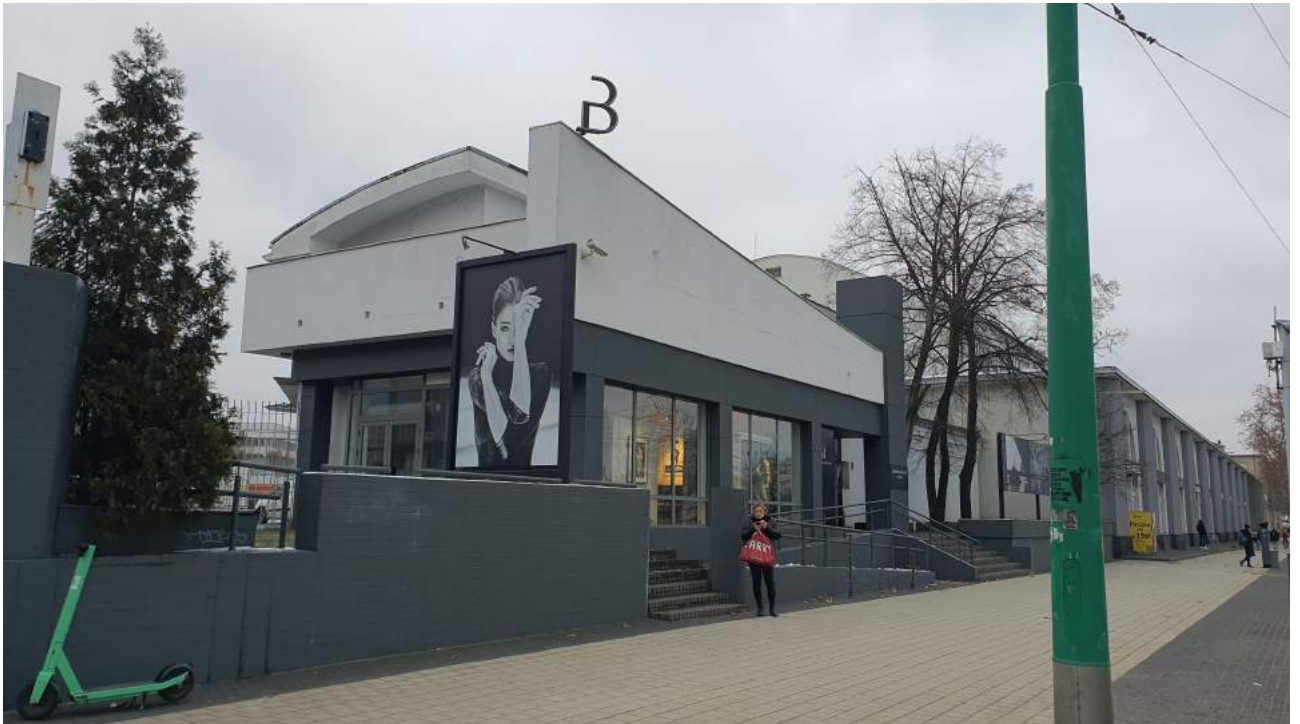
WIDOK 3 – od strony ulicy Głogowskiej w kierunku wschodnim
