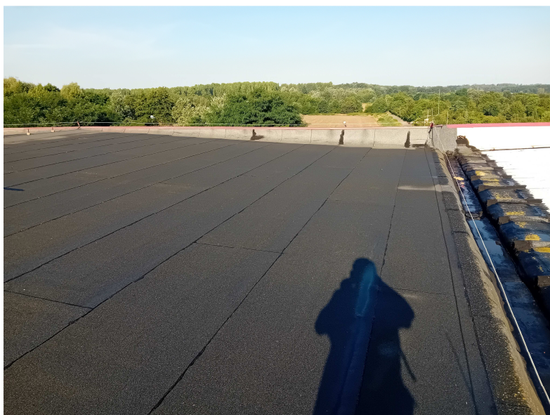
Dach nad częścią sportowa – część kryta papą termozgrzewalną
