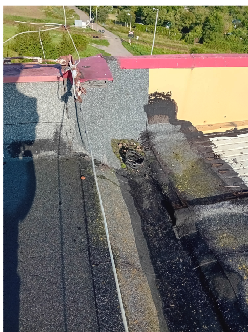
Uszkodzenia wpustów dachowych, koryta dachowego i pęknięcia pokrycia z papy termozgrzewalnej
