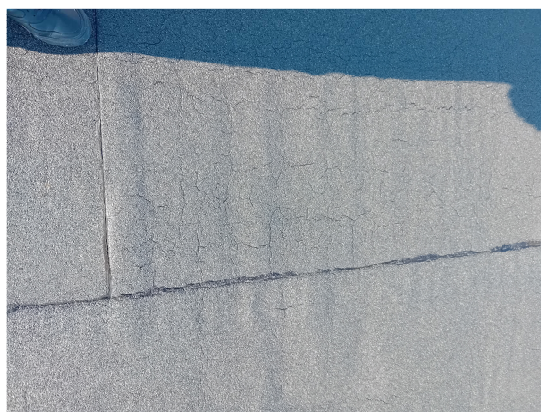
Uszkodzenia wpustów dachowych, koryta dachowego i pęknięcia pokrycia z papy termozgrzewalnej
