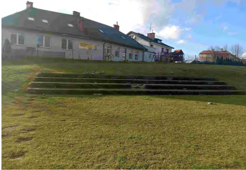
Trybunka z elementów betonowych – do rozebrania
