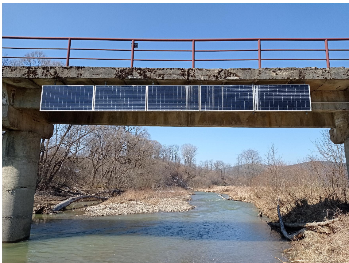
Fot. 6. Widok przęsła nr 3 (przęsło nurtowe z zamontowanymi panelami fotowoltaicznymi)
