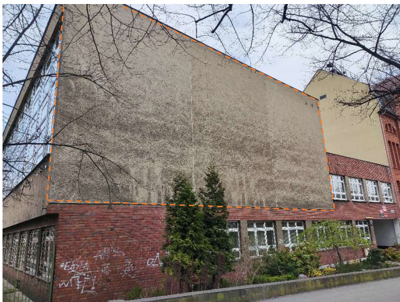
Fot 1. Ściana, na której ma być wykonany mural (część górna, otynkowana)
