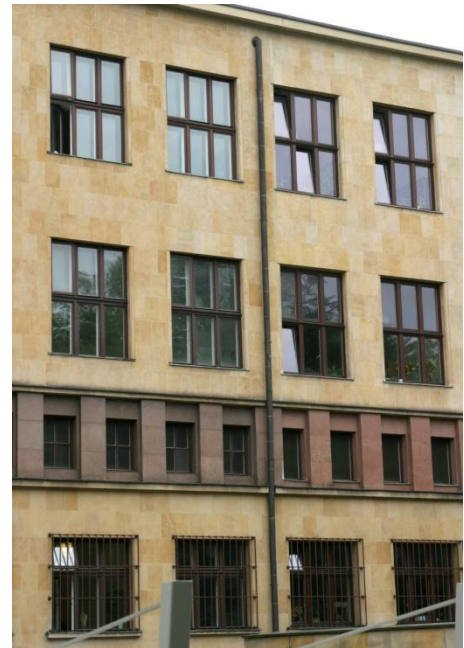
PORÓWNANIE OKIEN SKRZYNKOWYCH (PO LEWEJ) I NOWYCH OKIEN JEDNORAMOWYCH (PO PRAWEJ)
