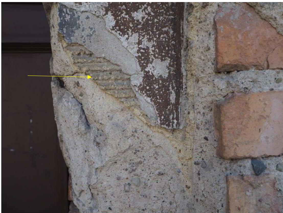
Fot. 10. Gorzów Wlkp. ul. Drzymały 32, fasada, portal, widoczna beżowa warstwa tynku barwiona w masie i profilowana (wyk. P. Antoniuk).
