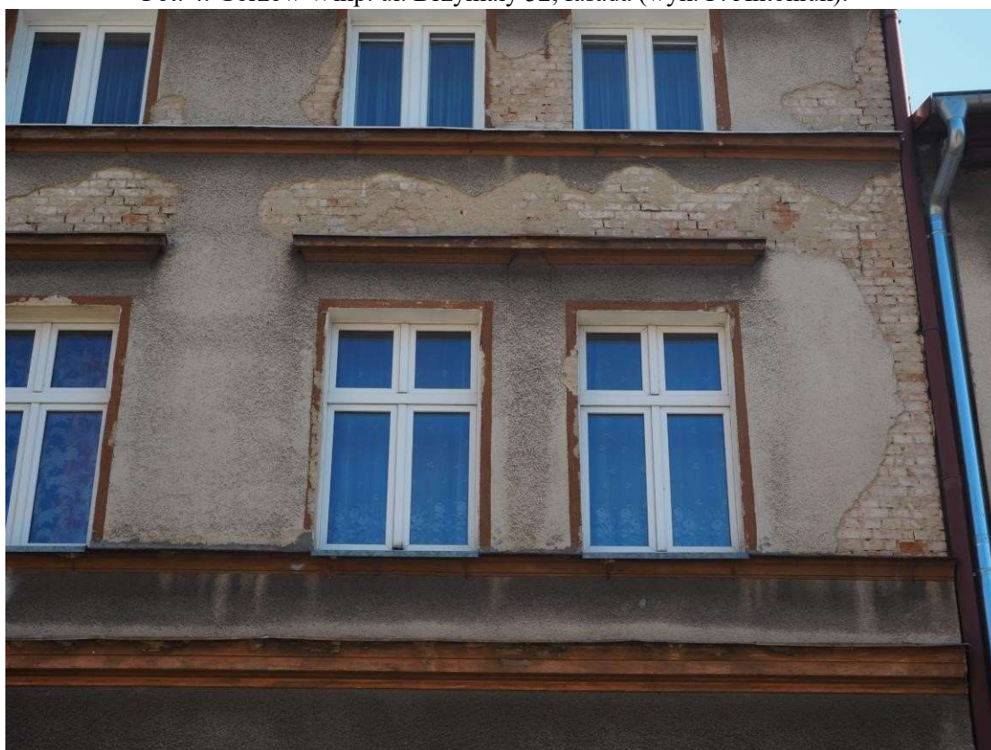
Fot. 5. Gorzów Wlkp. ul. Drzymały 32, fasada, połączone naczółki skrajnych okien trzeciej kondygnacji, ubytki tynku (wyk. P. Antoniuk).
