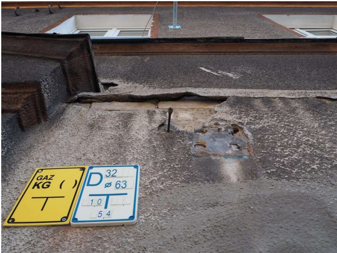
Fot. 8. Gorzów Wlkp. ul. Drzymały 32, fasada, odspojenia tynków, otwory po tablicach informacyjnych (wyk. P. Antoniuk).
