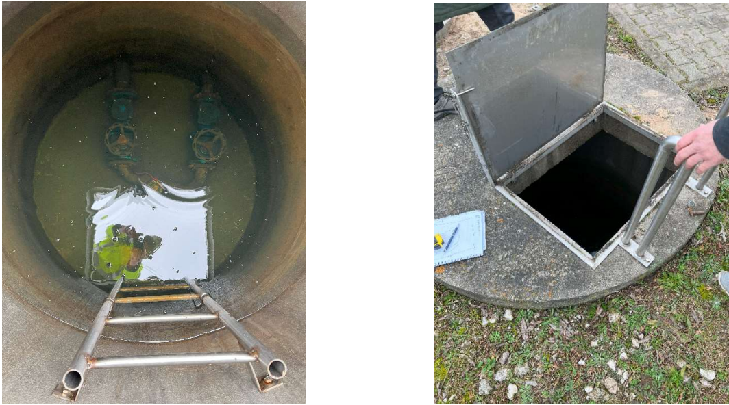
Rys. 10. Przepompownia PS (P1) Flantrowo– stan istniejący.
