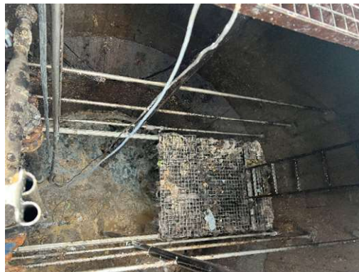
Rys. 2. Przepompownia PS ul. Kręta – stan istniejący.
