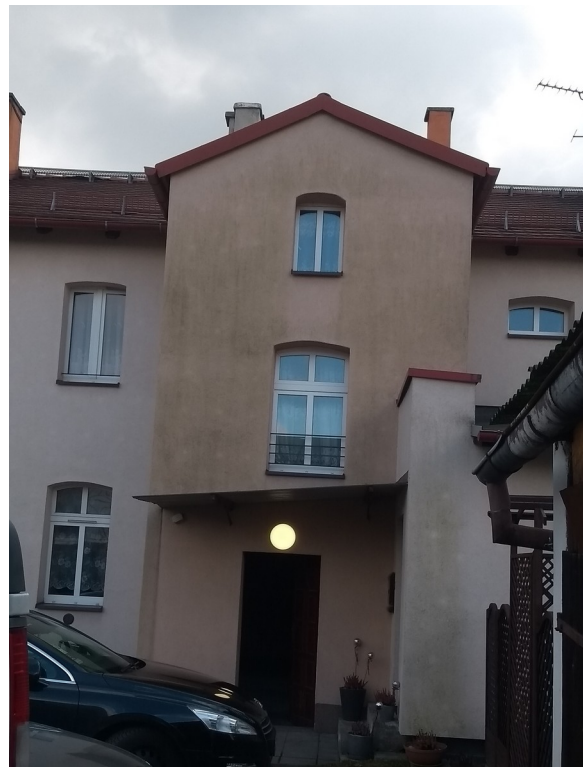
WYKUSZ KLATKI SCHODOWEJ
