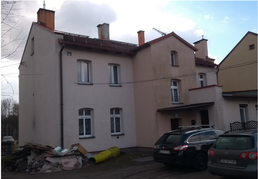
WIDOK OD STRONY PODWÓRZA
