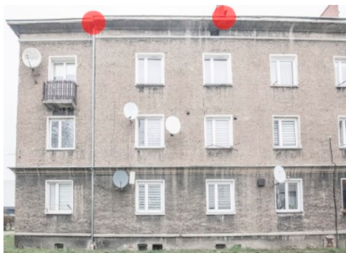
Fot. 5. Budynek ul. Wojska Polskiego 3, 3a w Tarnowskich Górach Zaznaczono potencjalne siedliska łęgowe jerzyka - czerwone punkty.
