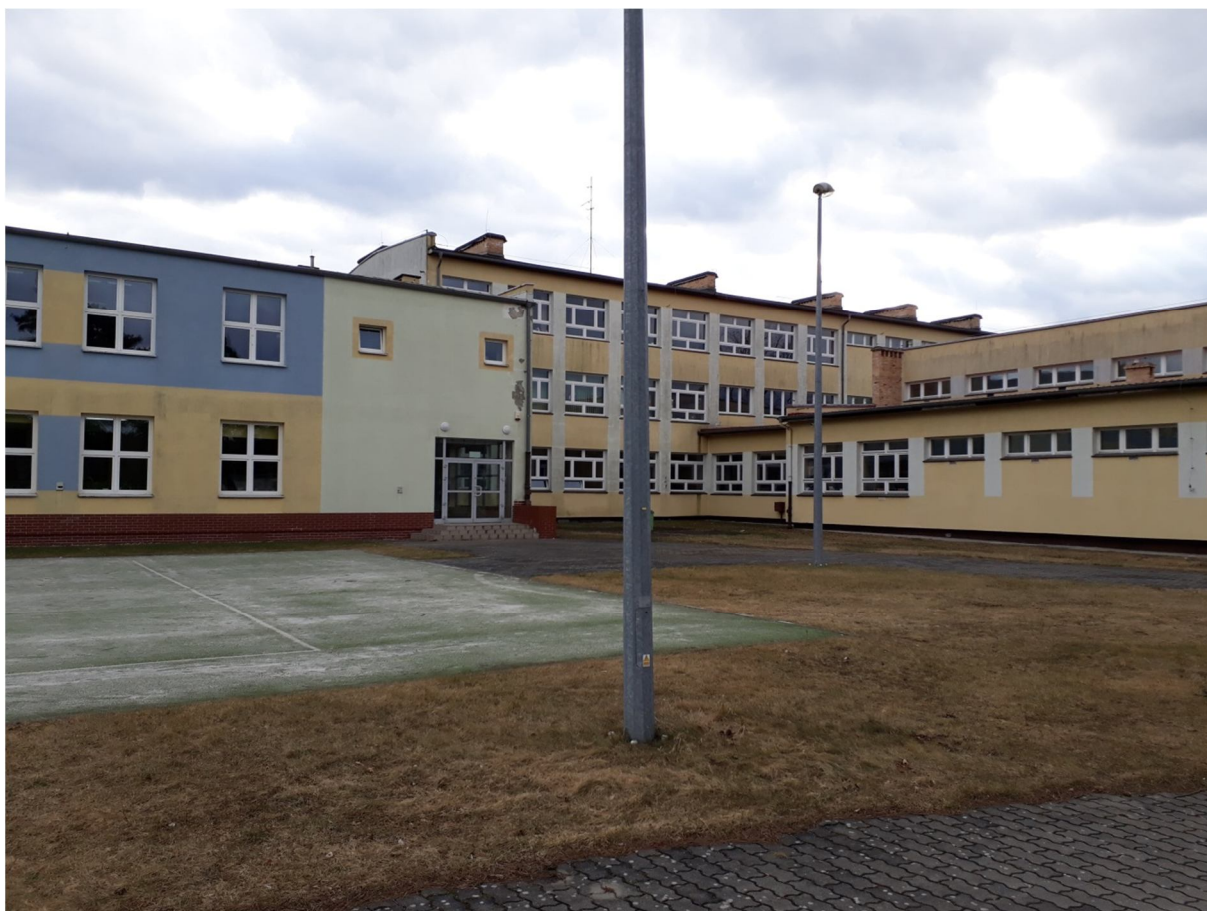
Zdjęcie nr 17 – Widok od północy na budynek D, A i B. Widoczna tylna strefa wejściowa do budynku D.
