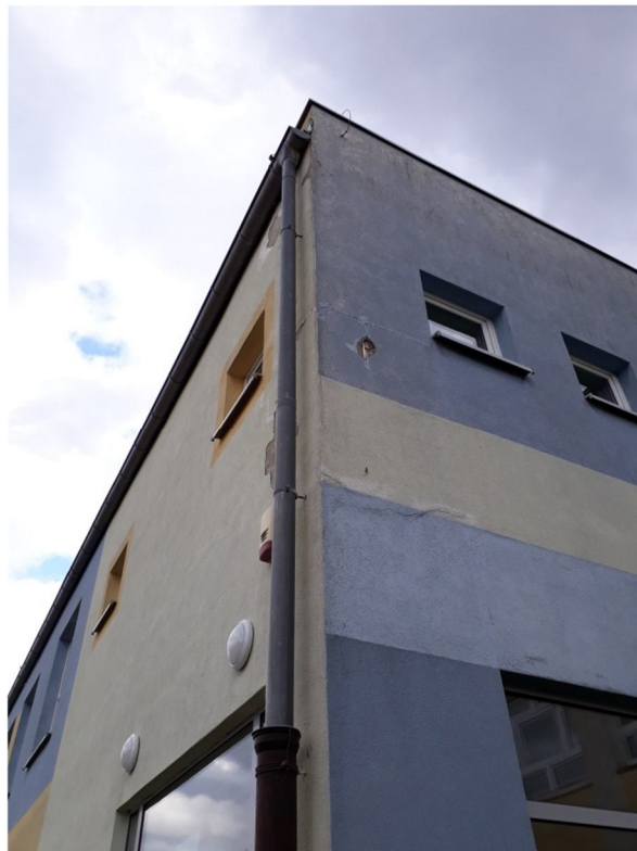
Zdjęcie nr 18 i 19 – Widok na narożnik budynku D, przy tylnej strefie wejściowej. Widoczne uszkodzenia tynku przewidziane do naprawy.
