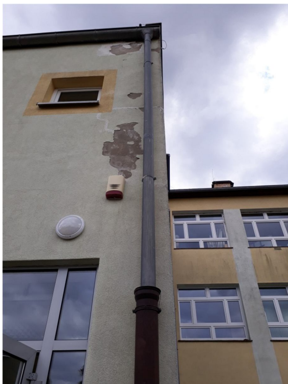
Zdjęcie nr 18 i 19 – Widok na narożnik budynku D, przy tylnej strefie wejściowej. Widoczne uszkodzenia tynku przewidziane do naprawy.
