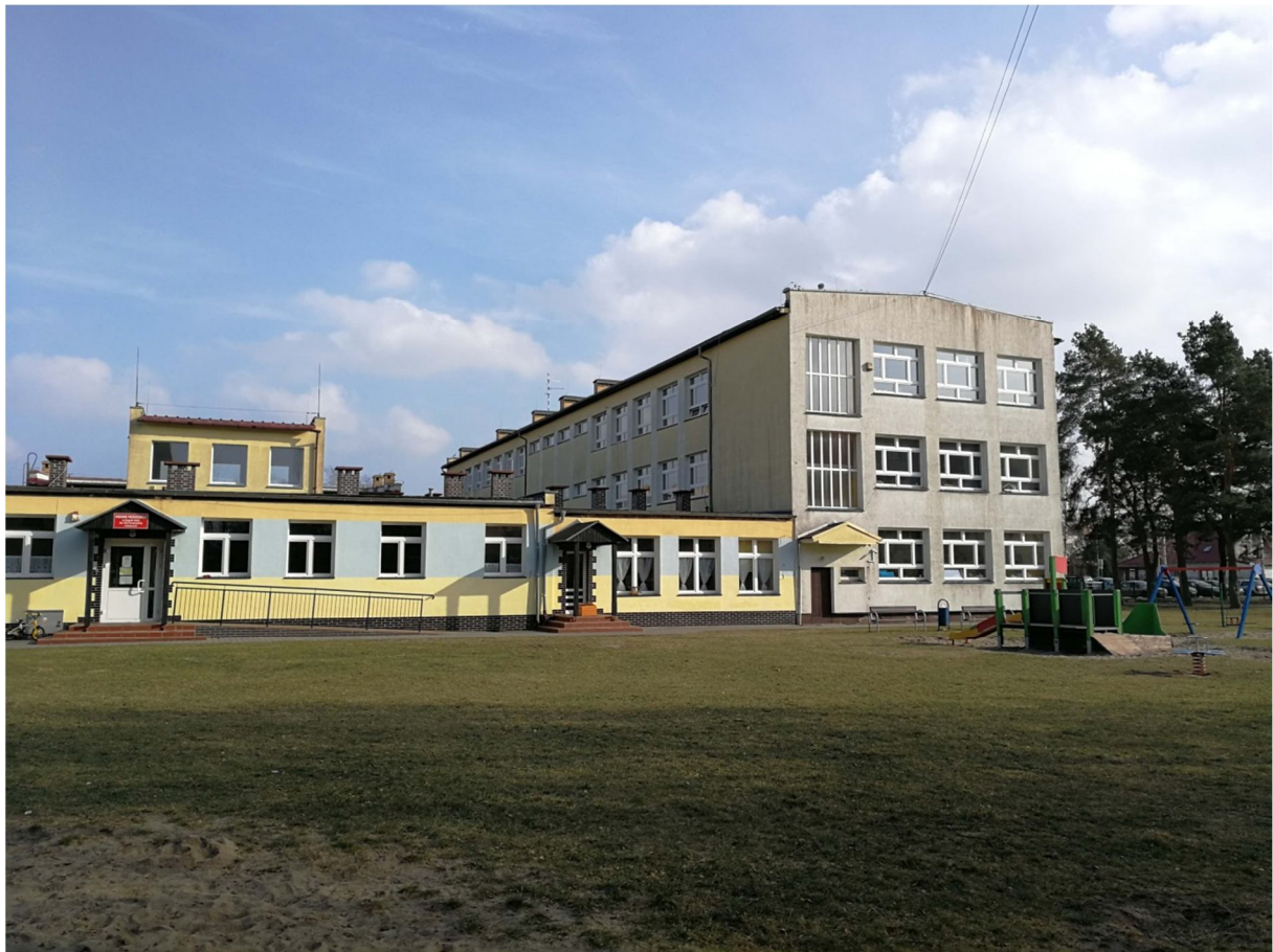
Zdjęcie nr 37 – Widok na pierwszym planie na elewację wschodnią budynków A i C. W głębi widok na elewację północną budynku A.
