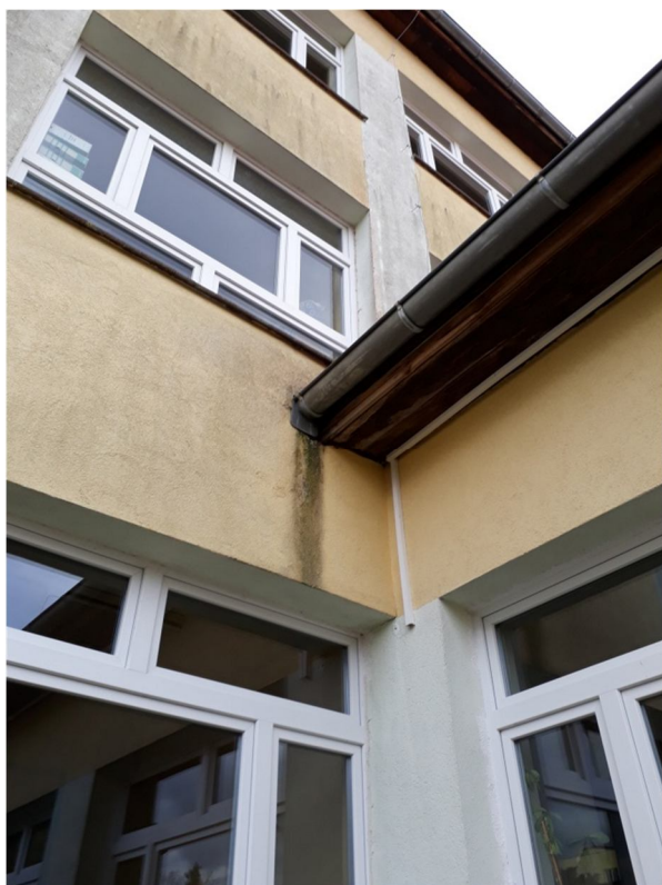
Zdjęcie nr 20 i 21 – Widok na narożnik budynku A i B. Widoczne nieszczelności rynny i rury spustowej do naprawy. Rura spustowa po prawej do wymiany na stalową w kolorze rynny.
