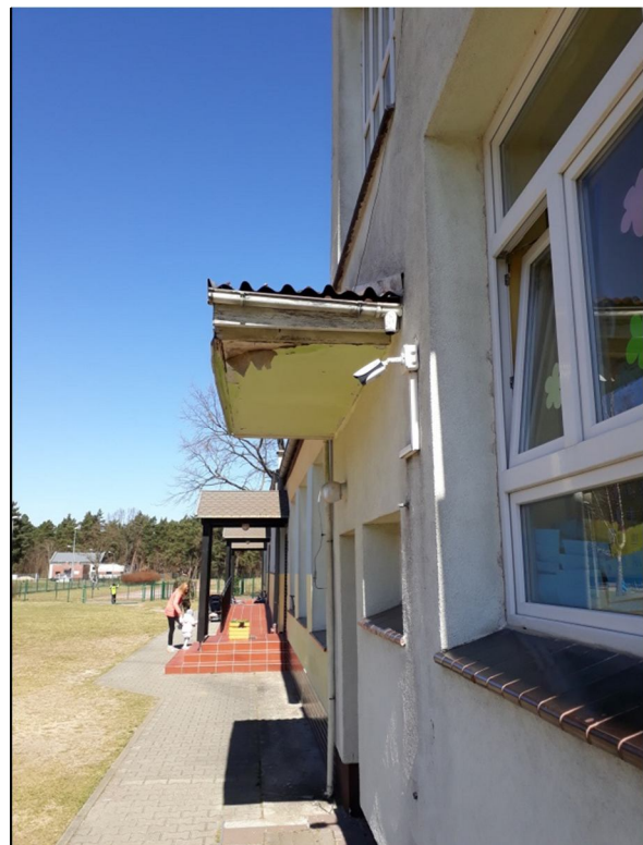
Zdjęcie nr 35 i 36 – Widok na elewację wschodnią budynku A oraz zadaszenie nad drzwiami wejściowymi. Przewiduje się likwidację zadaszenia ze względu na zły stan techniczny.
