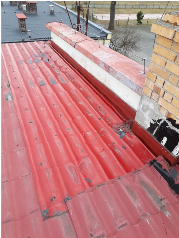
Zdjęcie nr 41 – Widok na nieuszczelne pokrycie dachowe i brak obróbki blacharskiej attyki w budynku B. Zdjęcie nr 42 - Widok na istniejącą po drugiej stronie połaci obróbkę blacharską attyki w budynku B.
