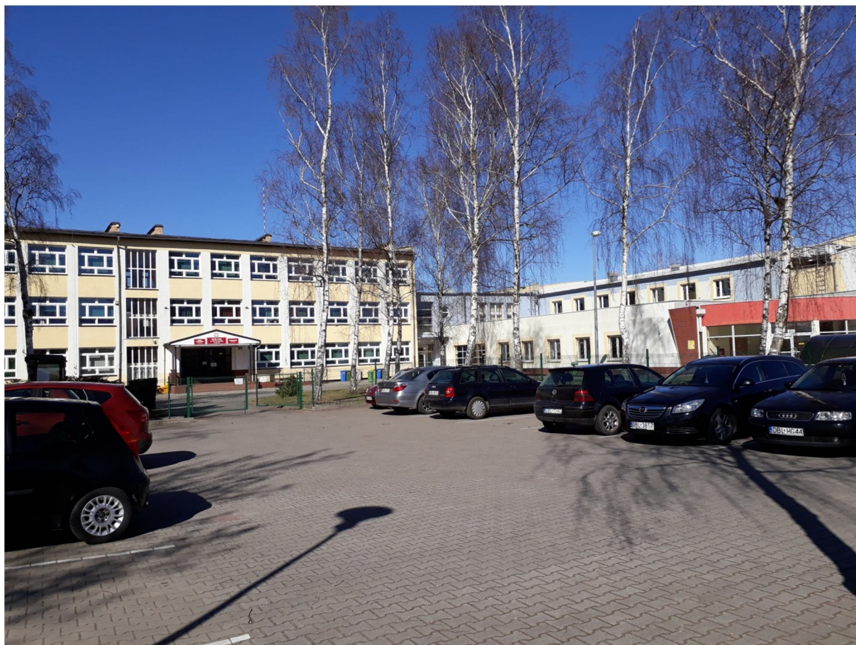
Zdjęcie nr 3 – Widok od ulicy Szkolnej na budynek A i D, po prawej niższy budynek D.
