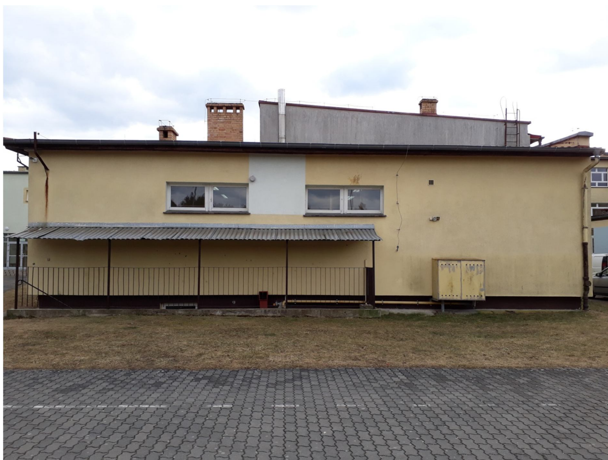
Zdjęcie nr 23 – Widok na elewację północną budynku B. Widoczny na pierwszym planie daszek zejścia do piwnicy, przewiduje się wymianę jego pokrycia na nowe.
