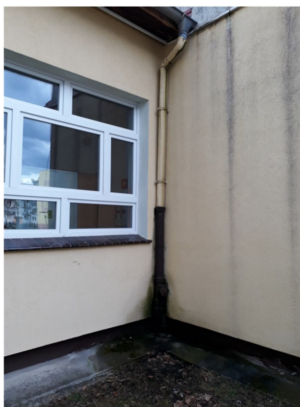
Zdjęcie nr 20 i 21 – Widok na narożnik budynku A i B. Widoczne nieszczelności rynny i rury spustowej do naprawy. Rura spustowa po prawej do wymiany na stalową w kolorze rynny.
