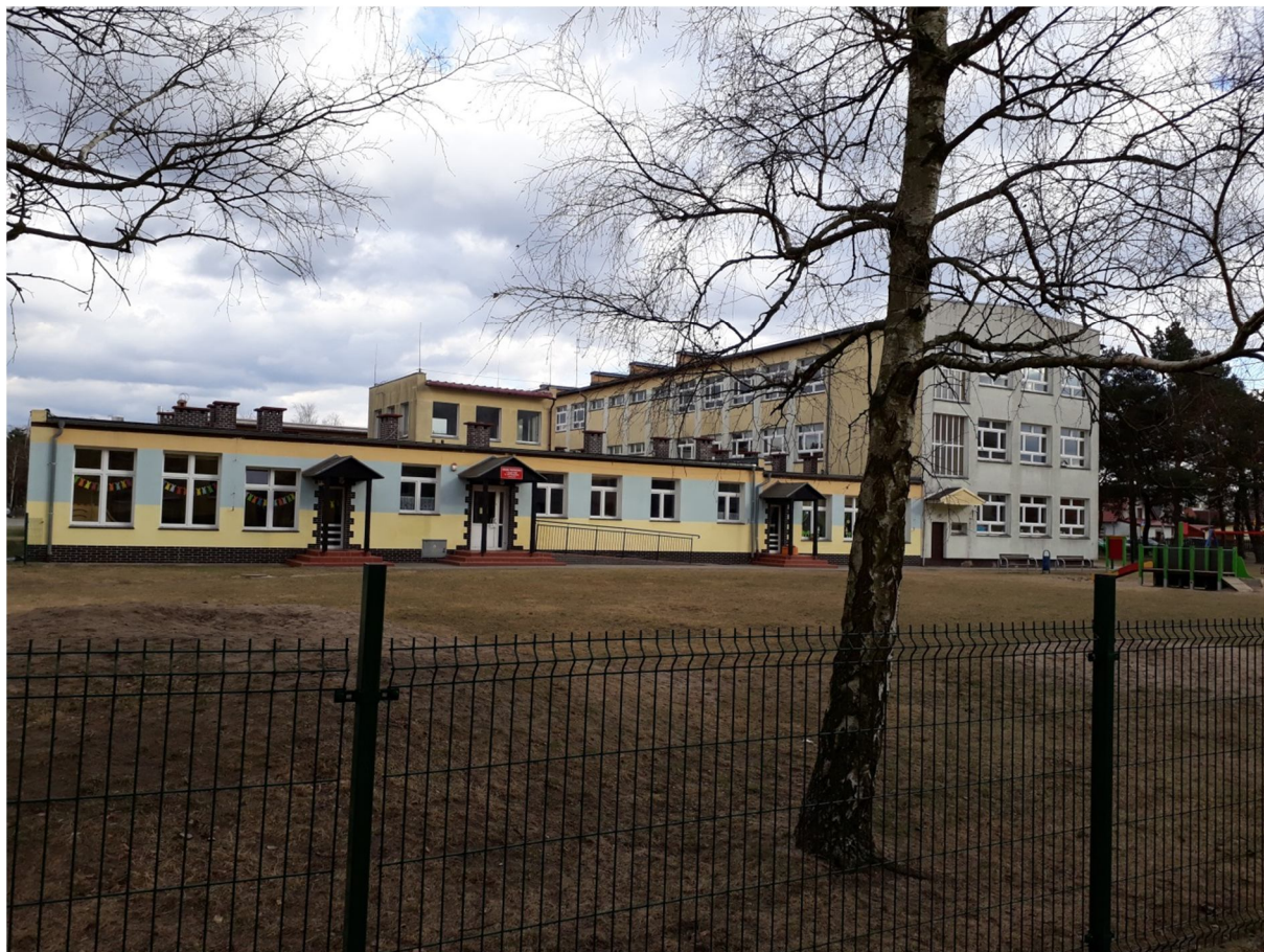
Zdjęcie nr 32 – Widok na elewację wschodnią budynków A i C.
