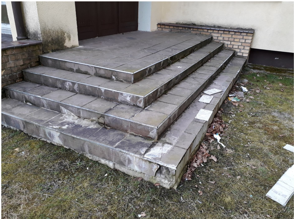
Zdjęcie nr 27 – Widok schodów wejściowych do budynku B. Przewiduje się wykonanie nowej nawierzchni z płytek ceramicznych. Sąsiadujące murki należy wykończyć tynkiem mozaikowym na ściankach oraz zwieńczyć kształtkami ceramicznymi od góry.
