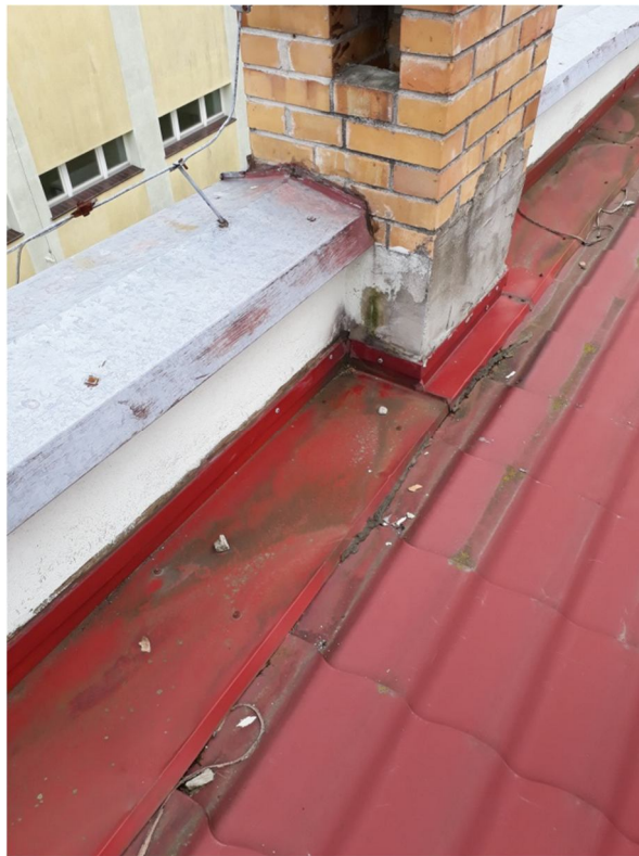
Zdjęcie nr 41 – Widok na nieuszczelne pokrycie dachowe i brak obróbki blacharskiej attyki w budynku B. Zdjęcie nr 42 - Widok na istniejącą po drugiej stronie połaci obróbkę blacharską attyki w budynku B.
