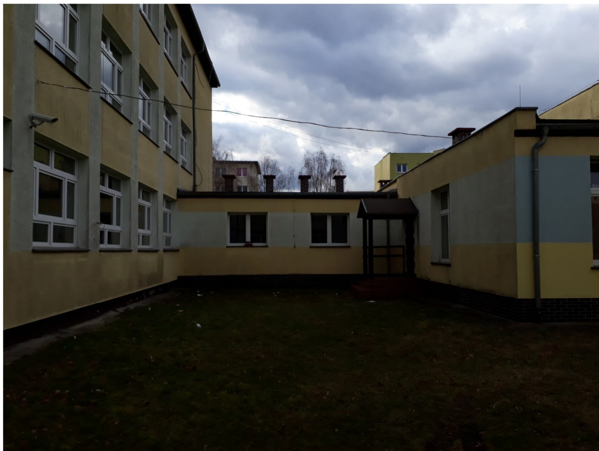
Zdjęcie nr 28 – Widok na łącznik pomiędzy budynkiem A i C.
