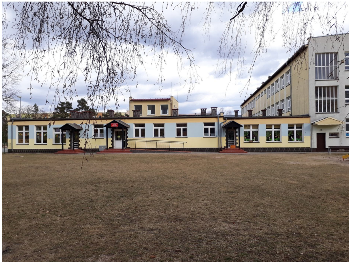
Zdjęcie nr 33 – Widok na elewację wschodnią budynku C. Widoczne trzy strefy wejściowe do budynku C.
