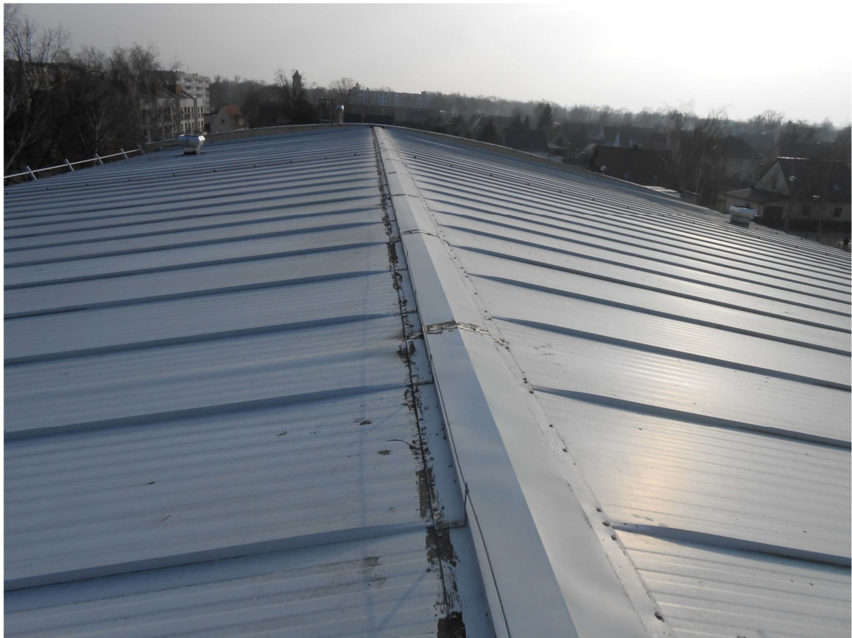
Zdjęcie nr 48 – Widok na pokrycie dachowe sali gimnastycznej budynku D.
