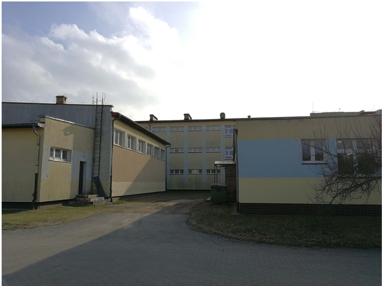
Zdjęcie nr 24 – Widok na przestrzeń pomiędzy budynkiem B i C. Po lewej widać schody do budynku B, przewiduje się wymianę ich nawierzchni. Obok schodów drabina do pomalowania na kolor szary jasny.
