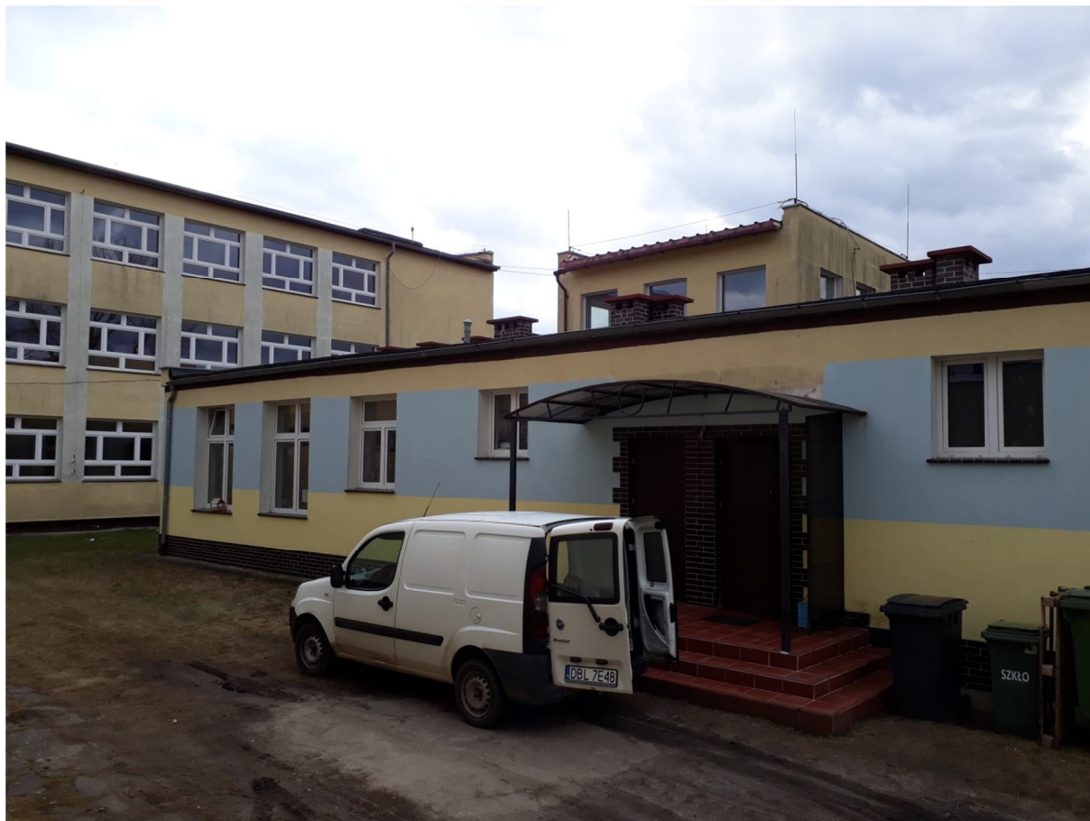
Zdjęcie nr 30 – Widok na zadaszenie przewidziane do zmiany na jednoszpadowe (budynek C).
