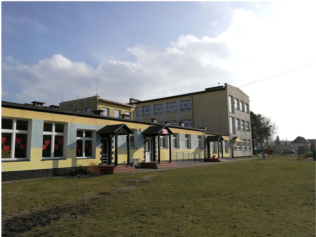
Zdjęcie nr 34 – Widok na elewację wschodnią budynku C. Widoczne z boku trzy strefy wejściowe do budynku C.
