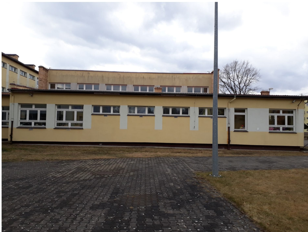
Zdjęcie nr 22 – Widok na elewację wschodnią budynku B.
