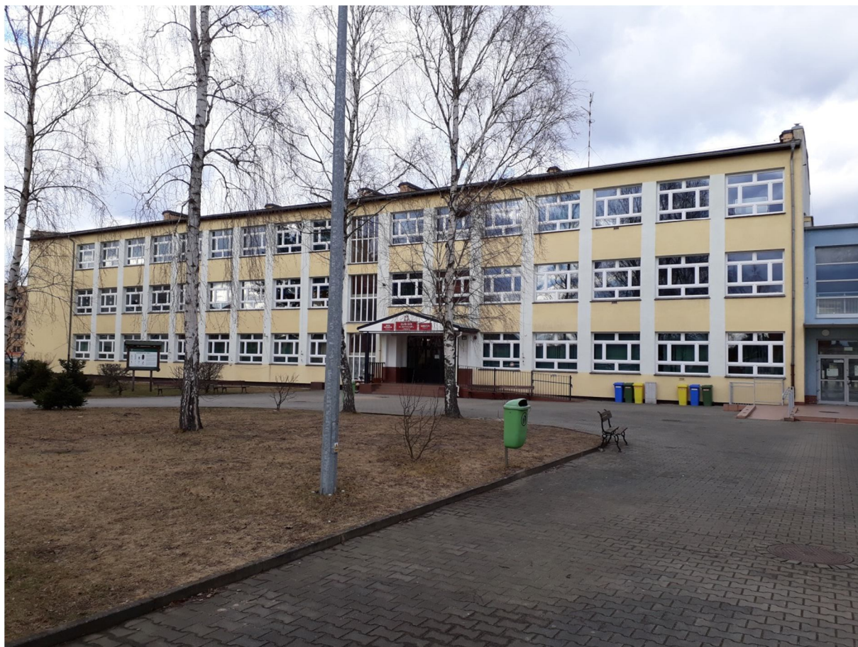
Zdjęcie nr 1 – Widok od południa na budynek A. Widoczna główna strefa wejściowa do Zespołu Szkół.
