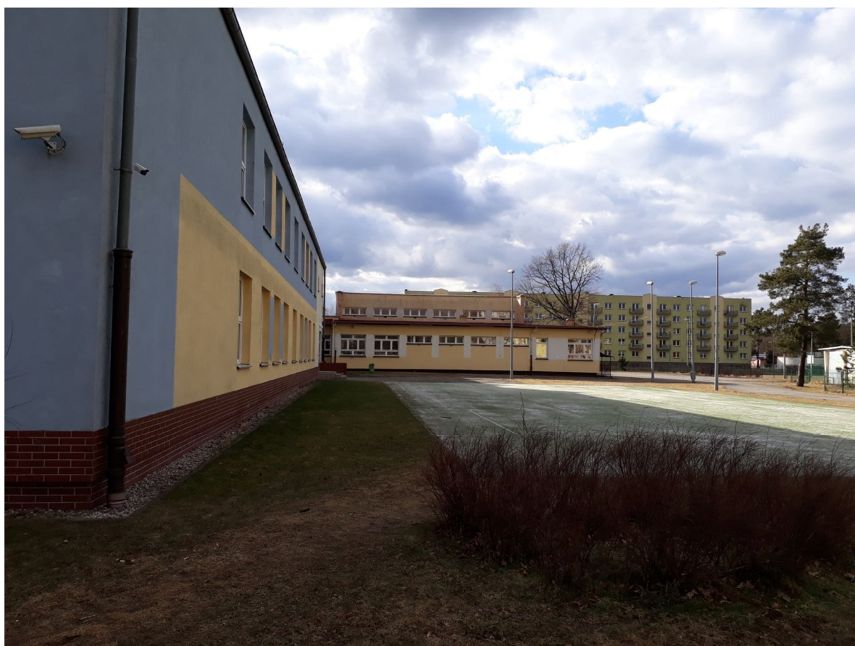
Zdjęcie nr 15 – Widok na elewację wschodnią budynku B. Po lewej stronie budynek D.
