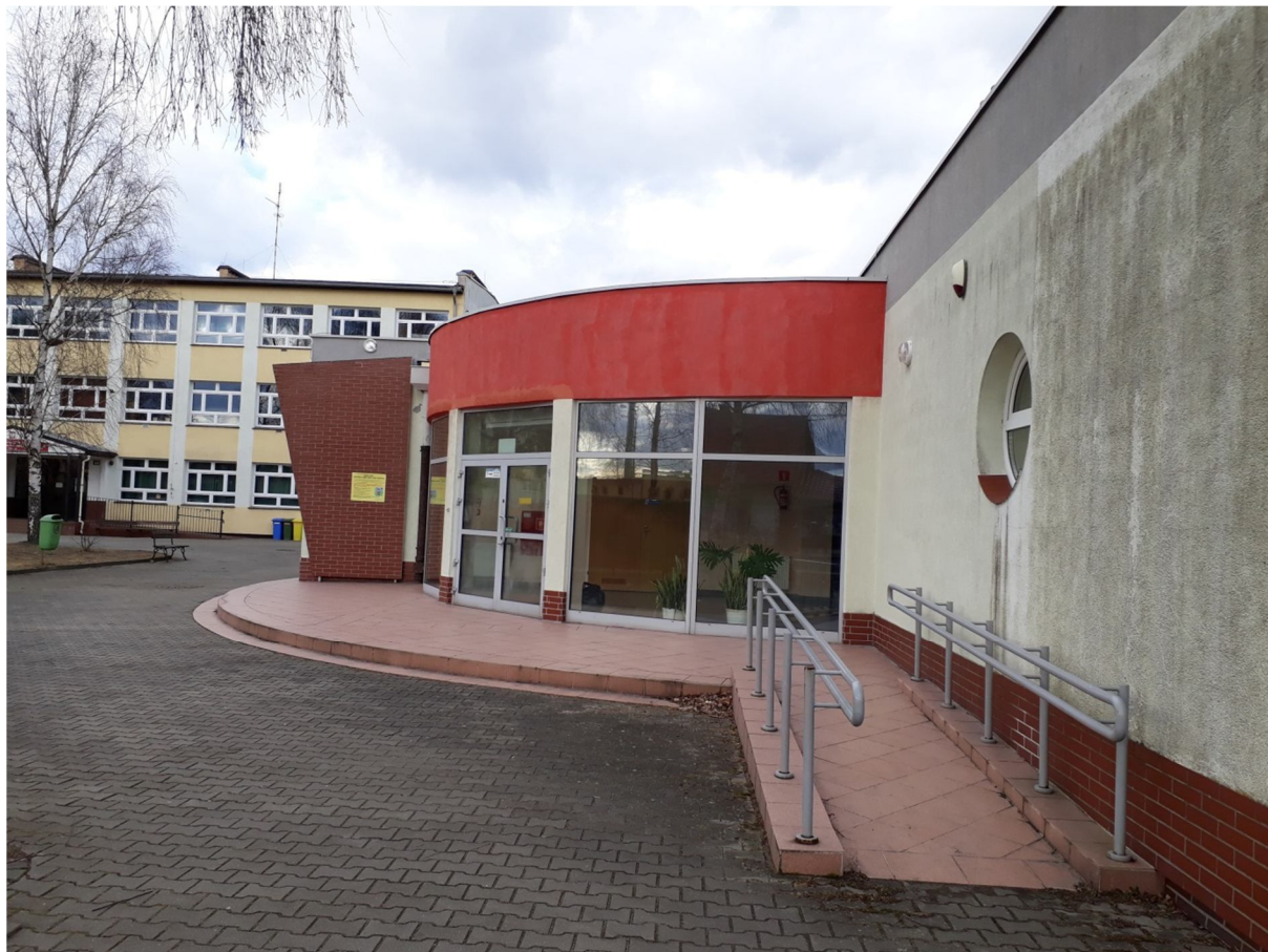
Zdjęcie nr 9 – Widok na półokrągłą strefę wejściową do budynku D.
