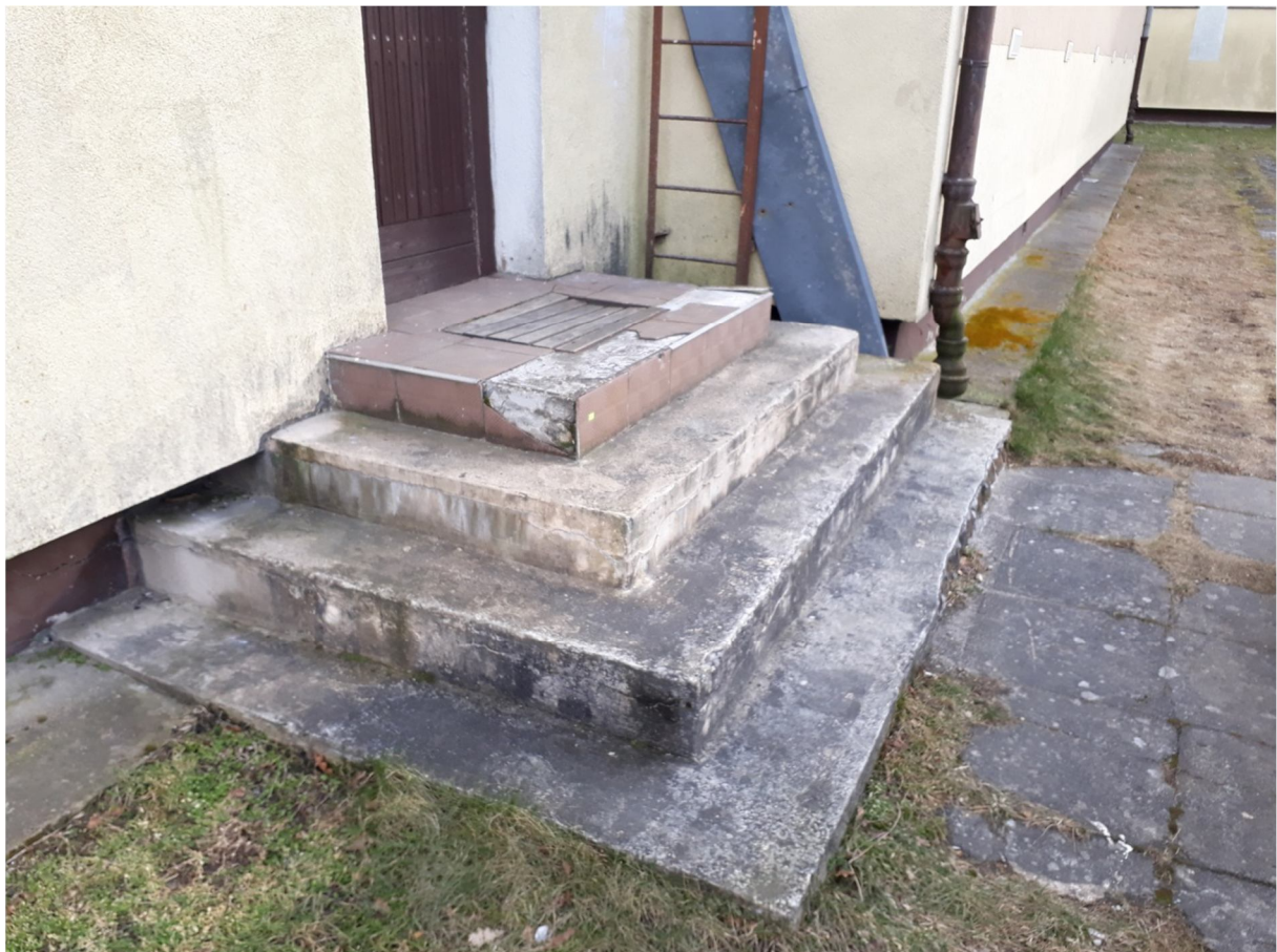
Zdjęcie nr 25 – Widok na schody do budynku B, przewiduje się wykonanie nowej nawierzchni z płytek ceramicznych.
