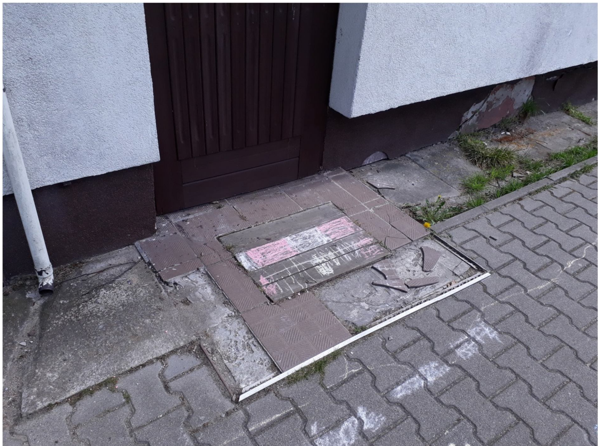
Zdjęcie nr 38 – Widok na podest wejściowy przy wschodniej ścianie szczytowej budynku A, przewidzany do wykonania od nowa.
