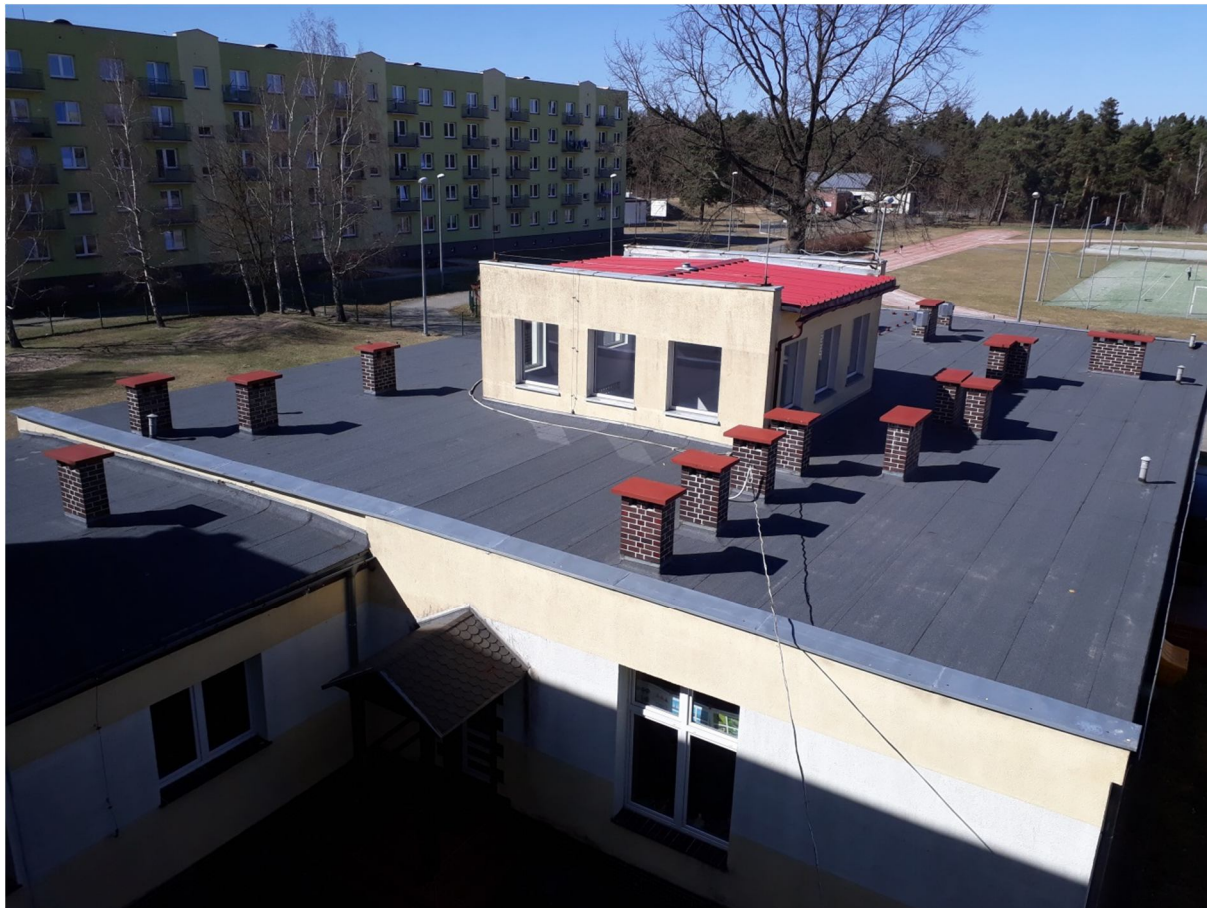
Zdjęcie nr 39 – Widok na „nadbudówkę” pełniącą funkcję doświetlenia wnętrza budynku C.
