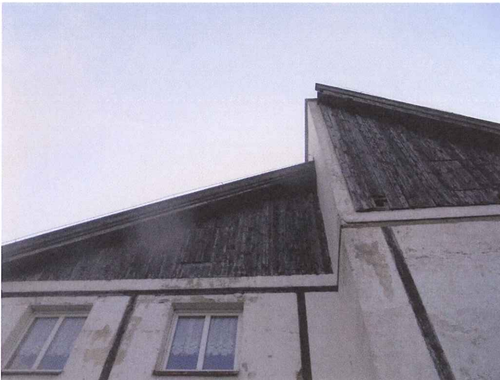
10. Szczyt poddasza oszalowany deskami .
