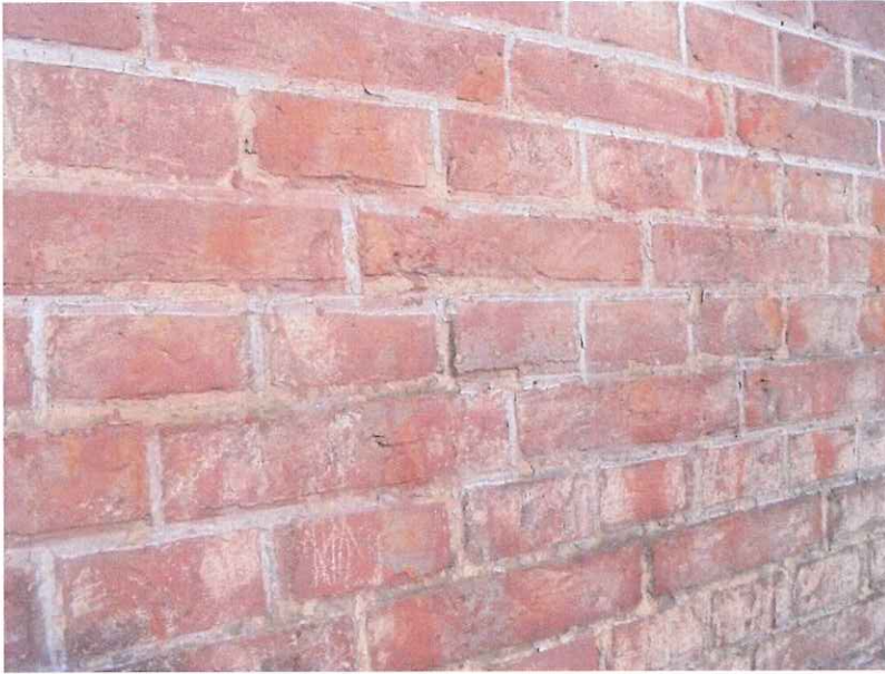
5. Lico muru ceglanego – stan cegły, spoin , ślady przemalowań i napraw.
