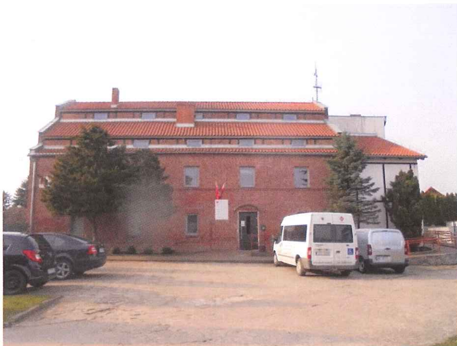
1. Elewacja północna z widoczną współczesną dobudówką
