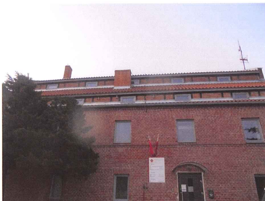
2. Elewacja północna – współczesna ahistoryczna stolarka okienna i drzwiowa. Użytkowe poddasze o konstrukcji ryglowej.
