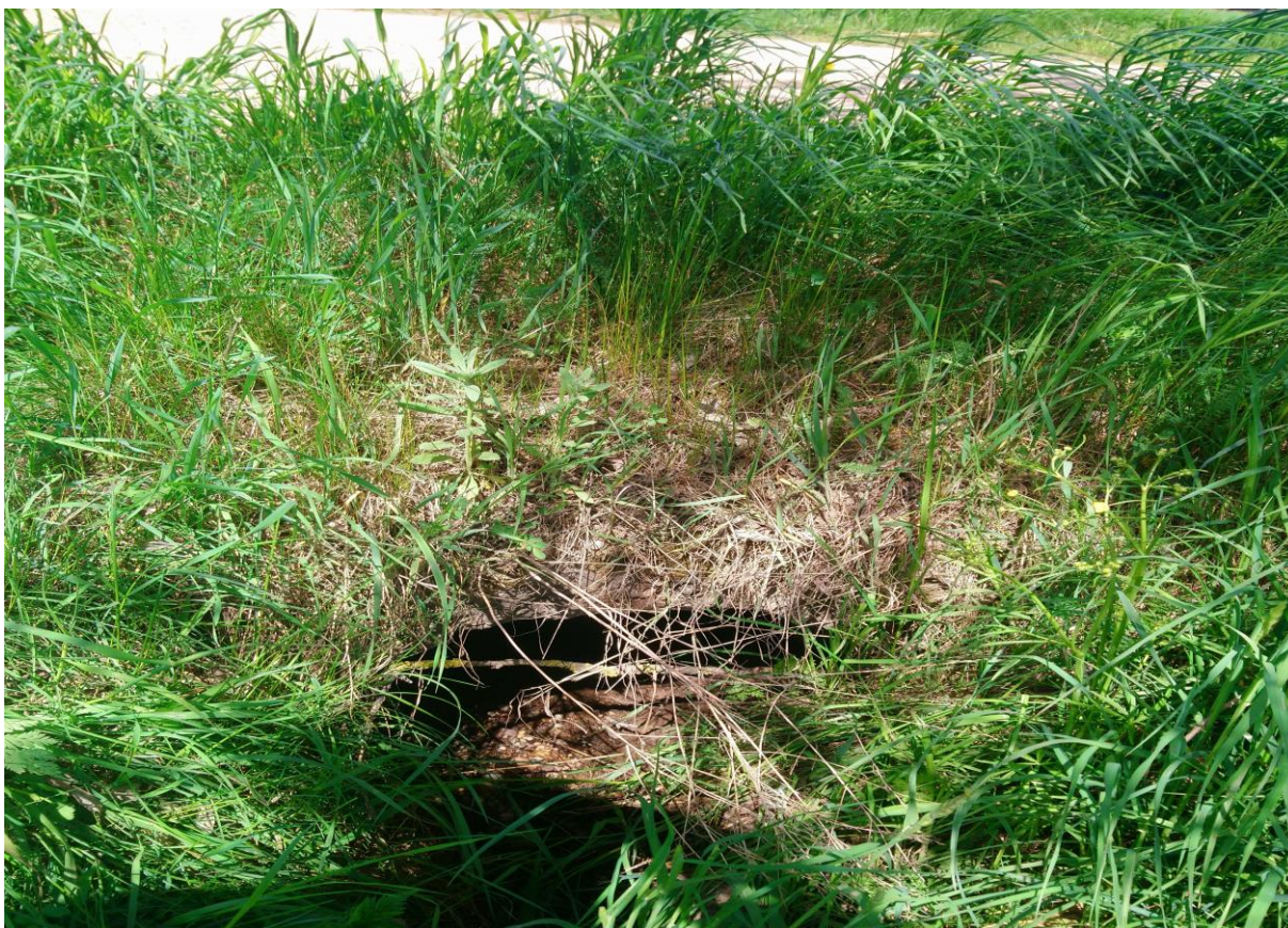
Foto nr 12 Odcinek DG 103610B – wlot przepustu \varnothing 60 o L=7,0m z kręgów żelbetowych w km 3+480.
