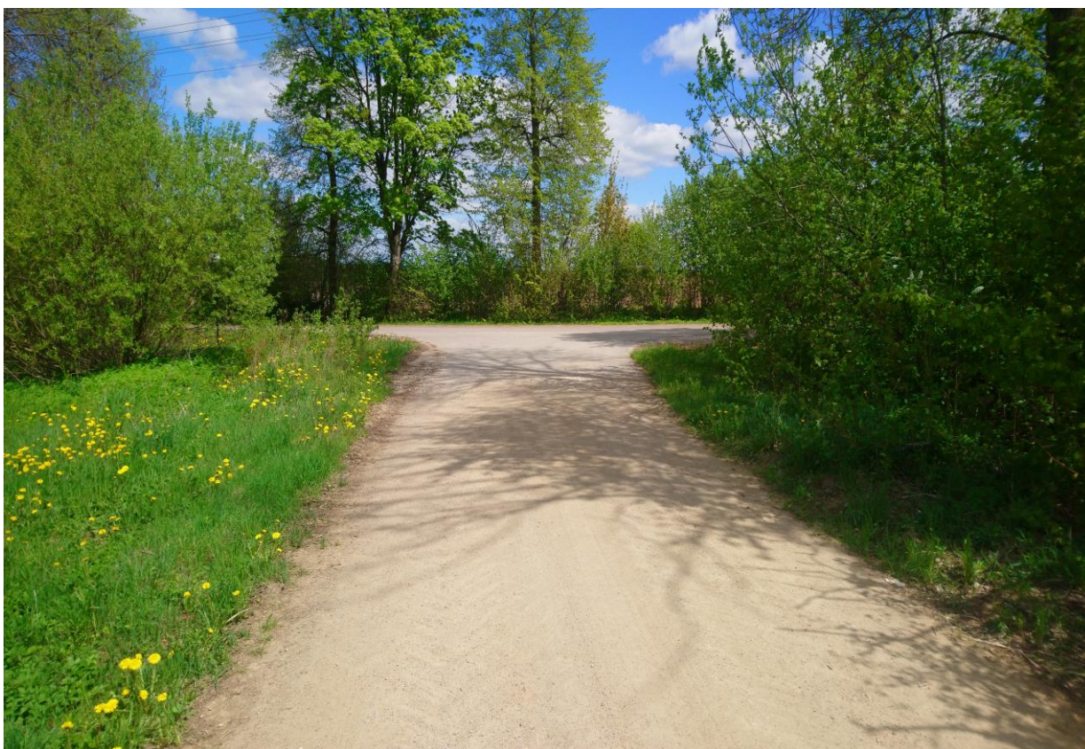
Foto nr 13 Odcinka DG 103610B z widokiem na zakończenie trasy – skrzyżowanie z drogą powiatową nr 1259B o nawierzchni bitumicznej.
