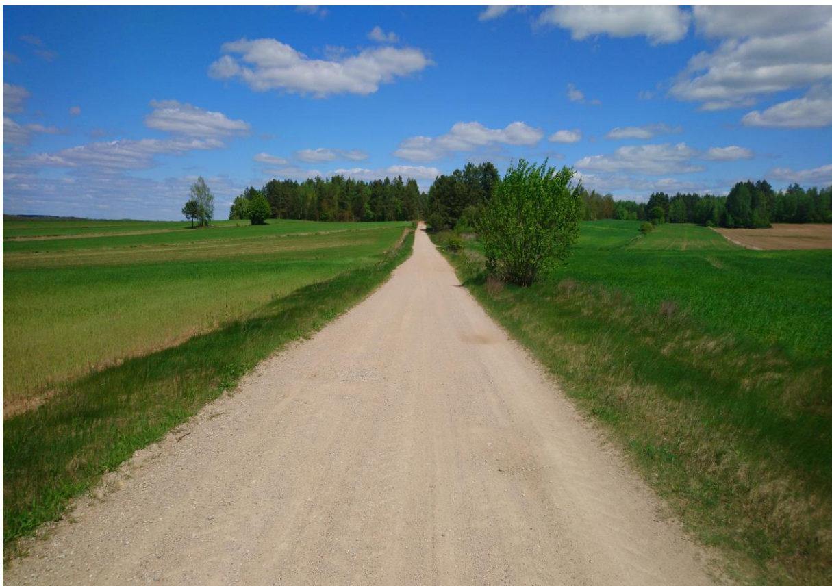
Foto nr 5 Odcinek DG 103610B w km 1+100÷1+800 o nawierzchni żwirowej – odcinek wśród pól.
