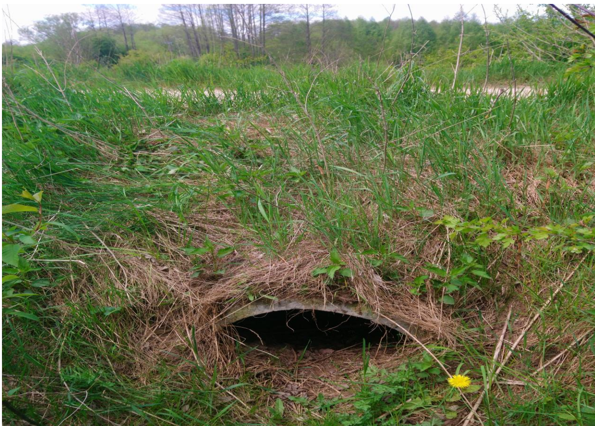
Foto nr 7 Odcinek DG 103610B – wlot przepustu Ø60 o L=7,0m z kręgów żelbetowych w km 2+020.
