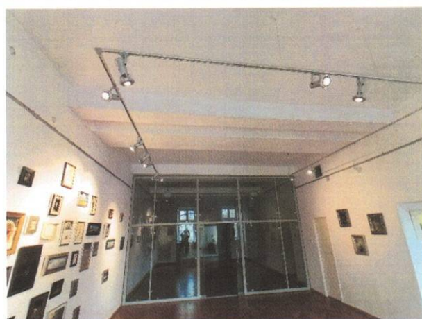
Fot. 3 Widok spodu stropu na parterze od strony okna
