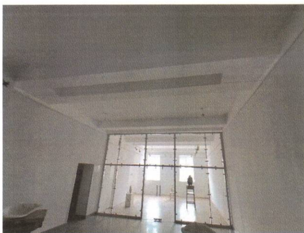
Fot. 1 Widok spodu stropu na parterze
