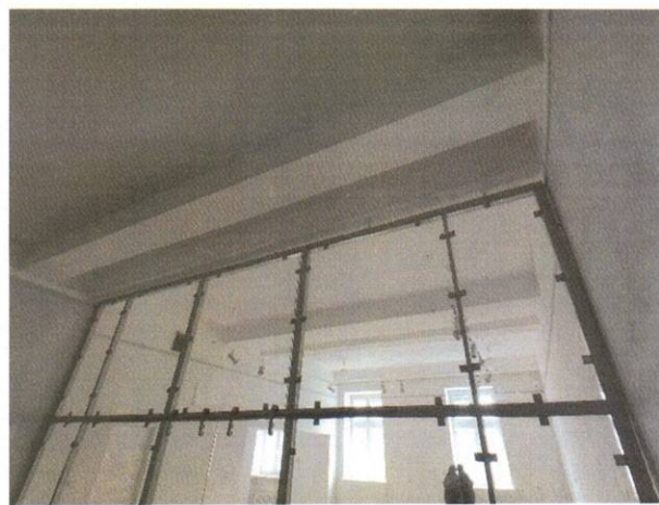
Fot. 2 Widok podciagu pod szklana przegrodą na parterze
