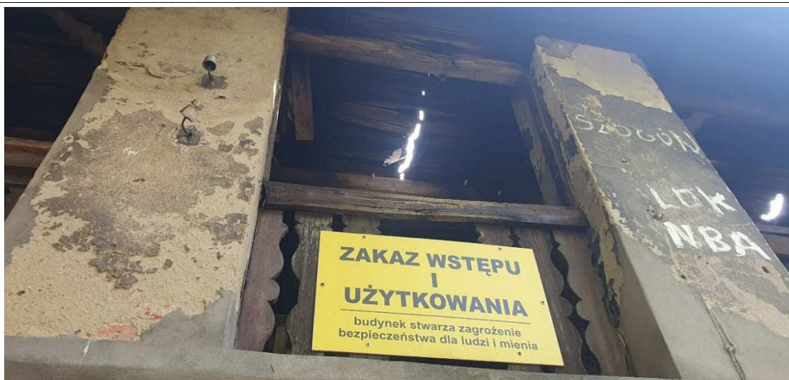
Fot. nr 5 – widok na piętro budynku gospodarczego prawej oficyny Targowa 14 – widoczne nieszczelności dachu
