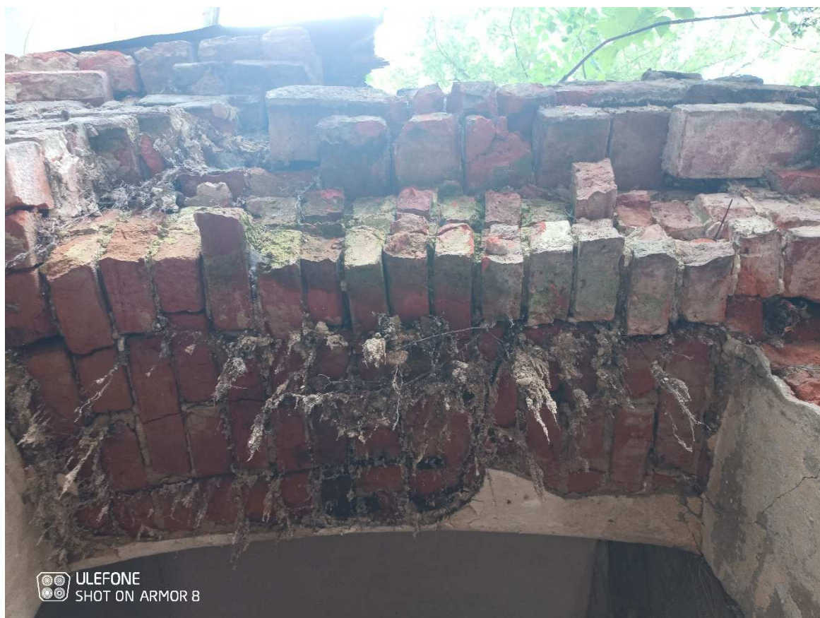
Fot. 7 Uszkodzone nadproże okienne.
