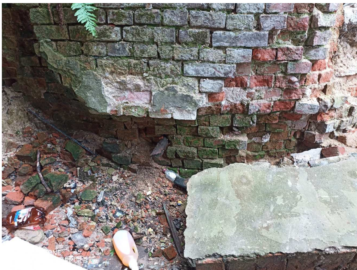
Fot. 2 Elewacja wschodnia – uszkodzenia muru w poziomie przyziemia.
