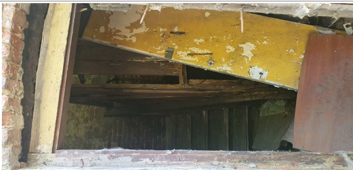
Fot. nr 3 – widok na zawaloną klatkę schodową prowadzącą na piętro budynku gospodarczego prawej oficyny Targowa 14
