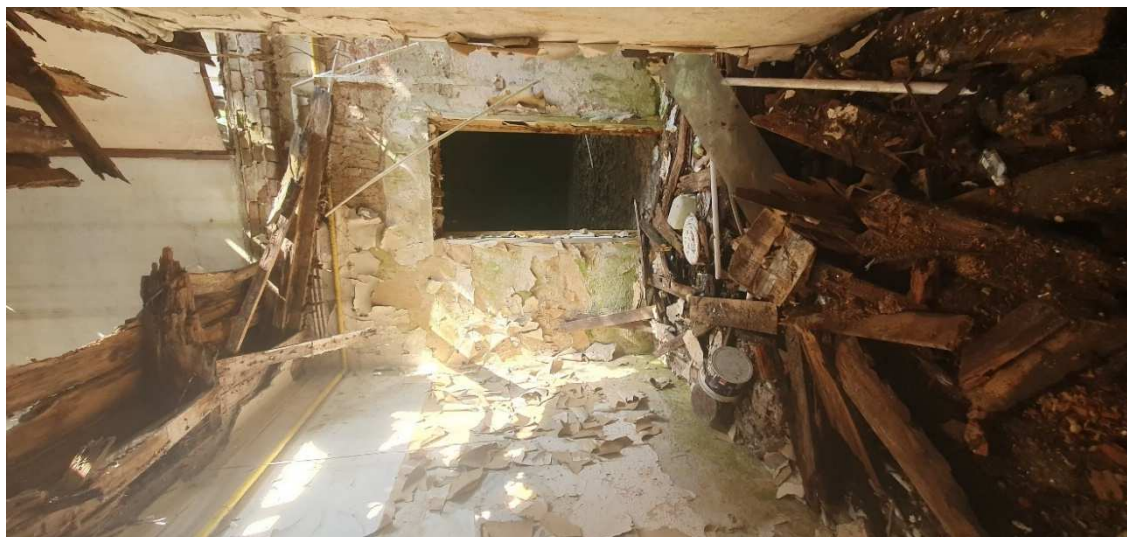
Fot. nr 1 – widok od środka budynku użytkowego – na zdjęciu widać zawalony strop drewniany
