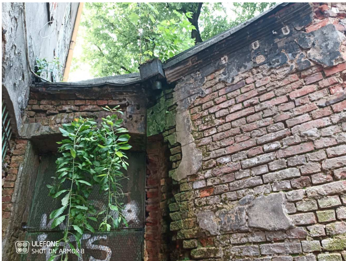
Fot. 4 Elewacja wschodnia – korozja i erozja cegły oraz zaprawy, brak rury spustowej, ubytki cegły..
