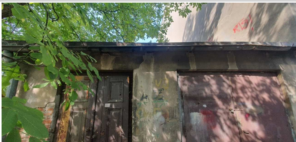
Fot. nr 5 – widok elewacji budynku gospodarczego lewej oficyny Targowa 14 – zarysowane nadproża, odspajające tynki itp.
