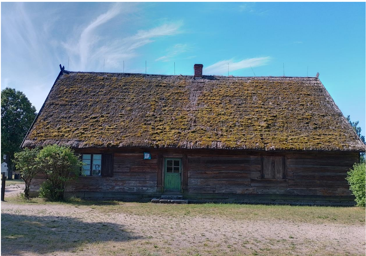
Fot. 2. Dworek ze Skwieraw, elewacja północna (fot. K. Oziębłowska, lipiec 2023 r.).
