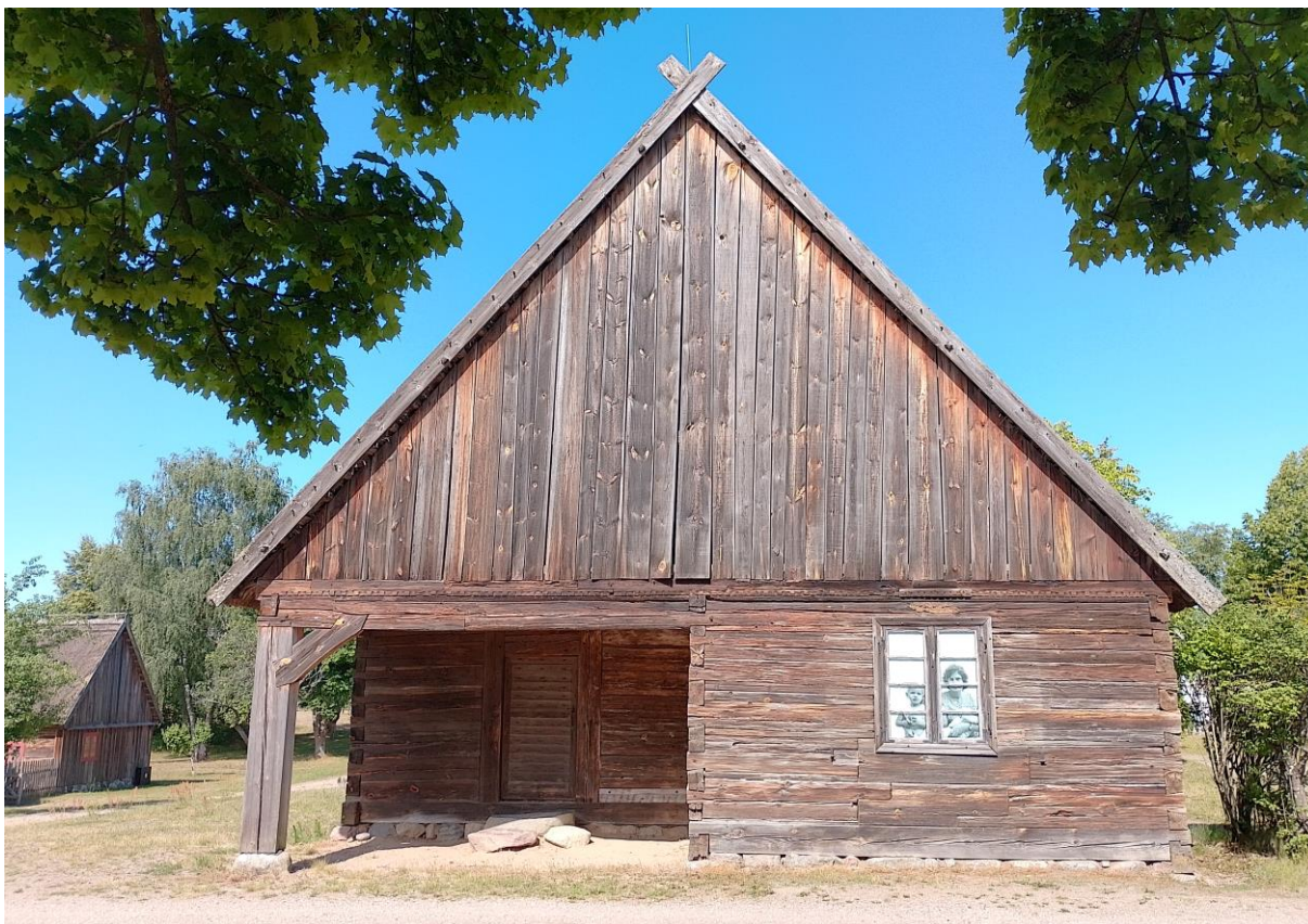
Fot. 3. Dworek ze Skwieraw, elewacja wschodnia (fot. K. Oziębłowska, lipiec 2023 r.).
