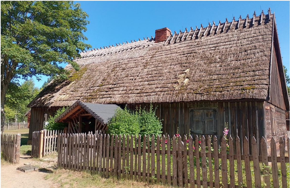
Fot. 1. Dworek z Trzebunia, elewacja południowa/frontowa (fot. K. Oziębłowska, lipiec 2023 r.).
