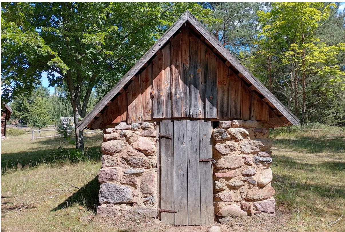
Fot. 3. Piec chlebowy, elewacja południowa/frontowa (fot. K. Oziębłowska, lipiec 2023 r.).
