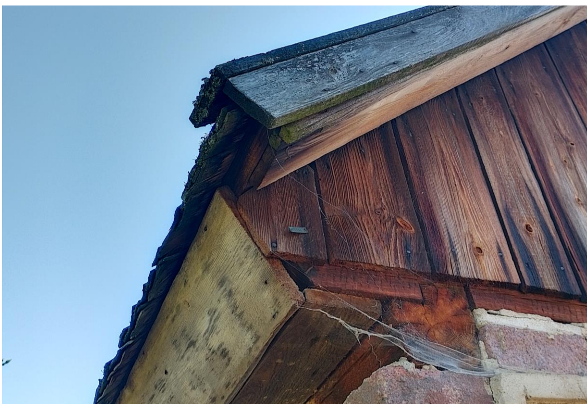
Fot. 6. Chlew z Szopy, elewacja południowa – detal zakończenia wiatrownicy (fot. K. Oziębłowska, lipiec 2023 r.).
