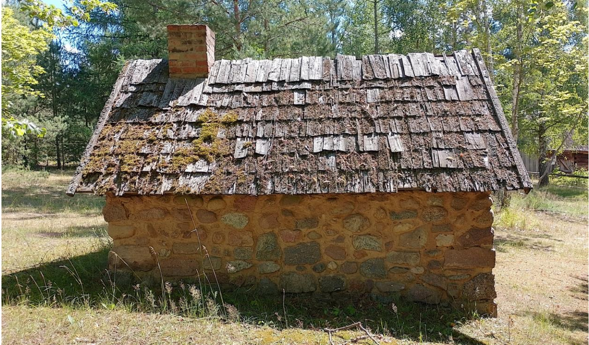
Fot. 1. Piec chlebowy, elewacja zachodnia (fot. K. Oziębłowska, lipiec 2023 r.).
