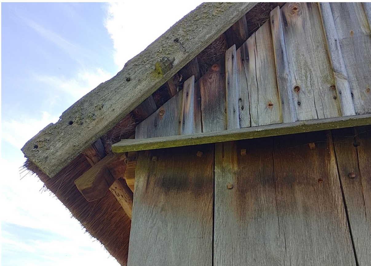
Fot. 5. Dworek ze Skwieraw, elewacja zachodnia – detal zakończenia wiatrownicy (fot. K. Oziębłowska, lipiec 2023 r.).
