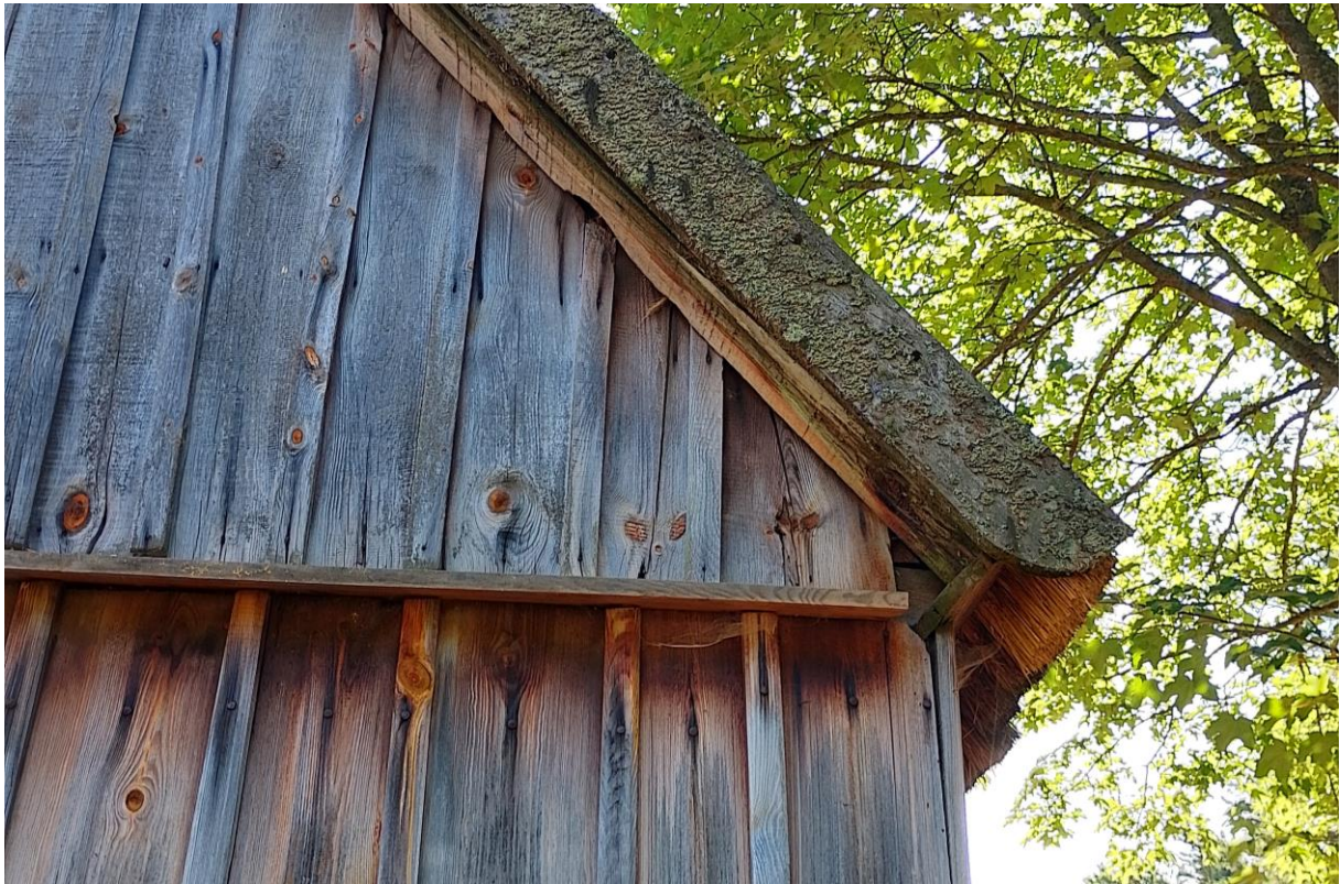
Fot. 5. Dworek z Trzebunia, elewacja zachodnia – detal zakończenia wiatrownicy (fot. K. Oziębłowska, lipiec 2023 r.).
