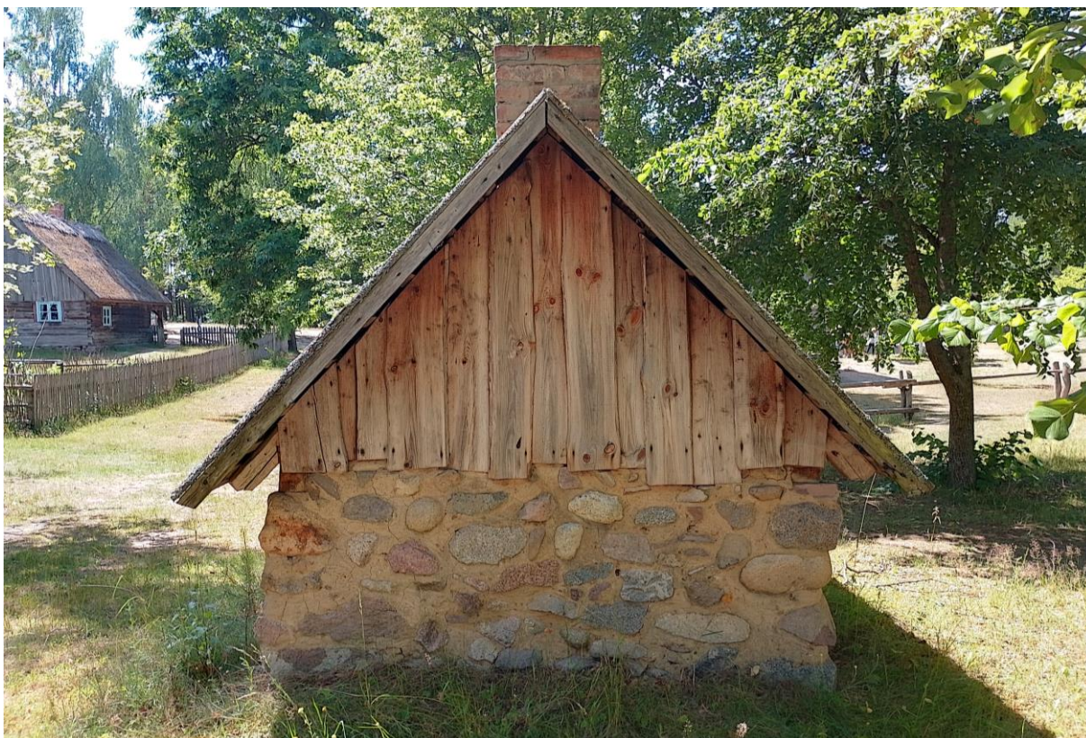
Fot. 4. Piec chlebowy, elewacja północna (fot. K. Oziębłowska, lipiec 2023 r.).
