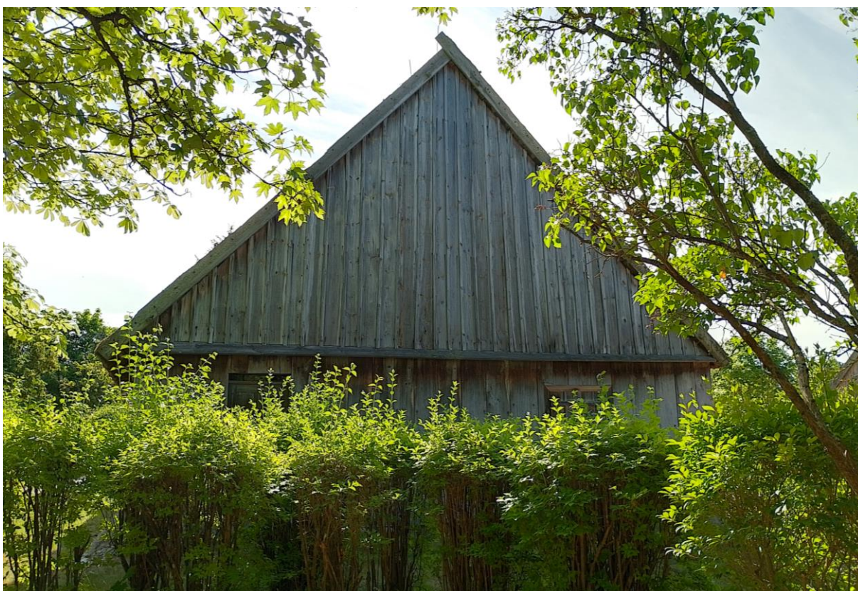
Fot. 4. Dworek ze Skwieraw, elewacja zachodnia (fot. K. Oziębłowska, lipiec 2023 r.).
