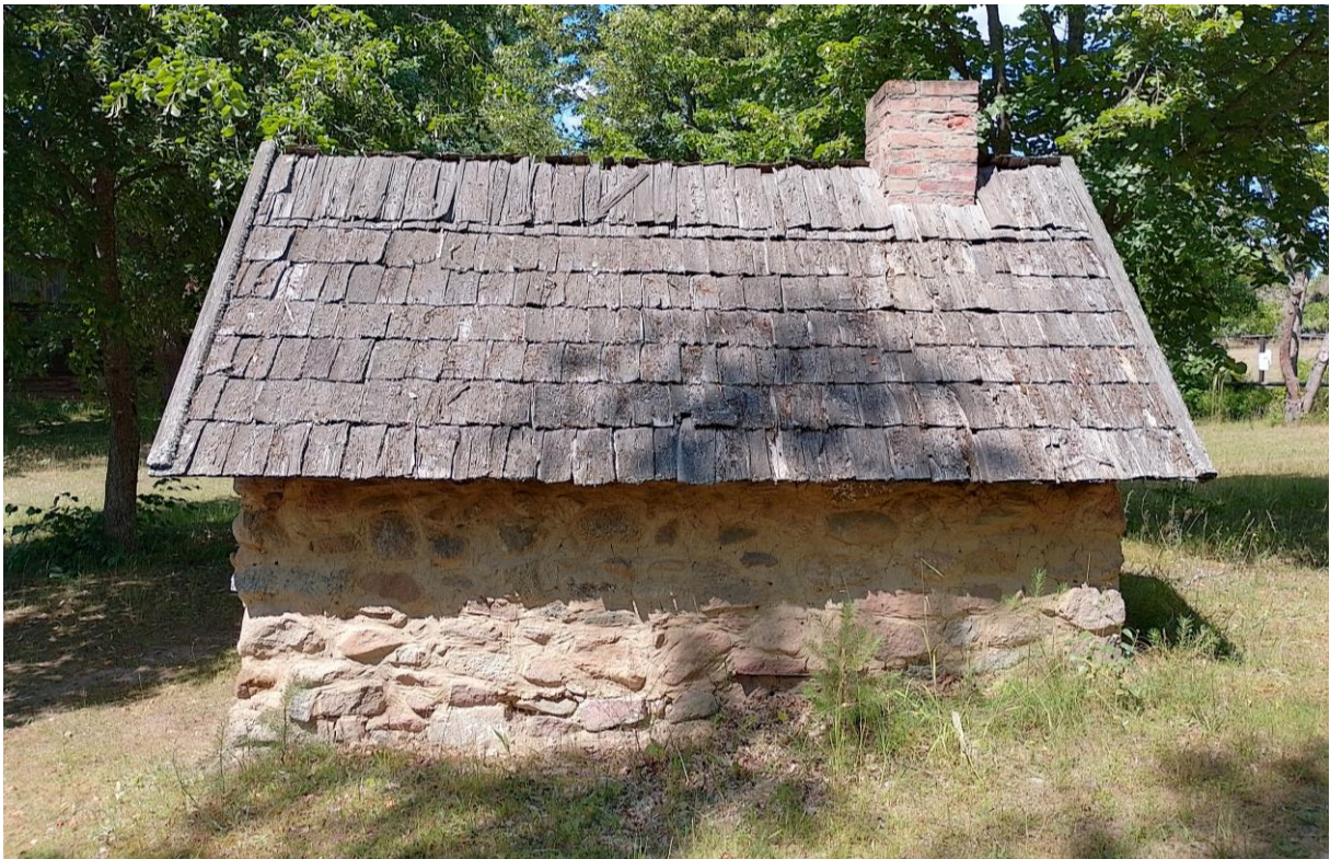
Fot. 2. Piec chlebowy, elewacja wschodnia (fot. K. Oziębłowska, lipiec 2023 r.).
