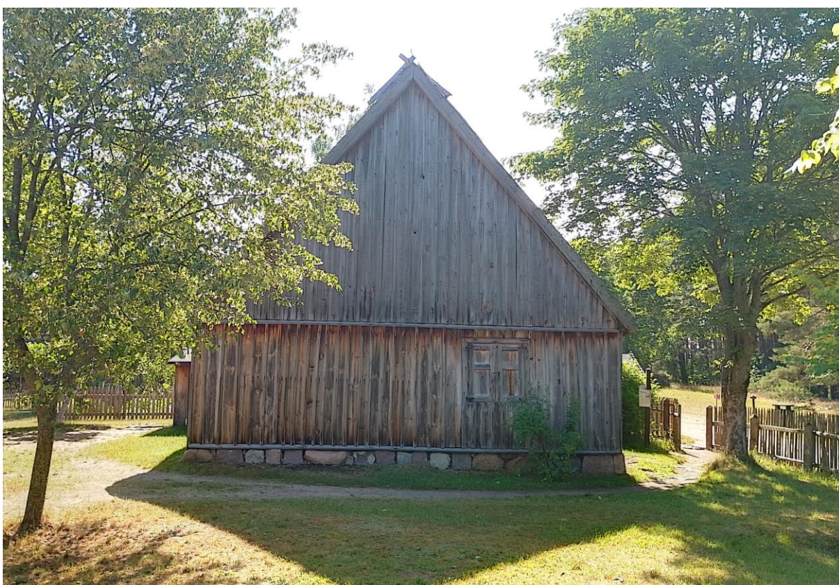
Fot. 4. Dworek z Trzebunia, elewacja zachodnia (fot. K. Oziębłowska, lipiec 2023 r.).
